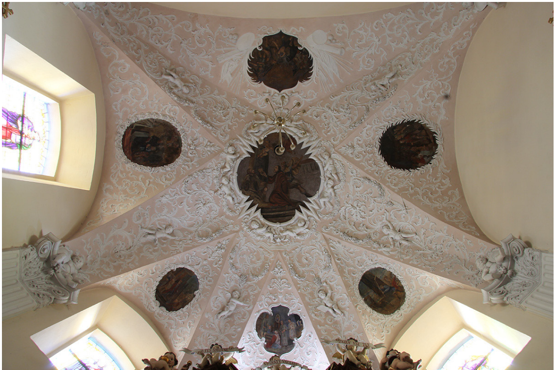
Obr. 03: Celkový pohled na nástropní malby v kapli sv. Václava směrem z hlavní lodi. Foto: Martina Poláková.
