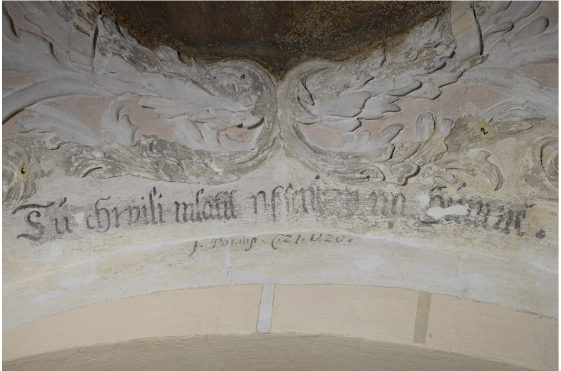
Obr. 57: Související nápis pod výjevem na klenbě. Stav po prefixáži, dočištění a vytmelení.
