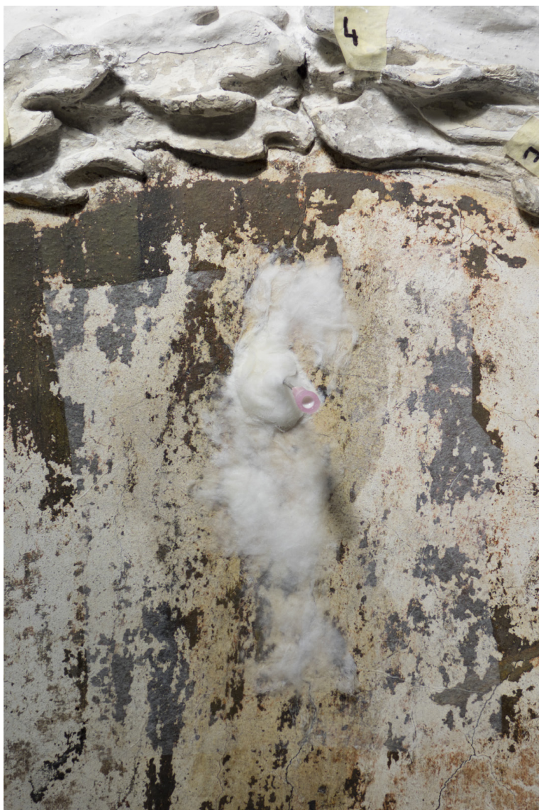
Obr. 43: Výjev na klenbě. Stav v průběhu injektáže.
