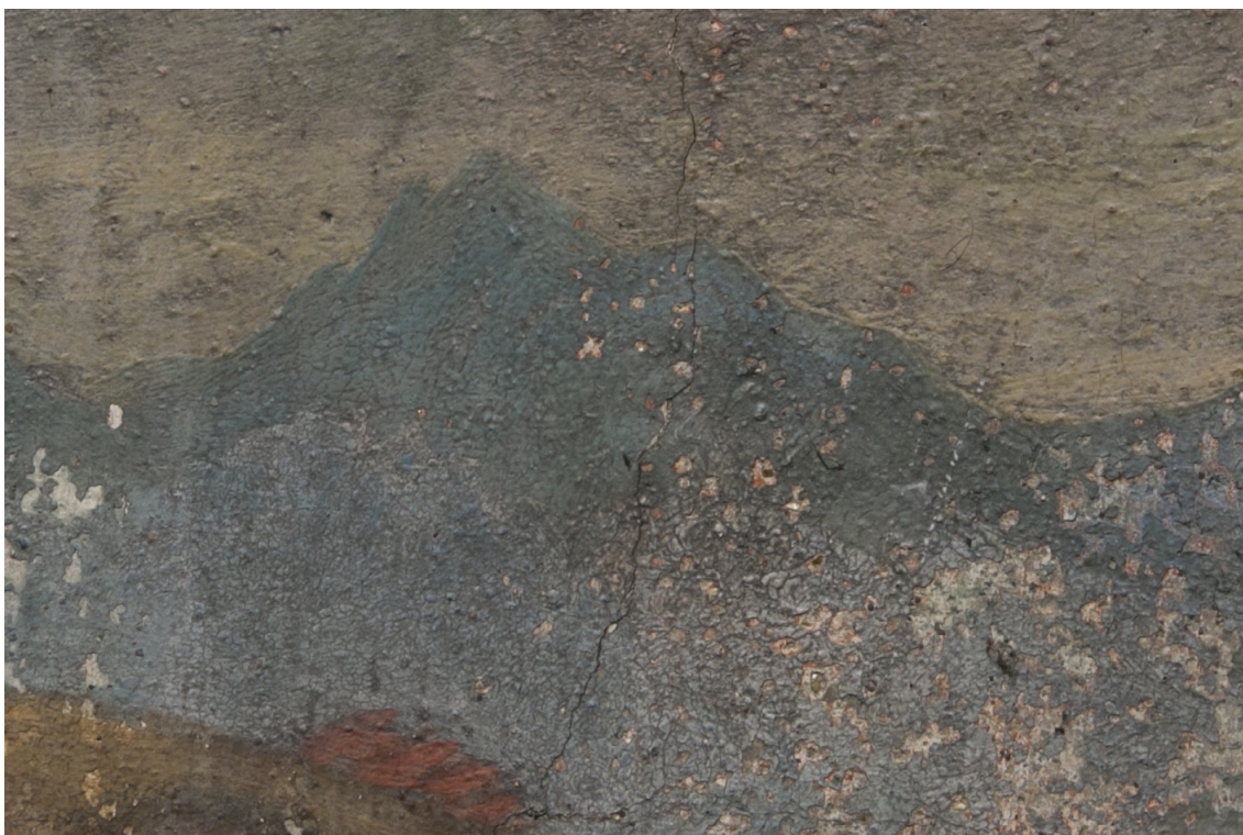
Obr. 28: Detail malby na klenbě: oblast pohoří na horizontu v levé části výjevu. Stav před restaurováním. Detail poškození: krakeláž a ztráta adheze původní barevné vrstvy s podkladem.
