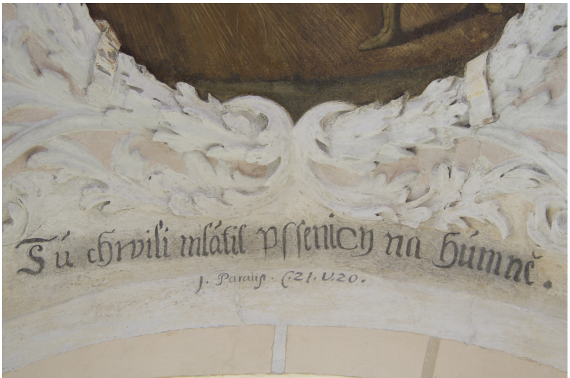
Obr. 58: Související nápis pod výjevem na klenbě. Stav po restaurování.
