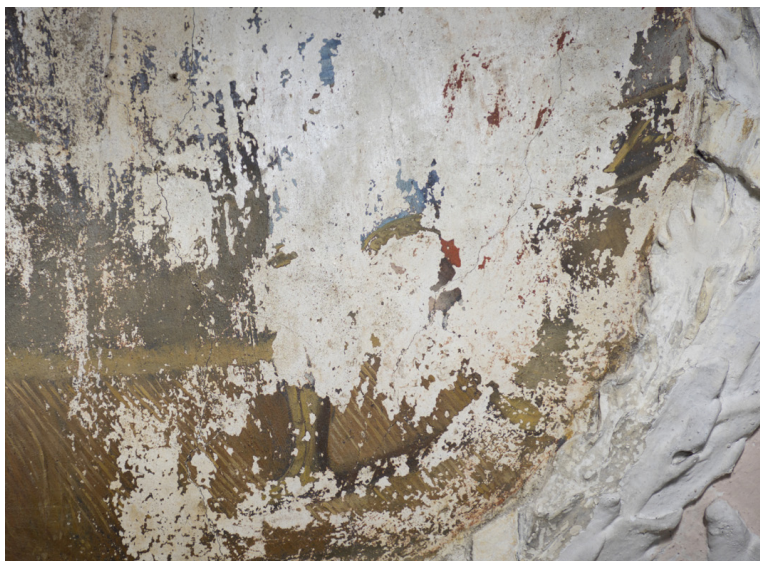
Obr. 51: Detail výjevu na klenbě: pravá spodní část výjevu. Nahoře: stav před restaurováním, dole: stav po očištění a sejmutí přemaleb..
