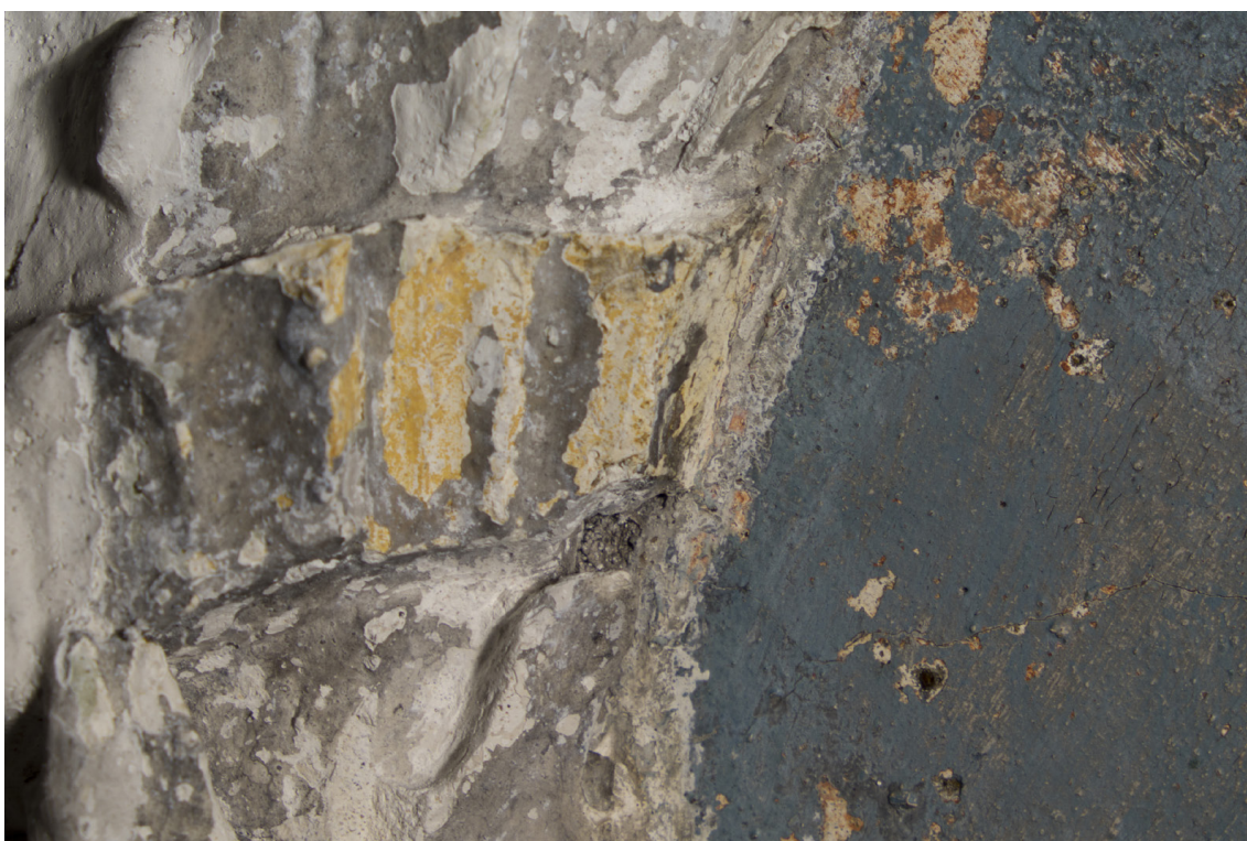
Obr. 29: Detail malby na klenbě: levá horní část výjevu v oblasti oblohy, rozhraní mezi malbou a štukem. Stav před restaurováním. Vápenné přetěry vzniklé při druhotných úpravách štuků zasahující do plochy malby.
