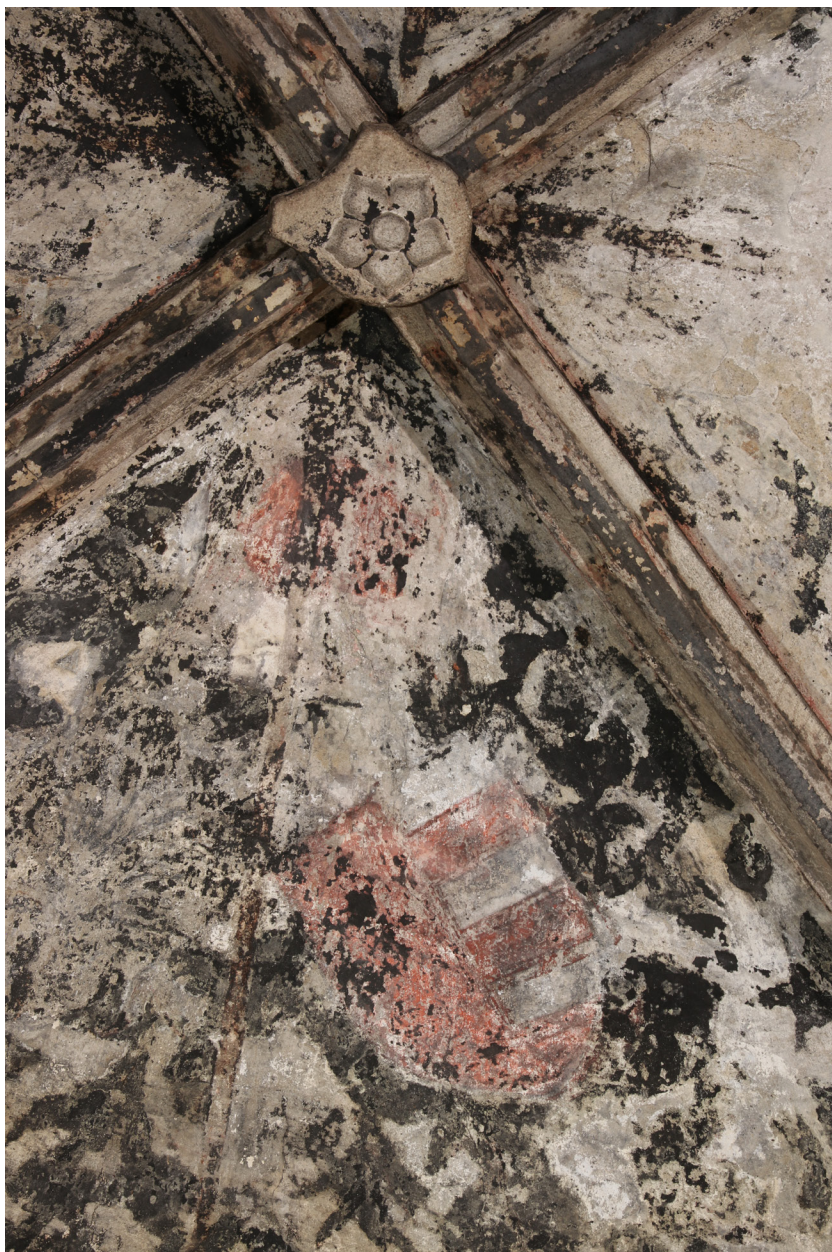
Obr. 45: Detail klenebního pole – stav dochování malovaných erbů a akantových rozvilin. Ztráta barevné vrstvy a znečištění sazemi.
