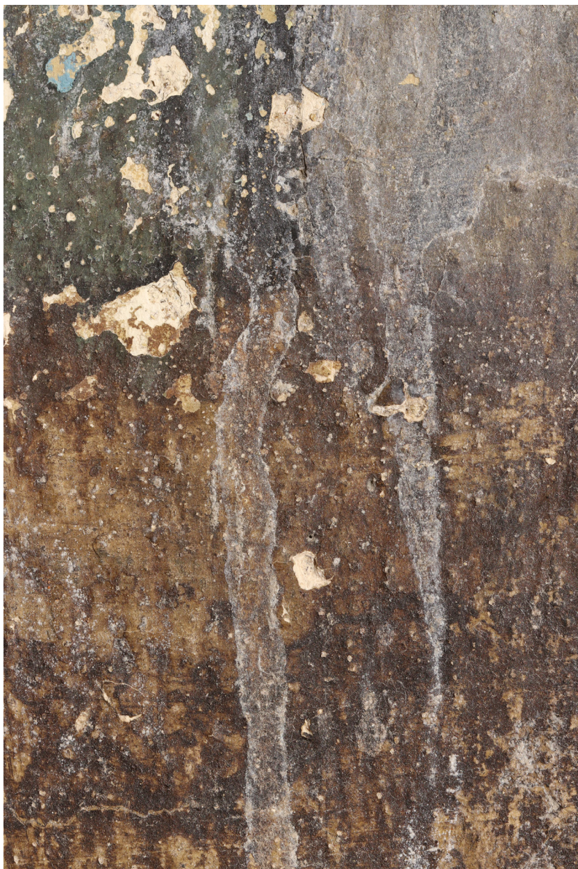
Obr. 11: Detail levé střední části jihovýchodní stěny – nesprávně usazený transfer.
