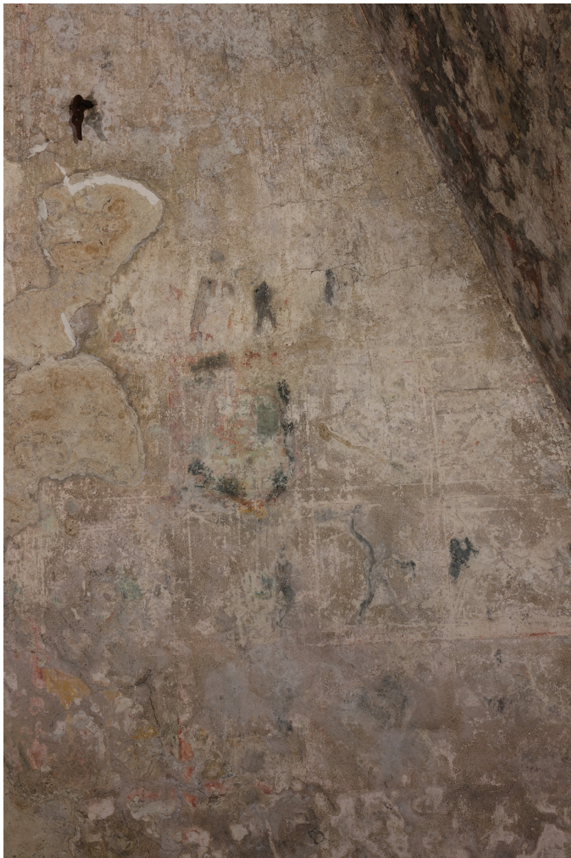
Obr. 36: Levá horní část severozápadní stěny – gázové přeplety a sejmutý transfer.
