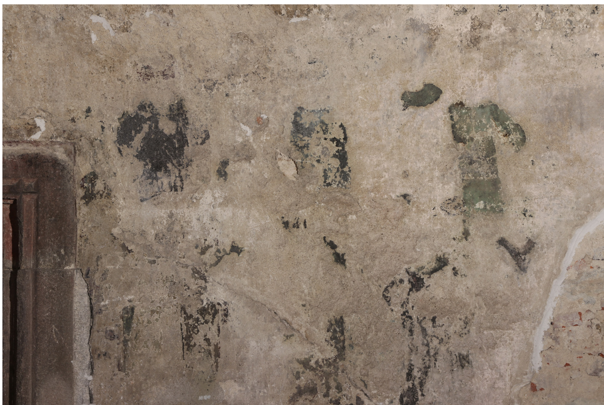
Obr. 02: Levá dolní část jihovýchodní stěny – vyobrazení postav.
