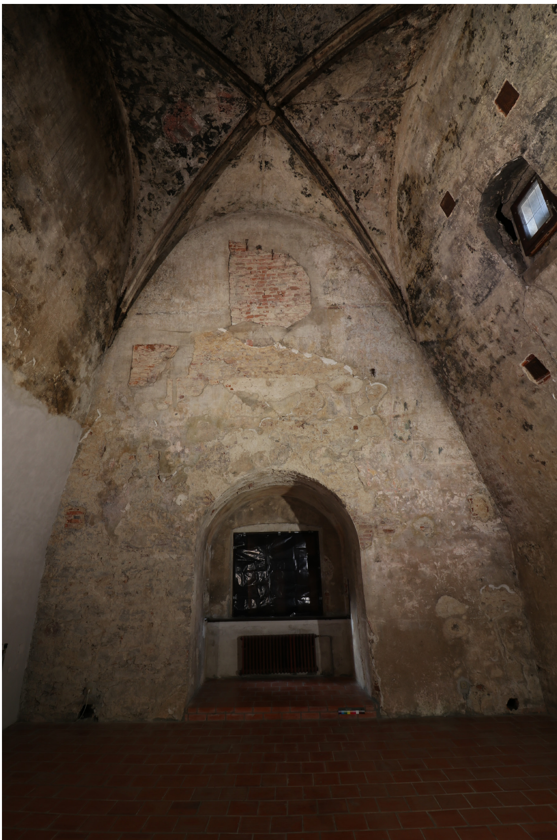
Obr. 34: Pohled na severozápadní stěnu – umělé bílé světlo.
