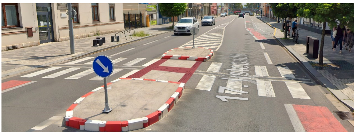
Obrázek 24 Druhý analyzovaný přechod pro chodce v ulici 17. listopadu se zakomponovanou navrhovanou úpravou (Google, 2025a, upraveno autorem)
