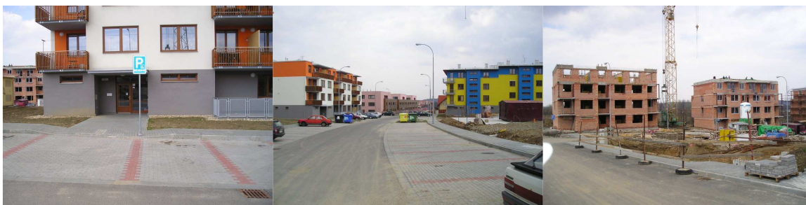
Obr.29 Bezbariérová úprava Kainarova, Ortenova,F.X.Šaldy Zdroj: fotodokumentace příloha č.5
