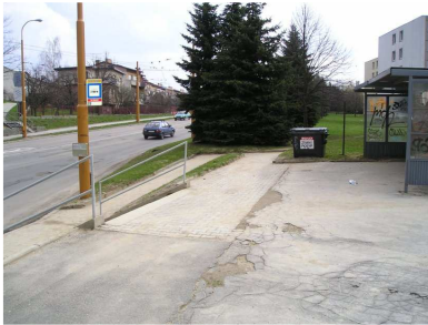
Obr.18 Zastávka U břížek Zdroj: fotodokumentace příloha č.5
