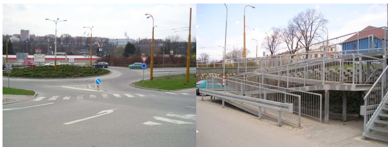
Obr.26 Úprava ulic Rovná, Peckova, Sokolovská, Romana Havelky pro přístup k obchodnímu centru Zdroj: fotodokumentace příloha č.5
