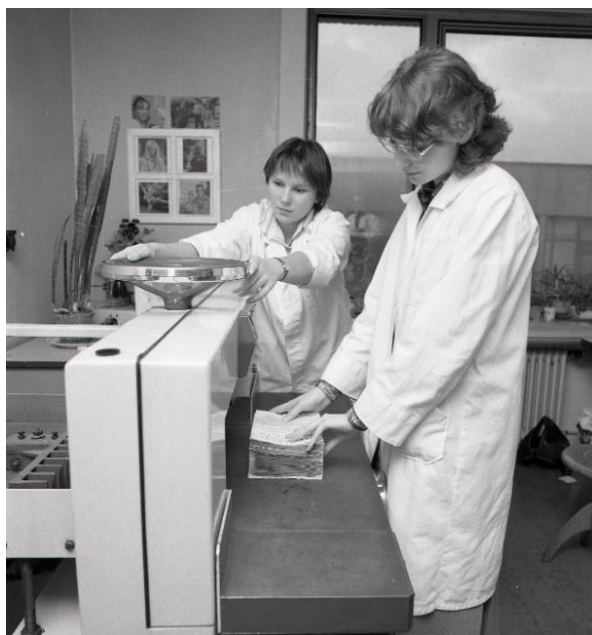
obr. 57 Orezávanie oriezok reštaurovaného knižného bloku v SNK (zdroj: archív TASR)
