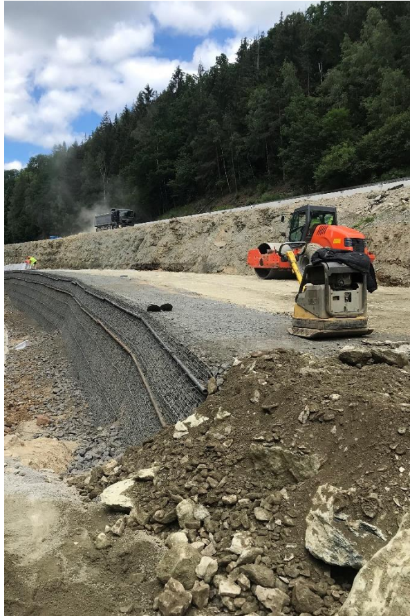
Obrázek 23: Hutníci stroje použité při výstavbě armovaného svahu
