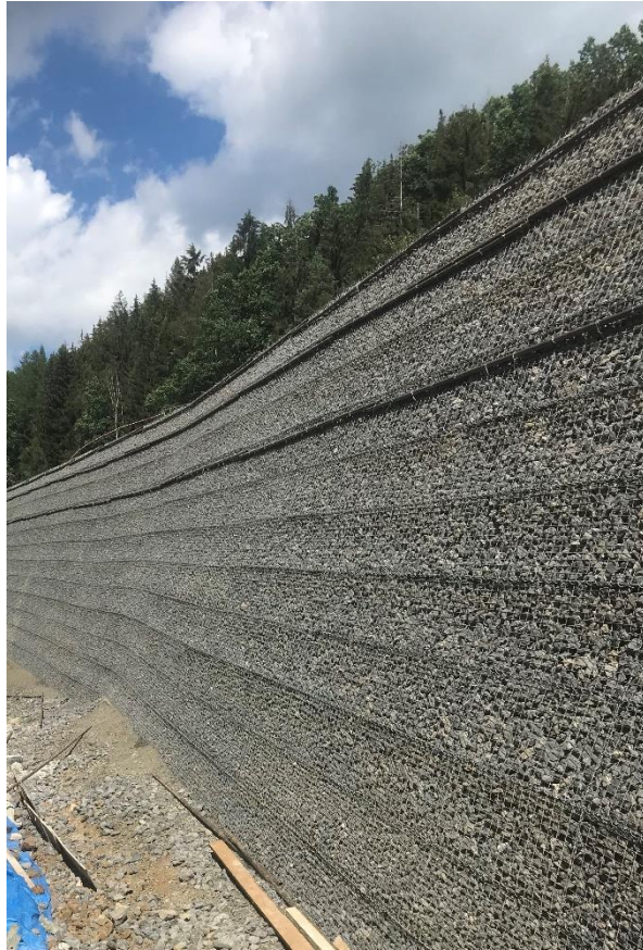
Obrázek 25: Pohled na armovaný svah před dokončením poslední vrstvy
