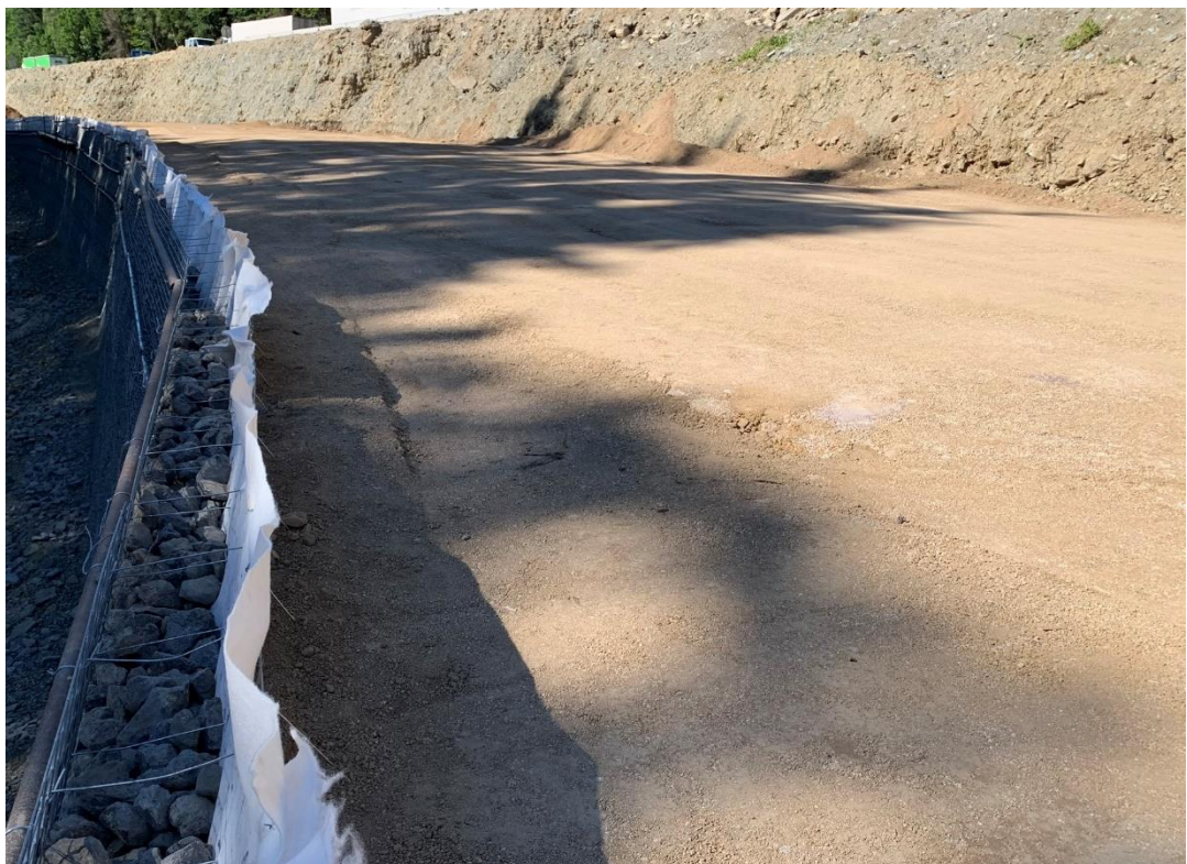
Obrázek 21: Postupné vrstvení a hutnění jednotlivých etází
