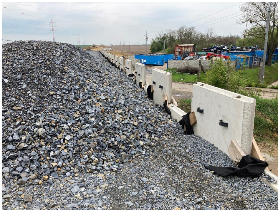
Obrázek 26: Zajištění polohy panelů svorkami a postupné hutnění po vrstvách
