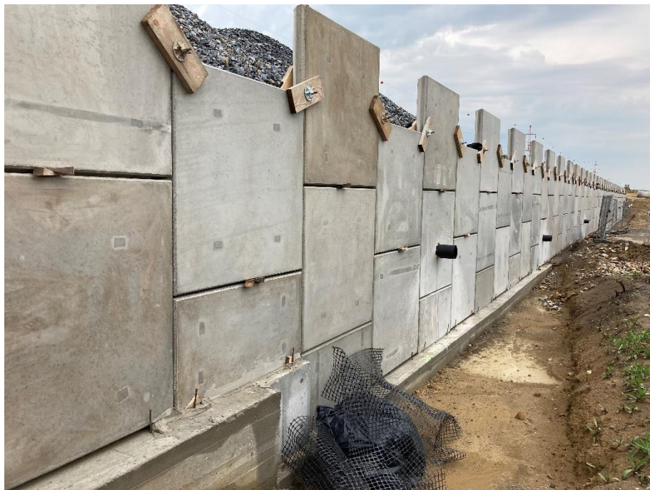
Obrázek 24: Postupné kladení panelů na betonový základ
