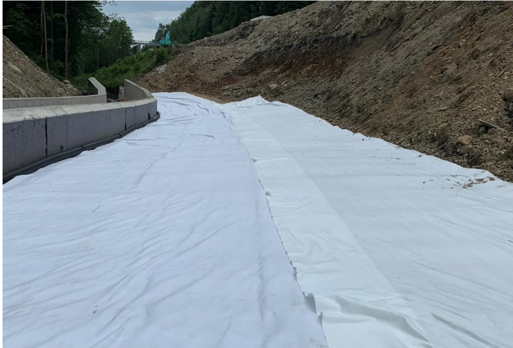
Obrázek 20: Ochráněná základová spára separační geotextilií
