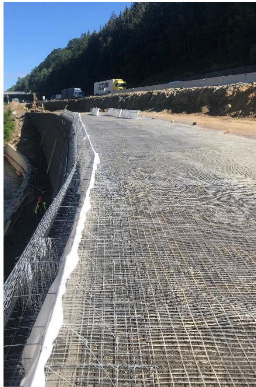
Obrázek 22: Příprava nové vrstvy armovaného svahu
