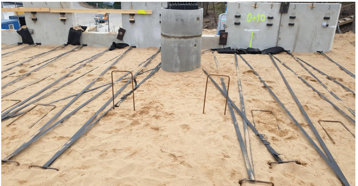
Obrázek 18: Kladení panelů, zajištění pozice a ochrana spár
