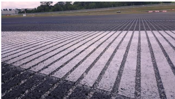
Obrázek 4: Drážkování vozovky
