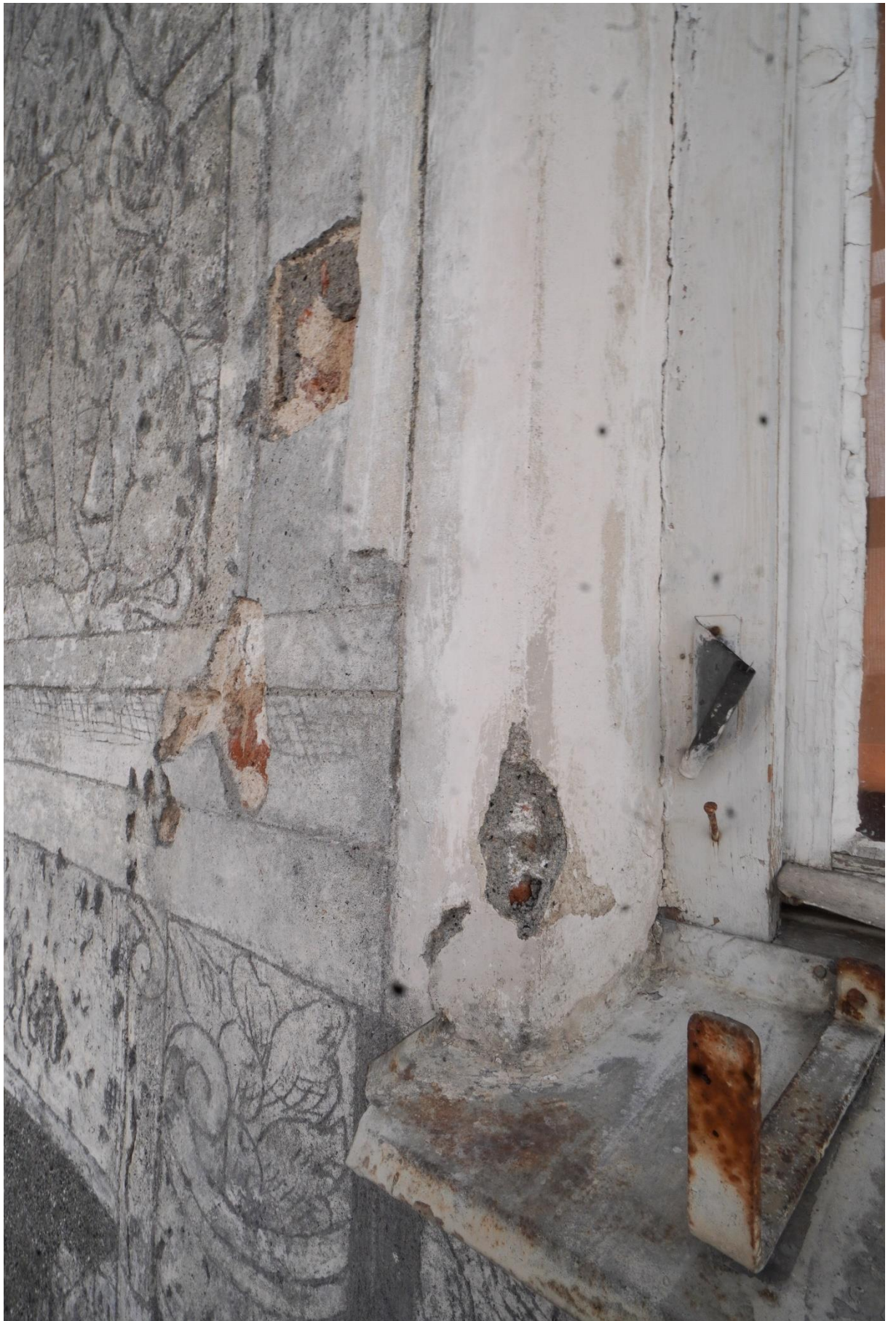
Obr. 34. Odstranění poškozené části okenního ostění.
