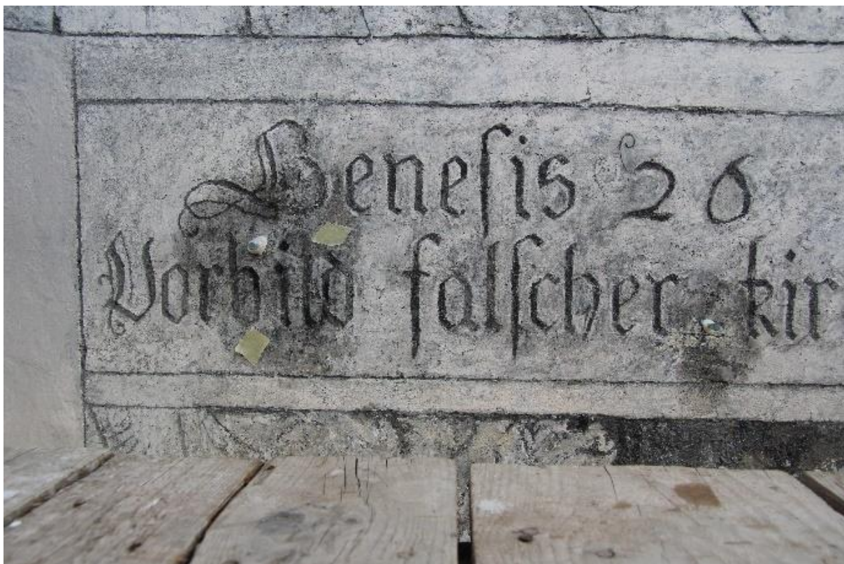
Obr. 28. Průběh injektáže. Nápisová páska výjevu č. 26.
