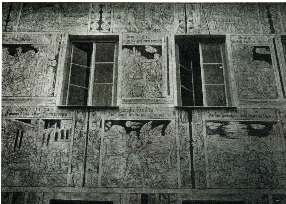
4 Slavonice, dům čp. 108, detail průčelí po odkrytí a restaurování sgrafitové výzdoby s výjevy z Genese. Sklonek 16. st. Snímek M. Kolář
