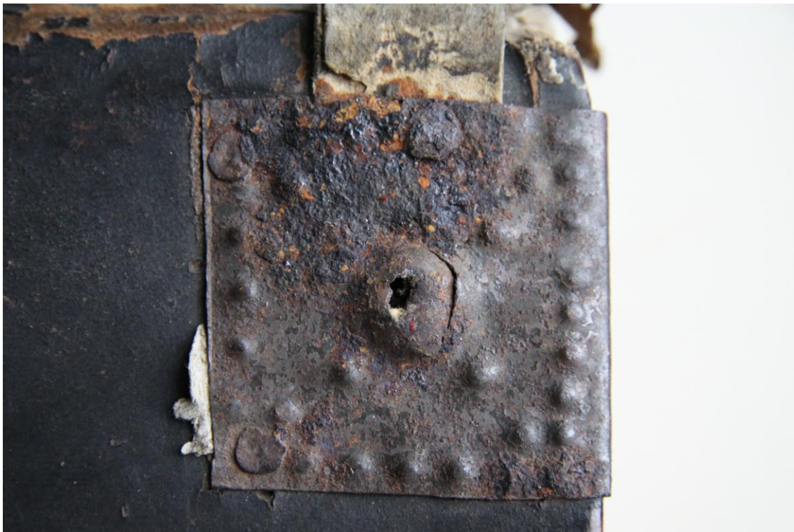
Obr. č. 37 – detail nárožnice ukotvené u spodní hlavice na zadní desce – stav před restaurátorským zásahem
