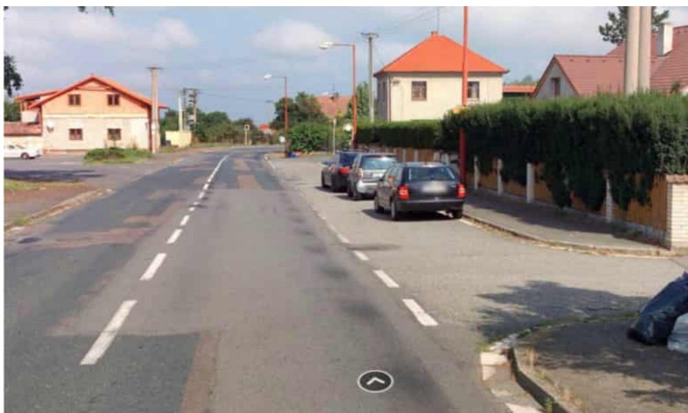
Obrázek 9 Zpevněná krajnice (parkovací záliv) – autobusová zastávka [24]
