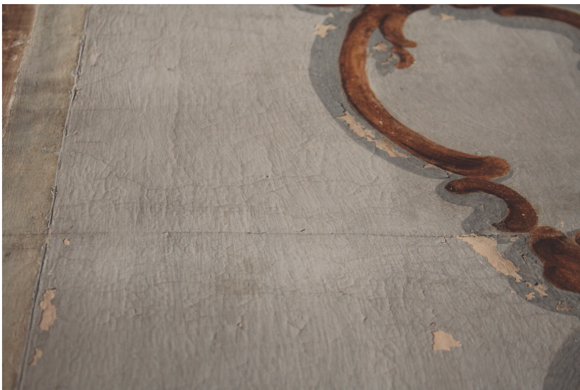
Obr.37 Detail poškození – krakeláž a odlupování se barevné vrstvy.
