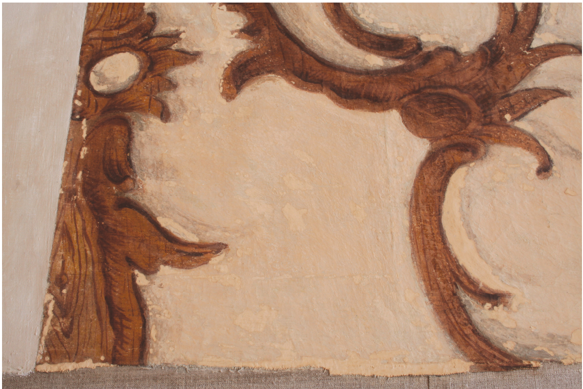
Obr.61 Detail po vytmelení defektů.
