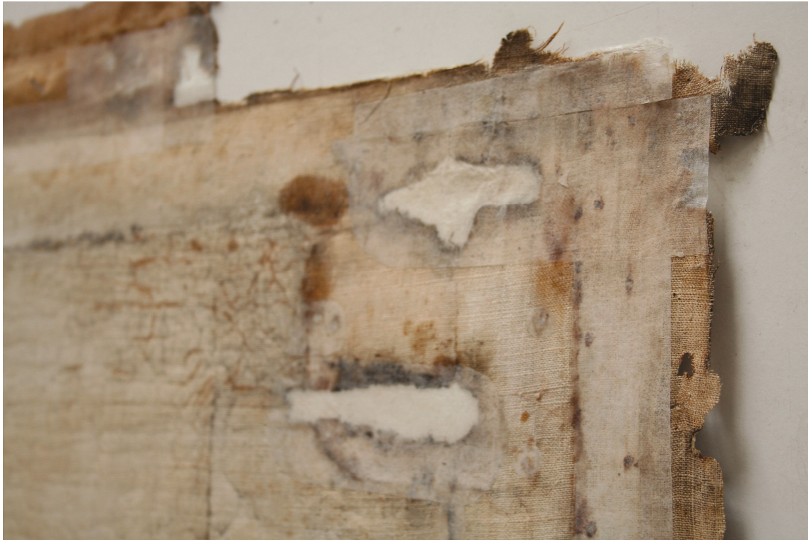
Obr.28 Stav během restaurování – zajištění trhlin holytexovými pásky.
