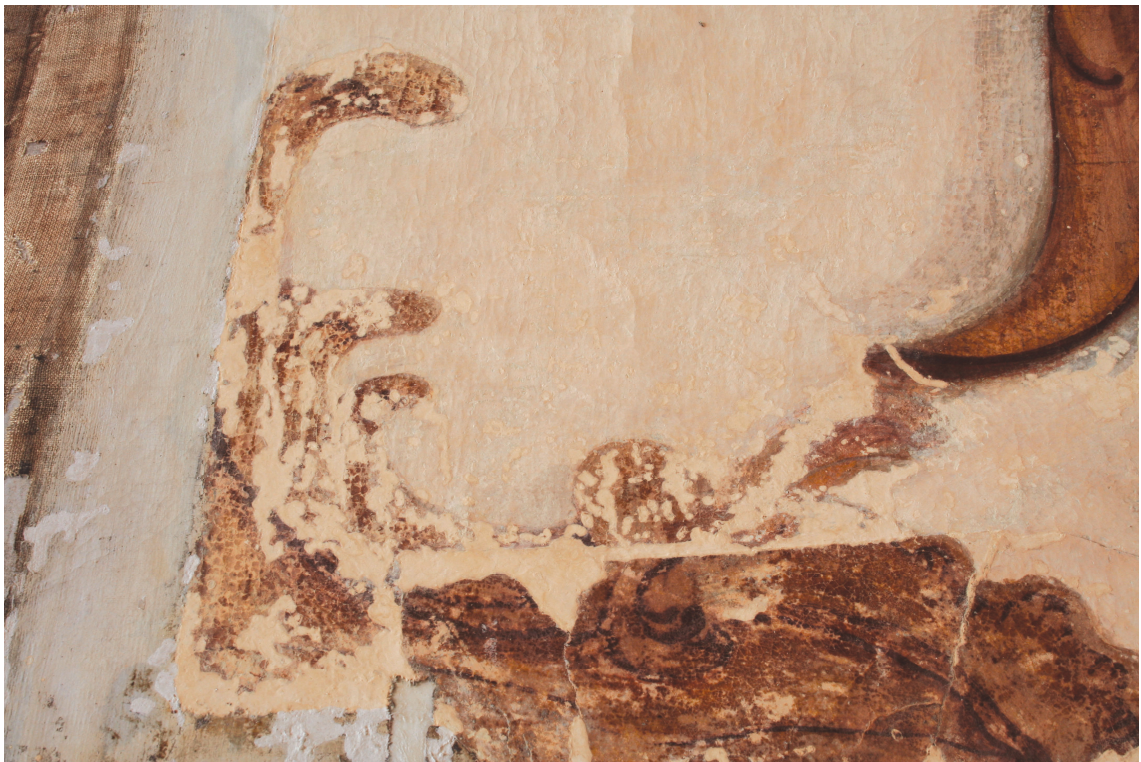
Obr.65 Detail po vytmelení defektů.
