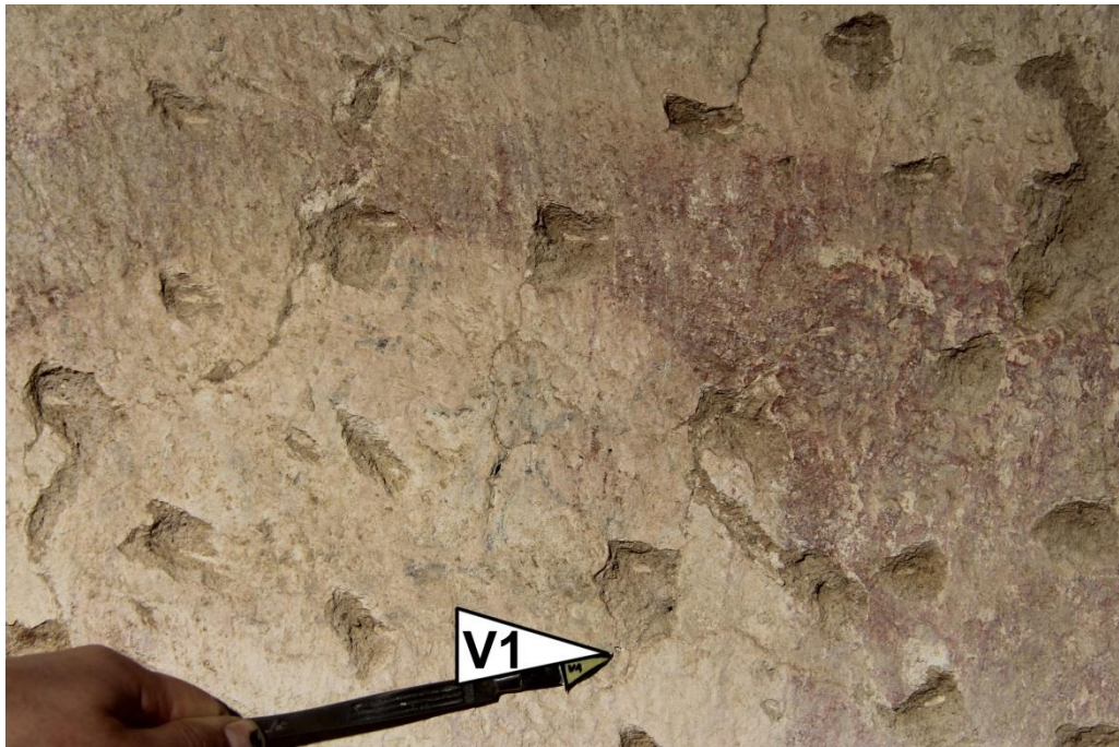
Obr. 69 Severní stěna hlavní lodi kostela, V1, detail. Odběr z nástěnné malby sv. Markéty (koruna svěťce). Fotografie v rozptýleném osvětlení.
