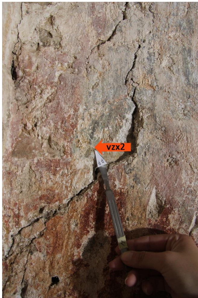
Obr. 76 Severní stěna hlavní lodi kostela, vzorek Vzx2, detail.
