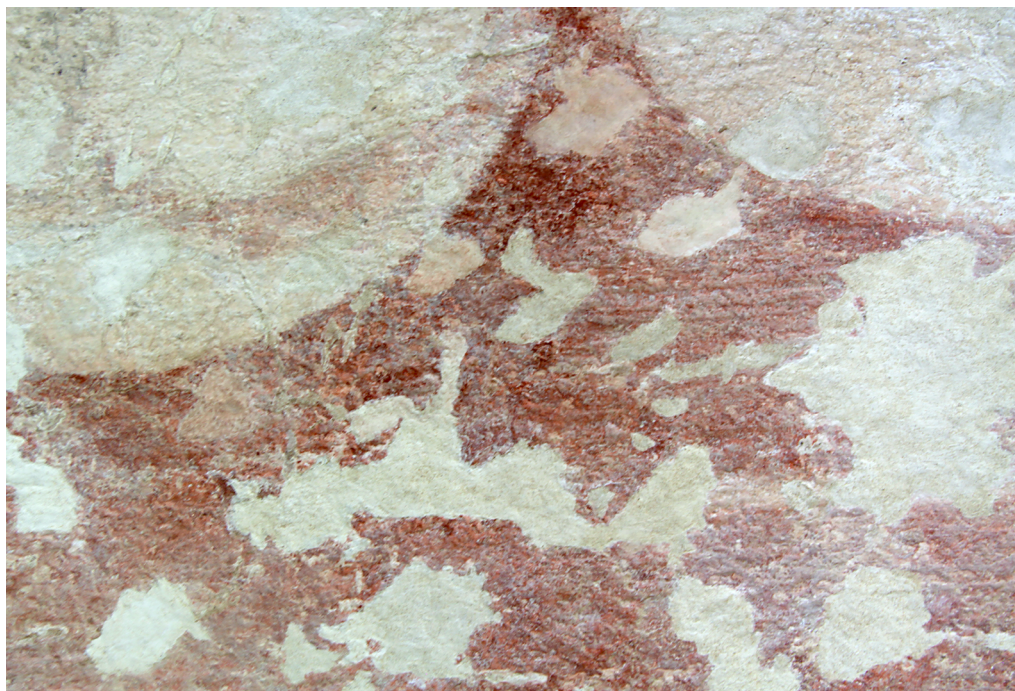
Obr. 33 Severní stěna, postava sv. Markéty (detail), zkoušky retuše.
