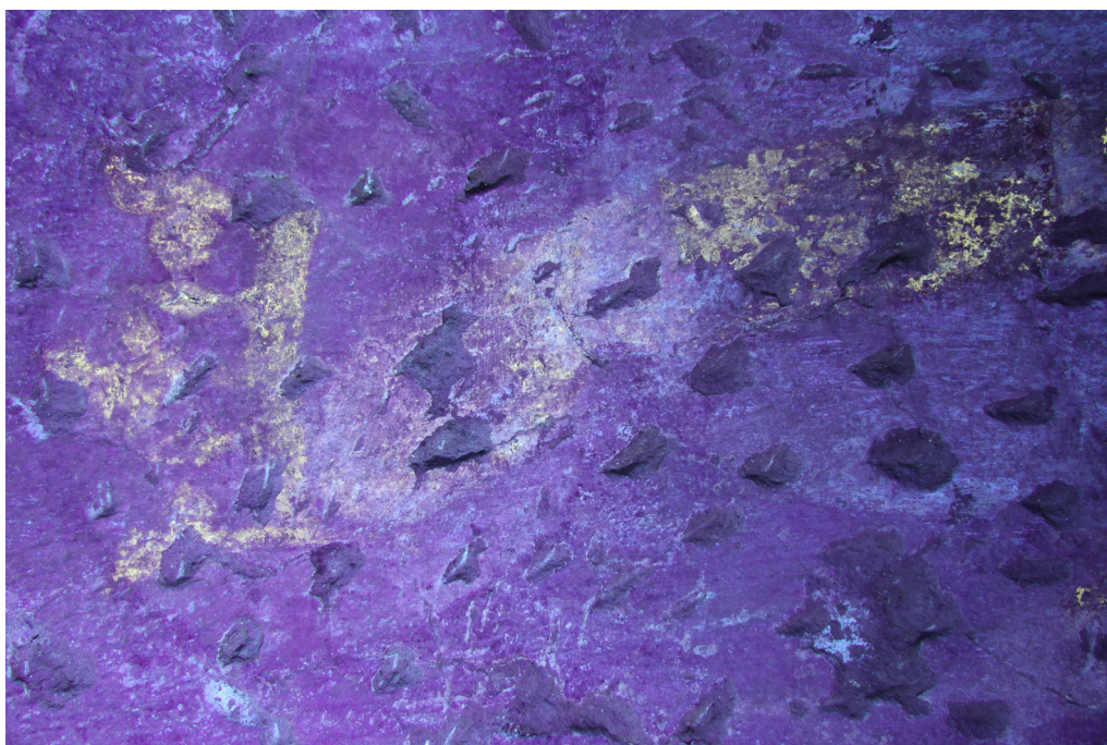
Obr. 23 Severní stěna, UV fluorescenční snímek - režim WB AUTO, oranžová fluor. (svatozář) a modrá fluor. (fragменты překryvných vápenných nátěrů). Stav před restaurováním.
