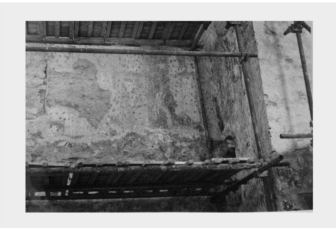
Obr. 4 Severní stěna kostela při levé stěně vítězného oblouku, výjev se sv. Markétou (detail), historická fotografie (1976), foto: Jiří Toroň.
