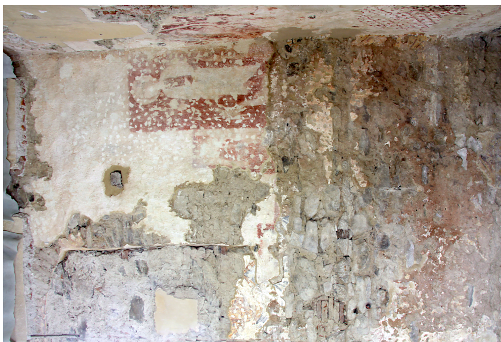
Obr. 34 Severní stěna, celkový pohled, stav po vytmelení.
