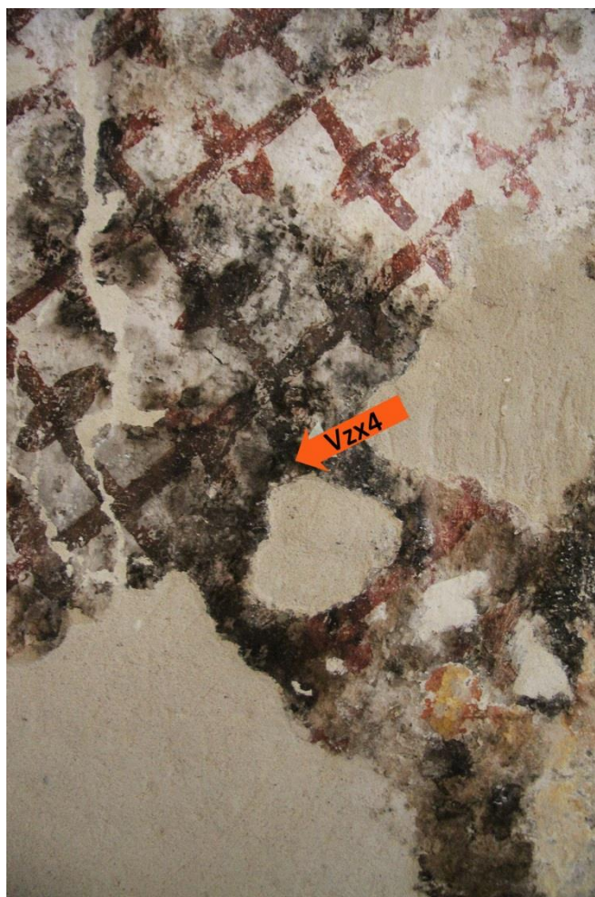
Obr. 80 Severní stěna hlavní lodi kostela, vzorek Vzx4, detail.
