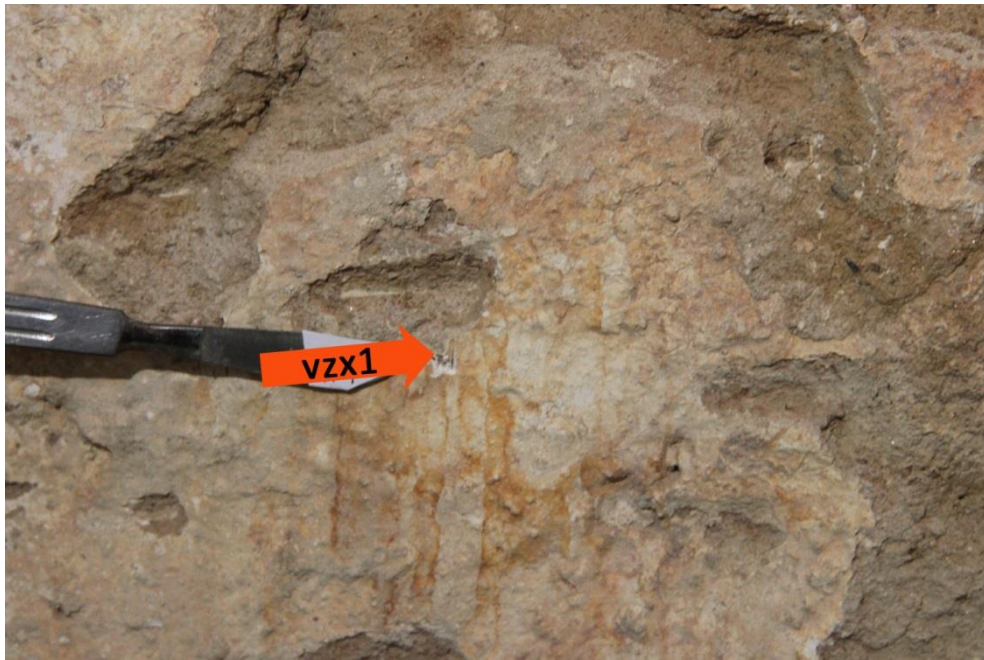
Obr. 75 Severní stěna hlavní lodi kostela, vzorek Vzx1, detail.
