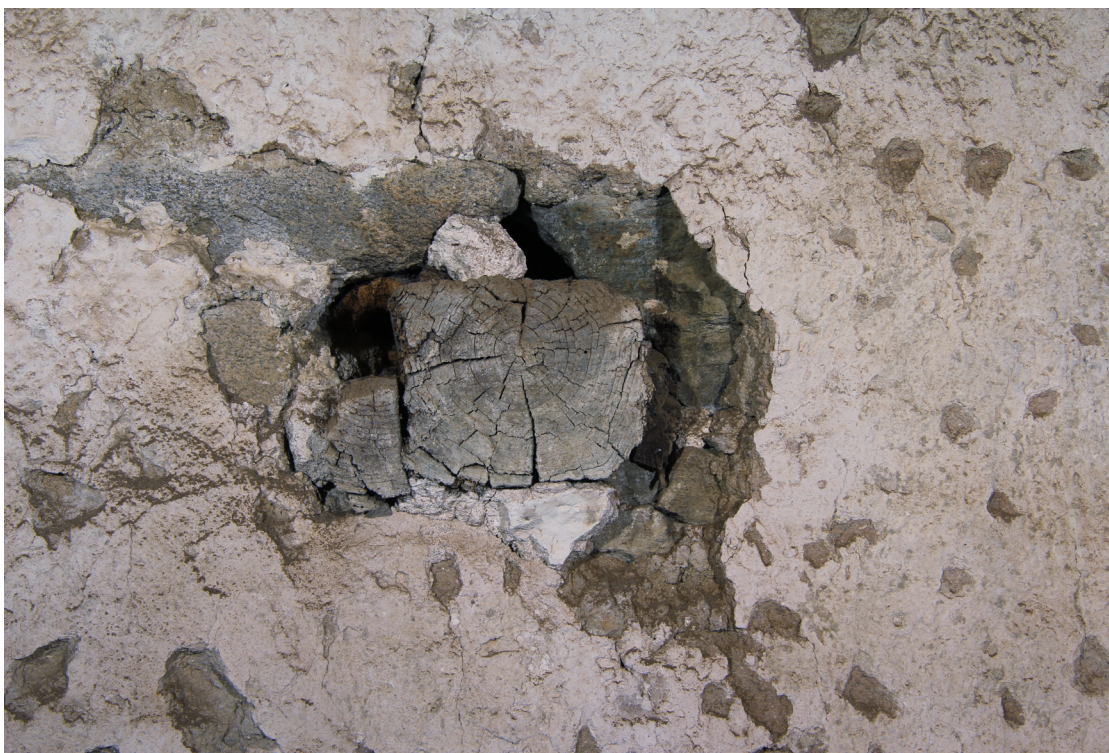
Obr. 13 Severní stěna lodi kostela při vítězném oblouku, dřevěná konzole, stav před restaurováním.
