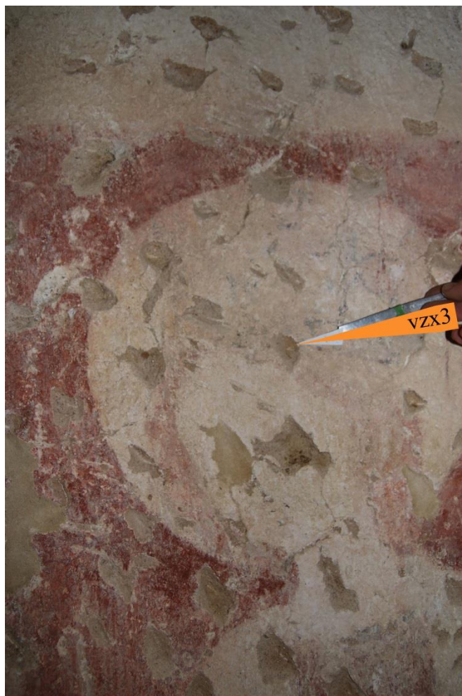
Obr. 77 Severní stěna hlavní lodi kostela, vzorek Vzx3, detail.
