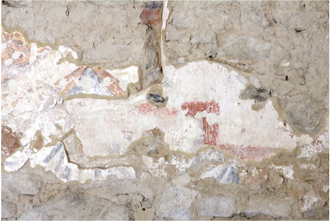
Obr. 41 Severní stěna, fragmenty barokních a gotických vrstev (detail), stav po vytmelení.
