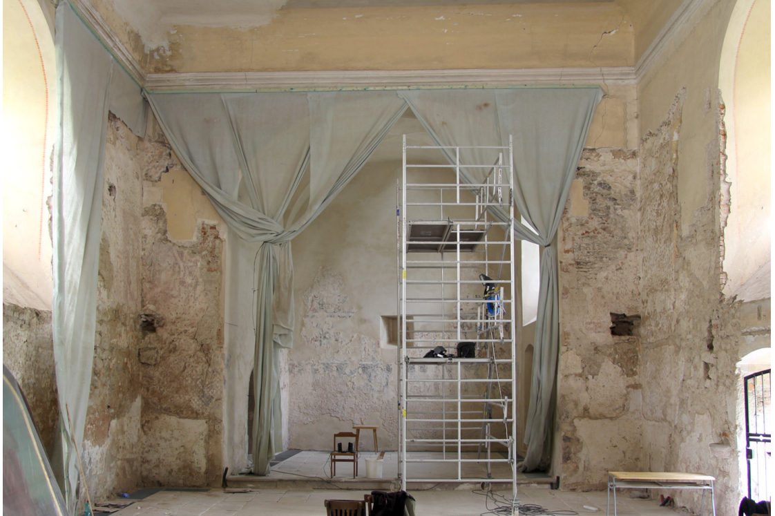
Obr. 6 Celkový pohled, interiér kostela, stav před restaurováním.
