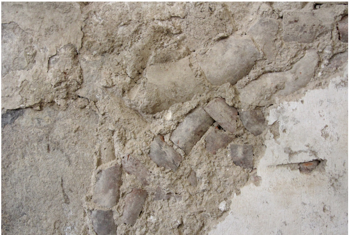
Obr. 26 Odstraňování plenty na severní stěně lodi kostela, detail. Pro plentování byly druhotně použity pálené cihly a prejzy.
