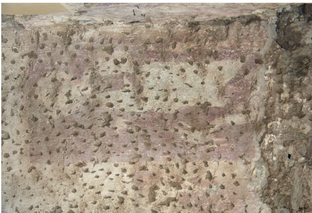
Obr. 15 Severní stěna (detail), postava sv. Markéty, stav před restaurováním.
