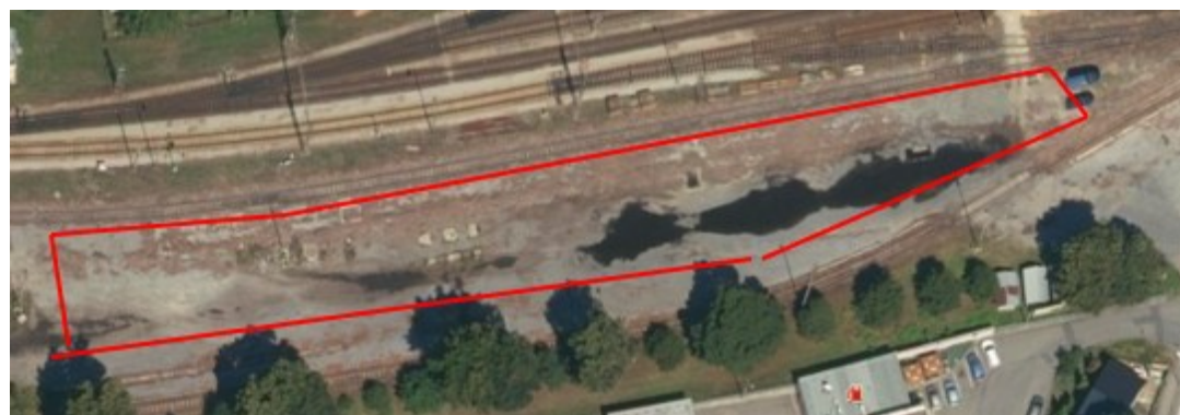
Obr. 23: ŽST Jindřichův Hradec prostor k nakládce
