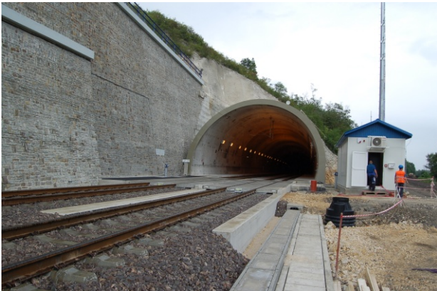
Fig. 6. An entrance of Turecký Vrch railway tunnel (Metroprojekt)
