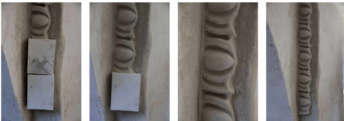
Obr. 33 Ukázka vytlačovaného dekoru vytvořeného otiskem formy zhotovené 3D tiskem, foto: Zdeněk Kovářík.
