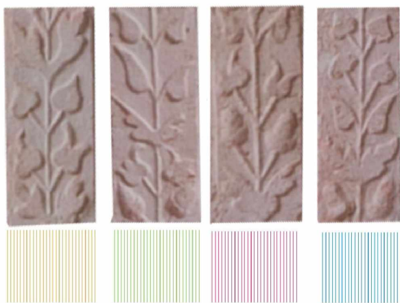
Obr. 53 Systém skládání forem na klenbách, každý klenební pás je ve vrcholu rozdělen a na každé straně je rytmus kladení ornamentu odlišný, foto a grafická úprava: Vojtěch Krajíček.
