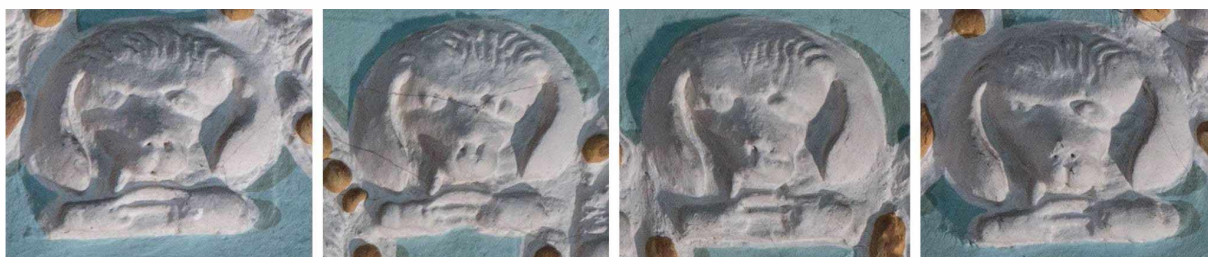
Obr. 12 Běhařovice, kostel Nejsvětější Trojice, detail otisků beránčích hlaviček okolo rámu v presbytáři. Na otiscích jsou patrné odlišnosti a sekundární úpravy po sejmutí formy, foto: Vojtěch Krajíček.
