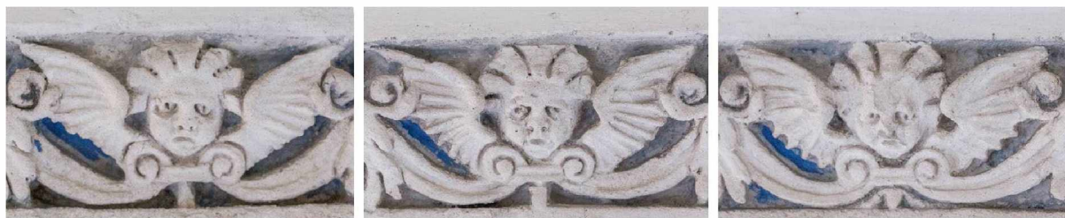
Obr. 17 Zámek Bučovice, Císařský sál, detail otisků s motivem netopýra, patrné korekce po otištění formy, foto: Vojtěch Krajíček.
