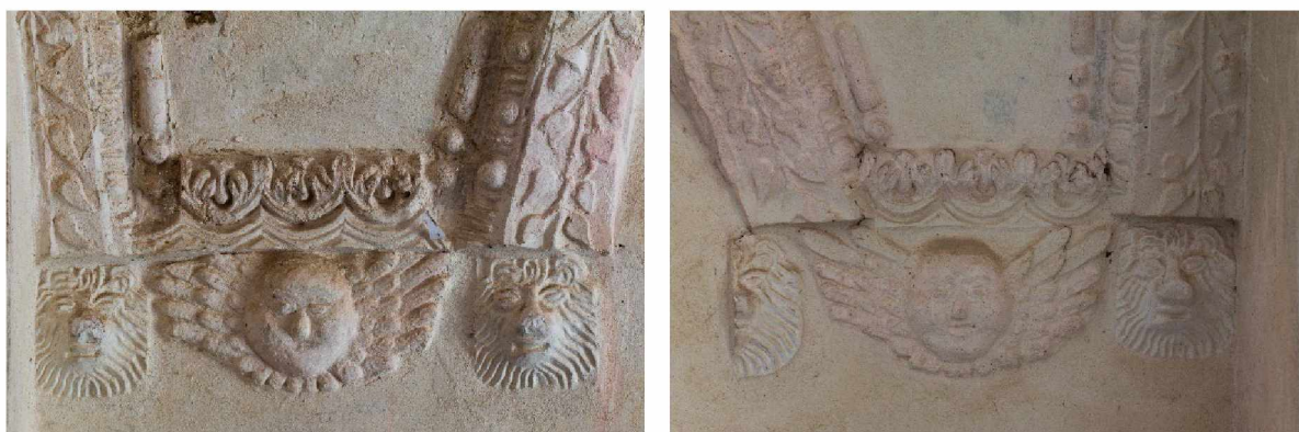
Obr. 63 Dešná, kostel sv. Jana Křtitele, předsín, na konzolách pod pasy kleneb a na otisku lva v severozápadním rohu předsíně jsou dosud zachované depozity po separaci hliněným šlikrem a známky po sejmutí formy, a konzole na protější straně jsou lví hlavy nahrazeny sádrovými kopiemi, foto: Vojtěch Krajíček.
