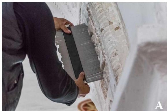
Snímání štukového profilu pomocí hřebenu.
