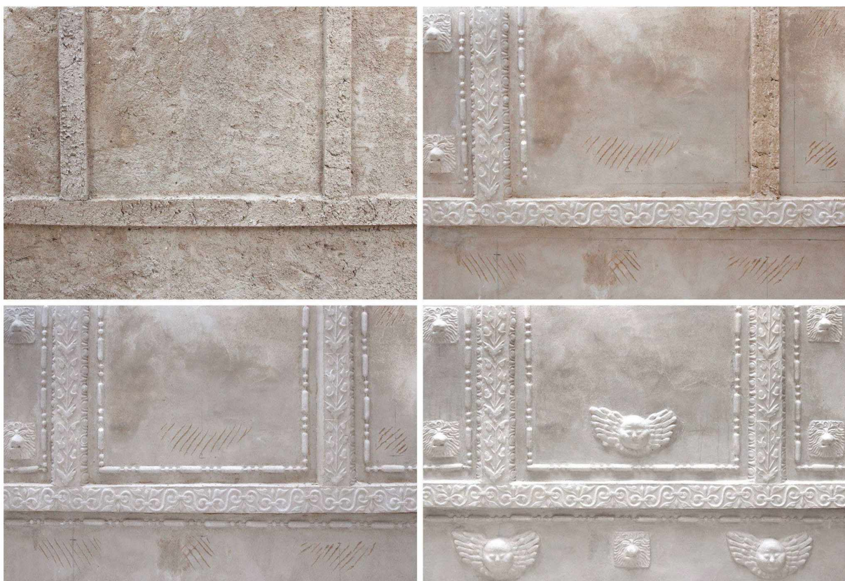
Obr. 58 Volná kopie části renesanční štukové výzdoby v Dešné replikující postup vytváření dekorace – příprava podkladu i s vytaženými žebry, postupné budování jednotlivých ornamentů, foto: Zdeněk Kovářík.
