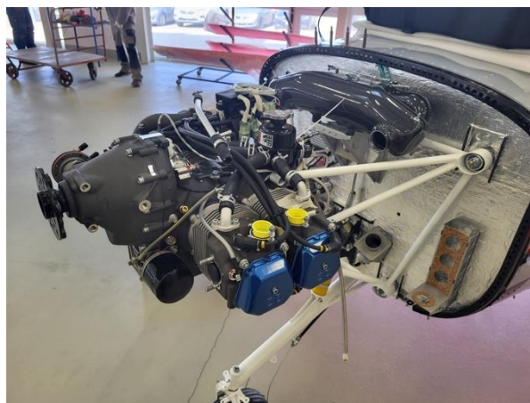
Obrázek 14 Instalace motoru CA500, Skylender Jihlava, zdroj: vlastní
