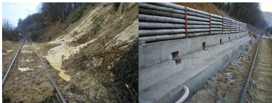
Obrázek 8 Svah v Ústí před a po provedení sanačních opatření
