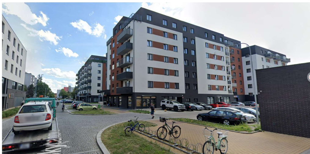
Obrázek 6 - Nově postavené bytová jednotka
