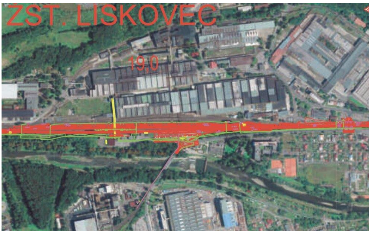
Obrázek 11 Modernizace železniční stanice Lískovec u Frýdku
