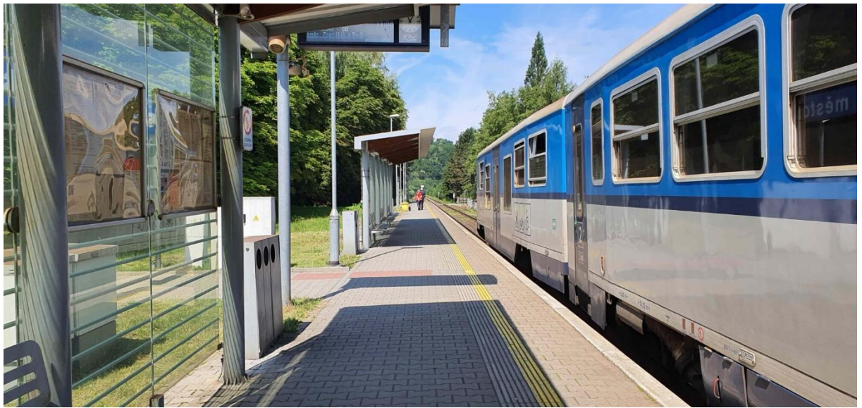
Obrázek 4 Železniční zastávka Frenštát pod Radhoštěm město
