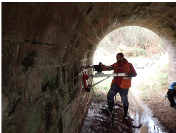
Foto č. 14 - Vrtání jádrového vrtu v měřícím bodě 2.
