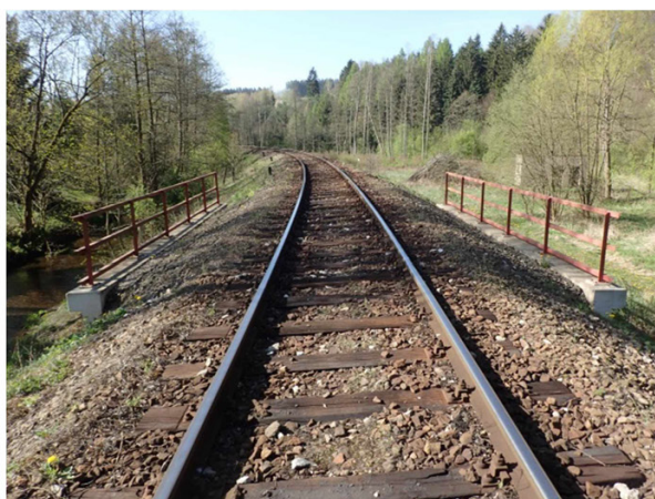
Foto č. 9- Pohled proti směru staničení.
