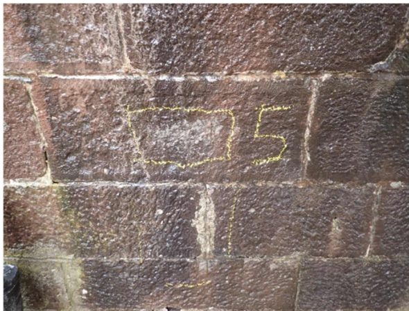
Foto č. 9 - Měřící bod 5.
