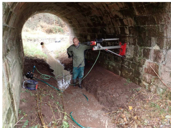
Foto č. 15 - Vrtání jádrového vrtu v měřícím bodě 3.
