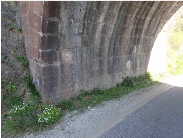
Foto č. 6 - O 02, Pohled na opěru.
