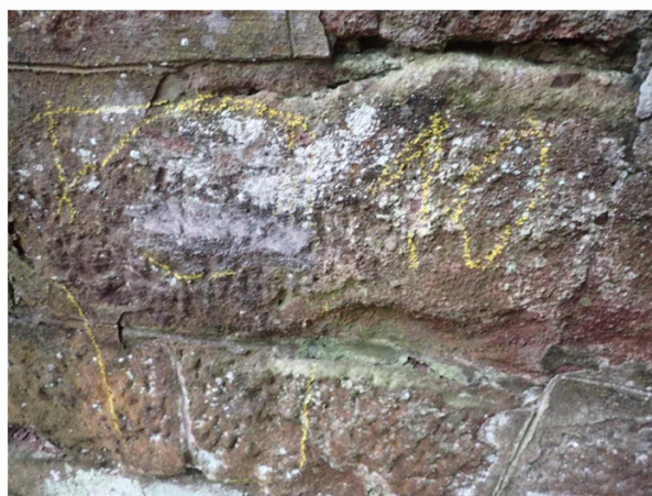
Foto č. 14 - Měřící bod 10.
