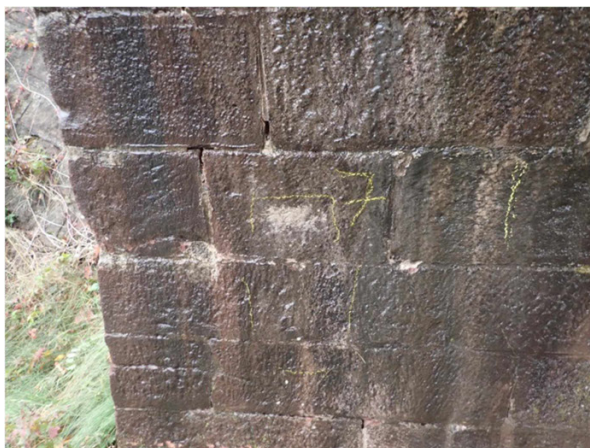
Foto č. 11 - Měřící bod 7.
