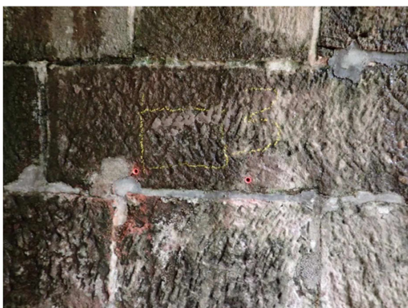
Foto č. 12 - Měřící bod 3.
