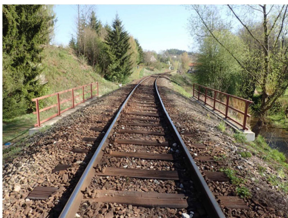
Foto č. 8 - Pohled ve směru staničení.
