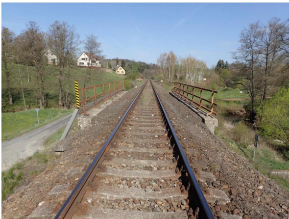
Foto č. 7 - Pohled ve směru staničení.
