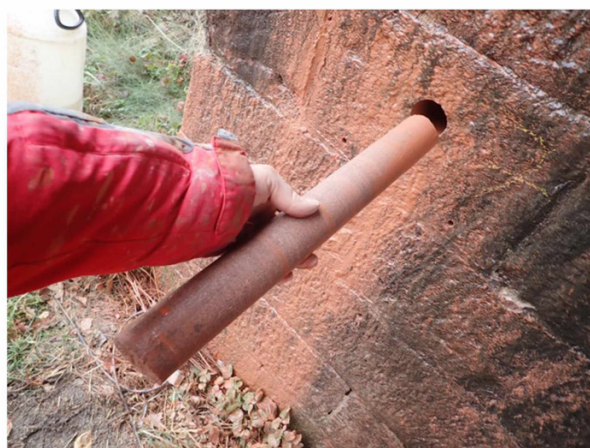
Foto č. 14- Vrtání jádrového vrtu v měřicím bodě 7.
