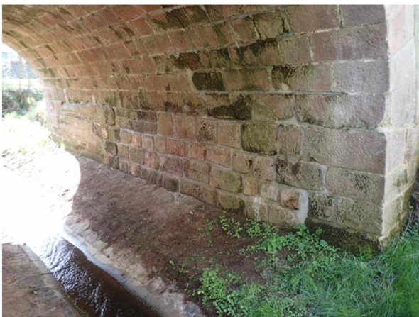
Foto č. 5 - O 01, Pohled na opěru.
