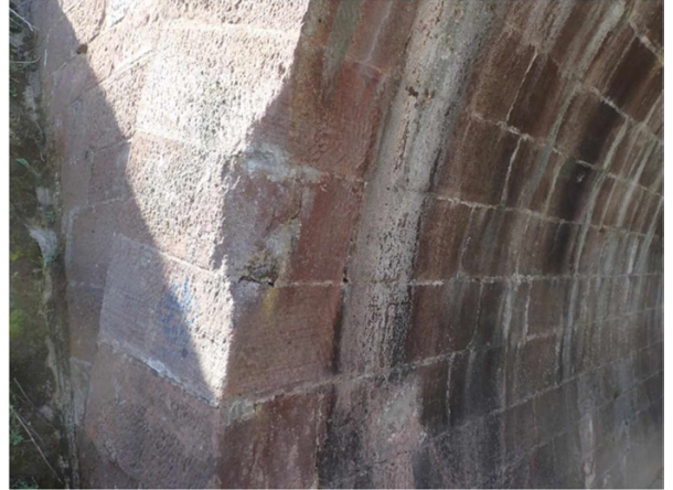
Foto č. 4 - K 01, Větec nad O01 vpravo, uražený kvádr do hl. až 50 mm.
