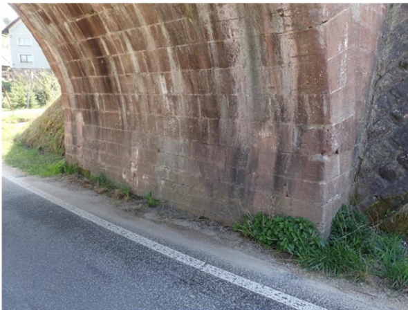
Foto č. 5 - O 02, Pohled na opěru.
