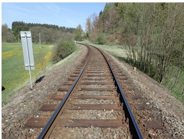
Foto č. 11 - Pohled ve směru staničení.
