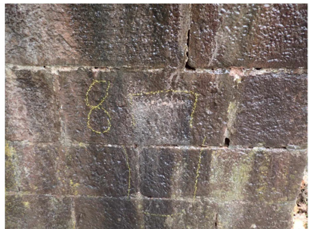
Foto č. 12- Měřící bod 8.
