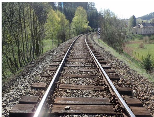
Foto č. 12 - Pohled proti směru staničení.
