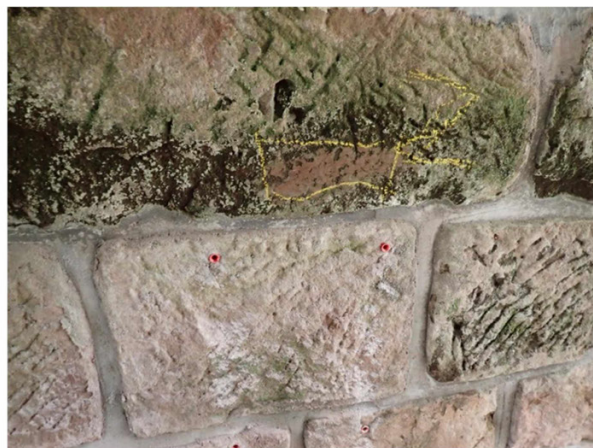
Foto č. 11 - Měřící bod 2.
