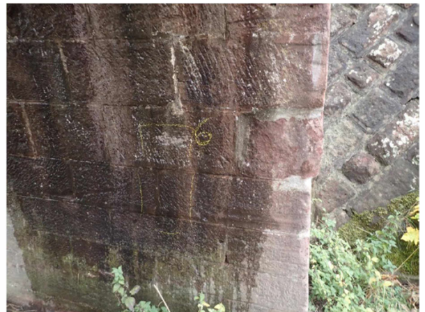
Foto č. 10- Měřící bod 6.
