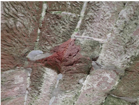
Foto č. 3 - K 01, 3,7-4,1 m zleva ve vrcholu, degradace kvádrů do hl. 70 mm.
