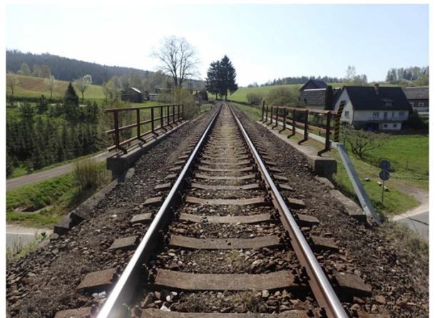
Foto č. 8- Pohled proti směru staničení.
