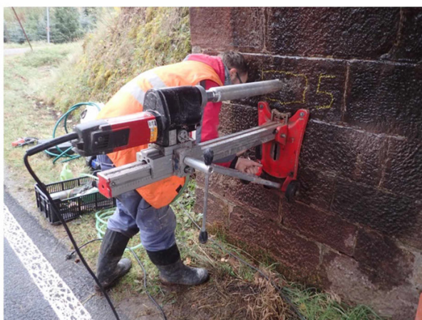
Foto č. 13 - Vrtání jádrového vrtu v měřicím bodě 5.
