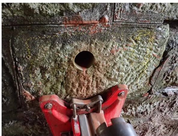
Foto č. 13 - Měřící bod 9.
