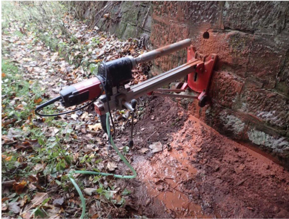
Foto č. 17 - Vrtání jádrového vrtu v měřícím bodě 10.
