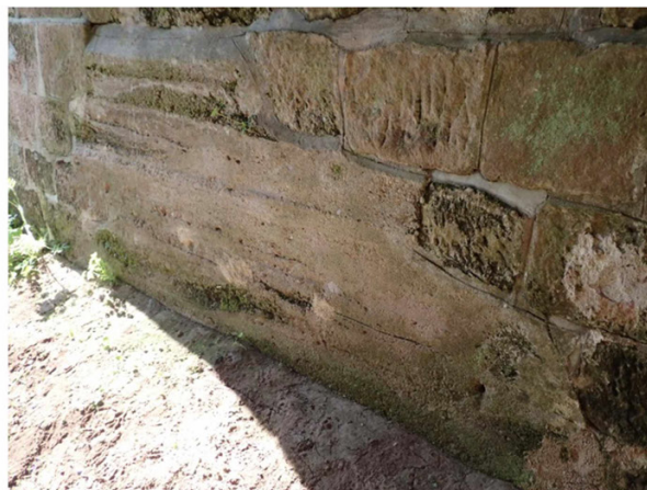
Foto č. 6- O 01, Betonová plomba.
