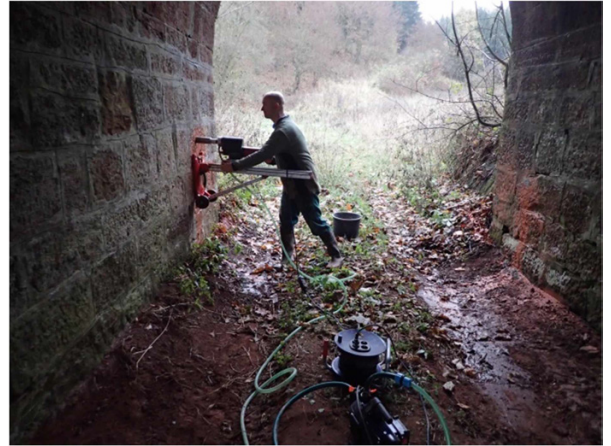
Foto č. 18- Vrtání jádrového vrtu v měřícím bodě 11.
