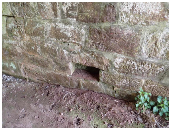
Foto č. 6- O 01, 4,0 m zleva chybějící kvádr.
