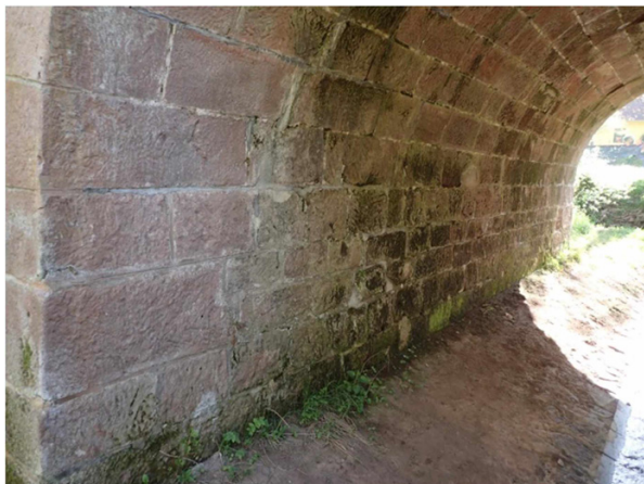
Foto č. 7 - O 02, Pohled na opěru.
