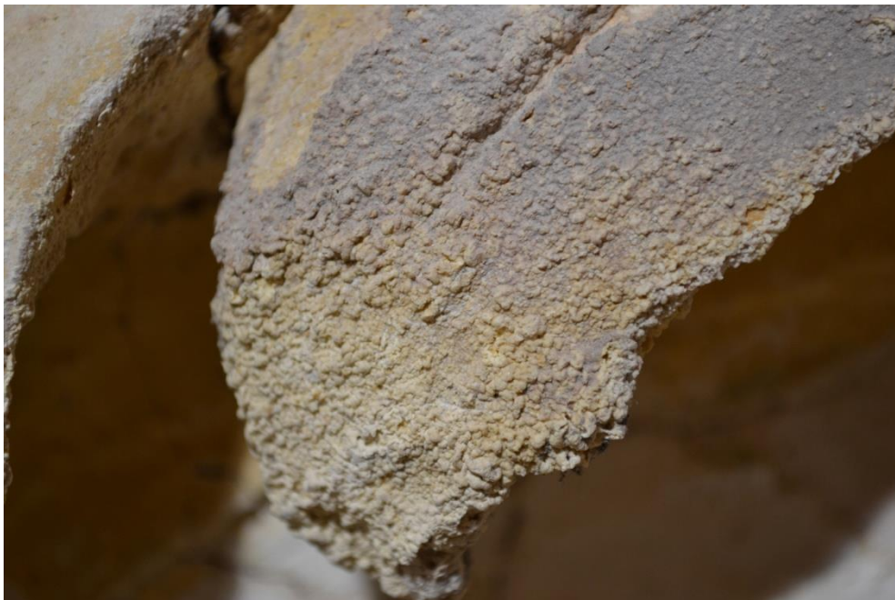
Obr. 2. 5 Detail poškození - deformace akantového listu krustou
