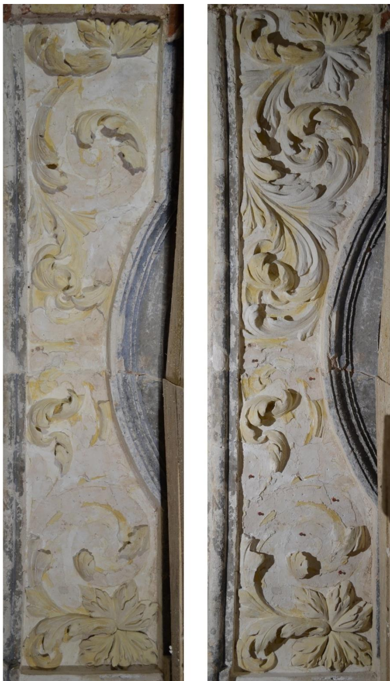
Obr. 2. 10 Stav po očištění a zajištění, stav v průběhu rekonstrukce
