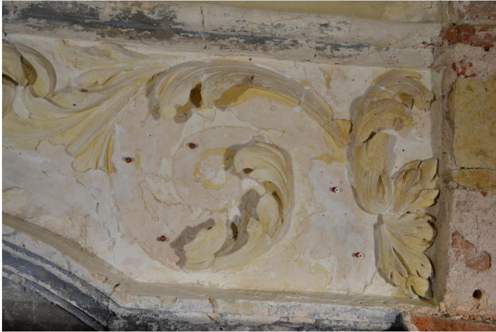
Obr. 2. 8 Stav před rekonstrukcí - nové armatury
