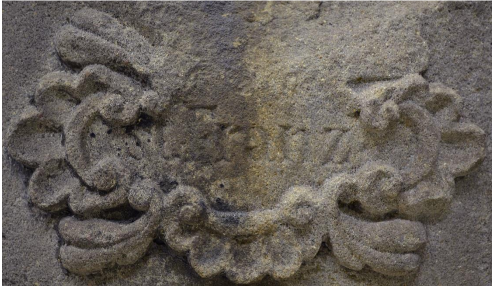
Obr. 4. 16 Detail kartuše – zkouška čištění nízkotlakou vodní parou
