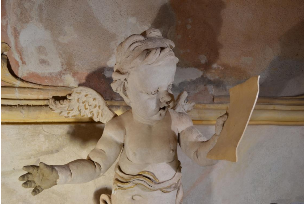
Obr. 1. 15 Rekonstrukce chybějících částí
