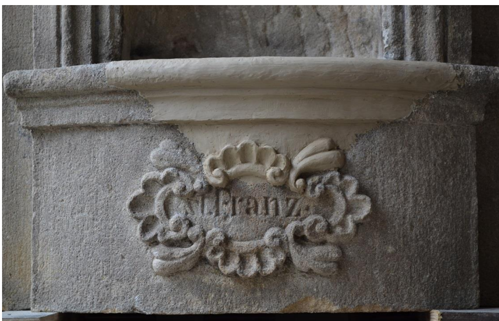
Obr. 4. 21 Detail – rekonstrukce chybějící části v sochařské hlíně
