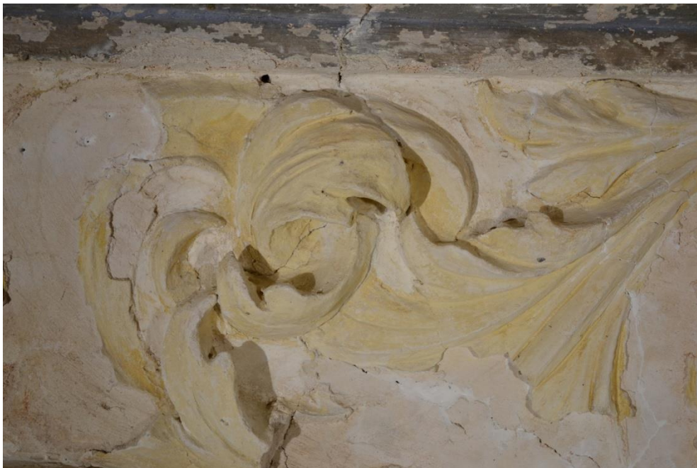
Obr. 2. 7 Detail stavu po očištění a fixaci
