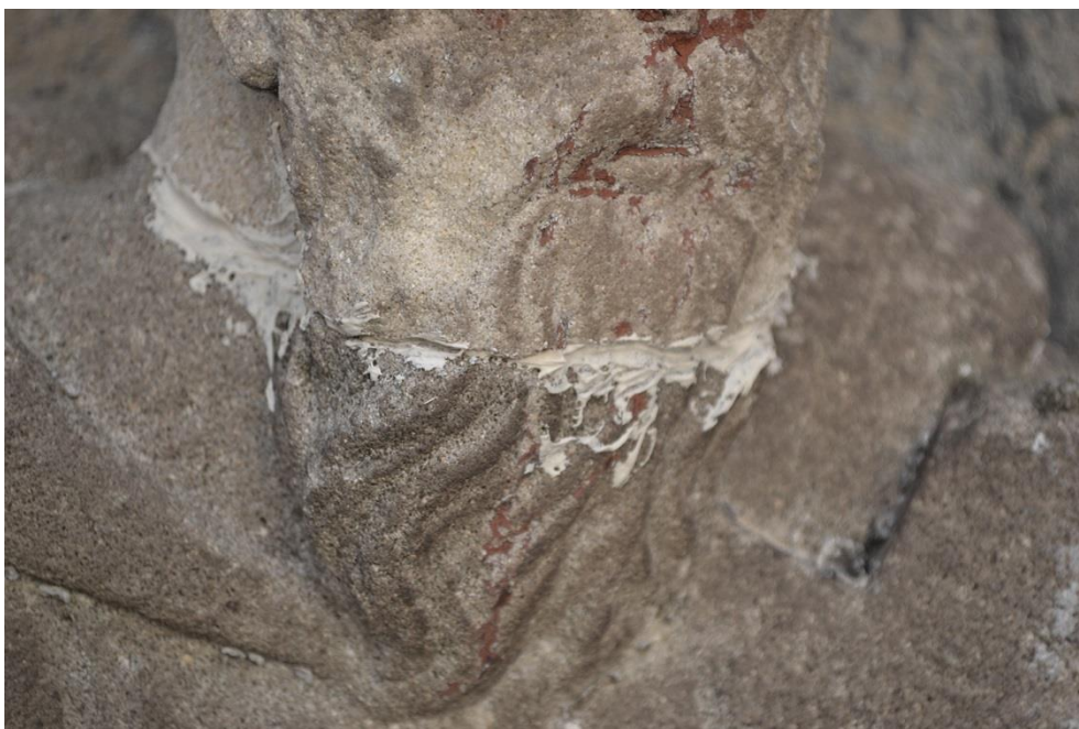
Obr. 4. 18 Detail spoje - před odstraněním lepicí směsi
