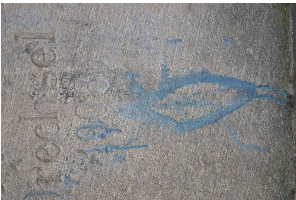
Obr. 4. 13 Detail poškození – poškození barvou na zadní části
