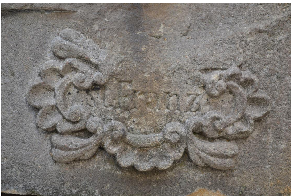
Obr. 4. 7 Detail poškození – prachové depozity a chybějící část kartuše
