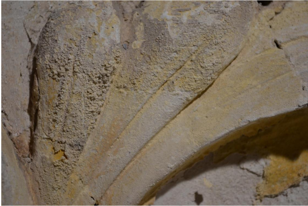
Obr. 2. 6 Zkouška jemného manuálního čištění
