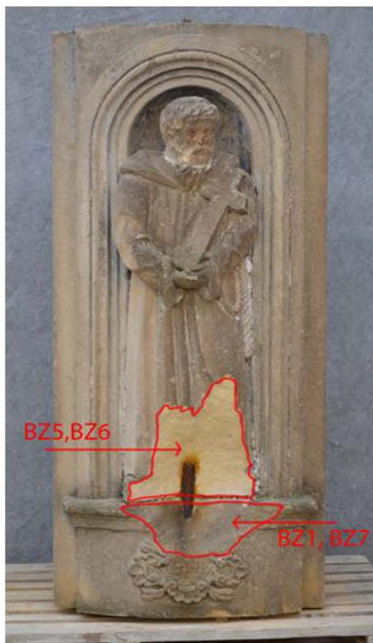
Obr. 42 Rozmístění čistících zábalů.
