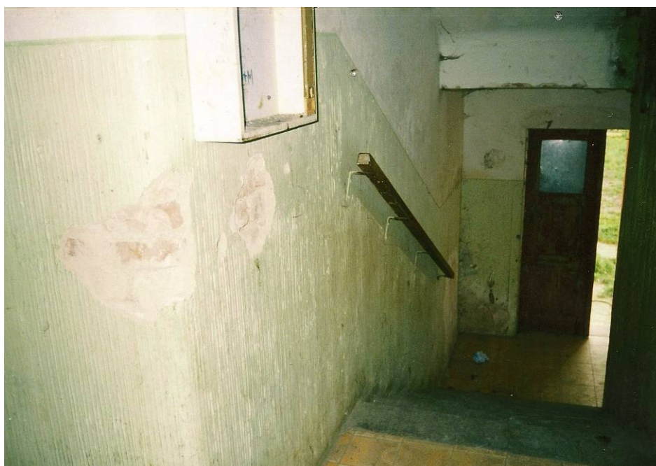
Obrázek 4: Průchod budovou č. 1119 na zahradu (Zdroj: OS Darjav)
