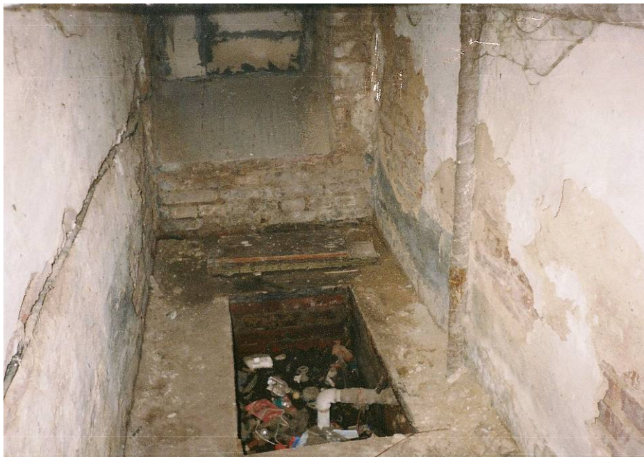
Obrázek 5: Sklepní prostory (Zdroj: OS Darjav)
