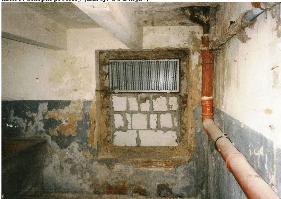
Obrázek 6: Sklepní prostory (Zdroj: OS Darjav)
