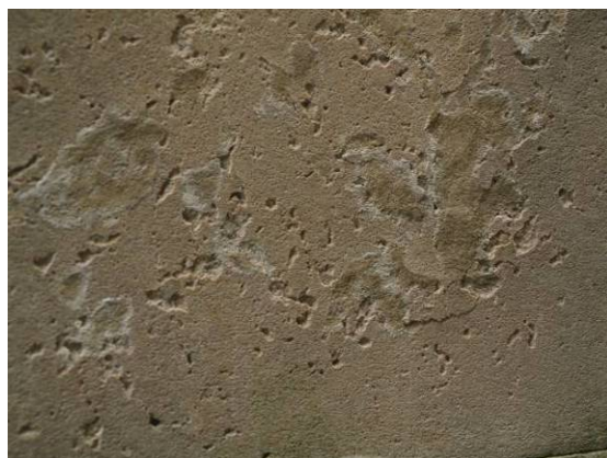
Obr. 93 Paraloidový tmel s tzv. mokrým vzhledem
