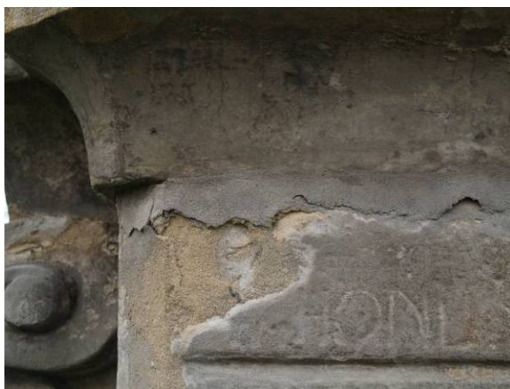
Obr. 88 Detail oddělujícího se paraloidového tmelu
