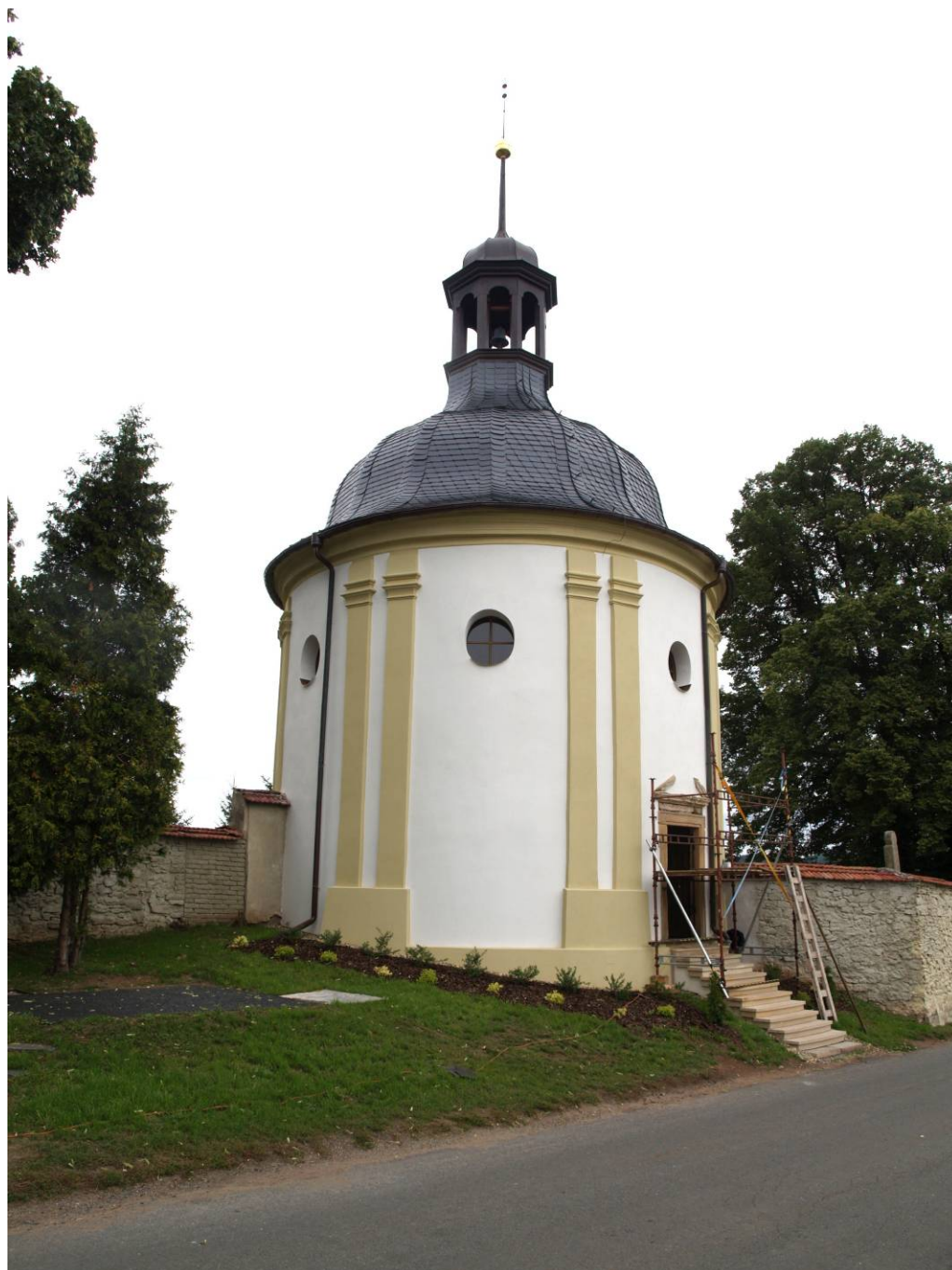
Obr. 53 Kaple sv. Isidora v Křenově
