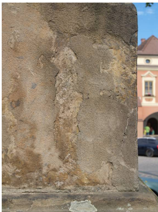
Obr. 108 Tmely oddělující se od hmoty kamene
