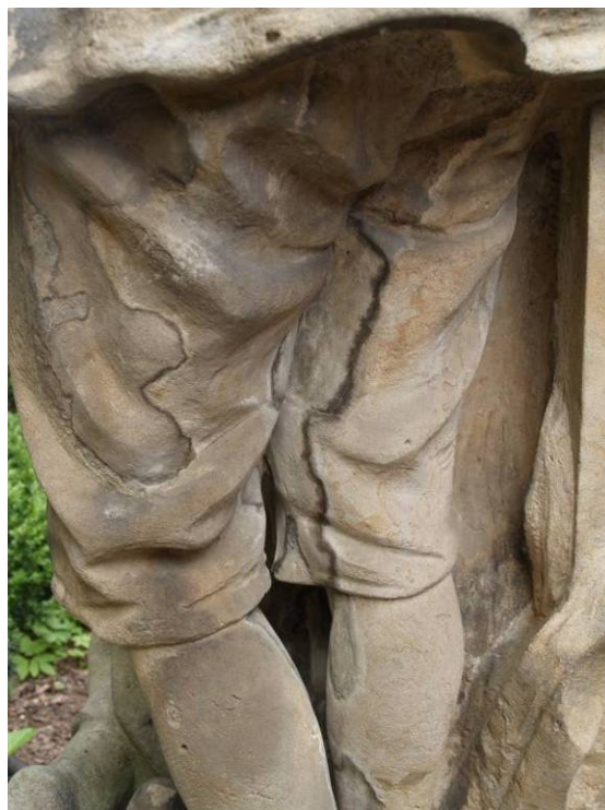
Obr. 91 Detail cementových tmelů na nohách chlapce
