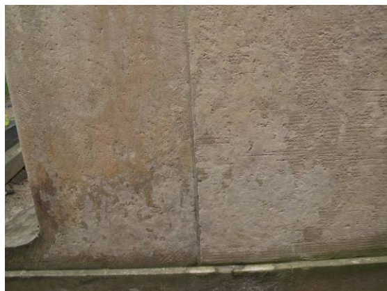
Obr. 92 Paraloidové tmely na zadní straně náhrobku
