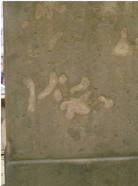
Obr. 109 Tmely s biologickým povlakem
