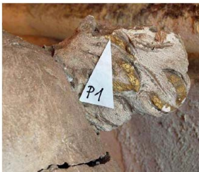
Obr. 20 Místa odběru vzorků 6691 (P1), putto č.18 – levá strana, křídlo. Foto Daniel Bartoš.
