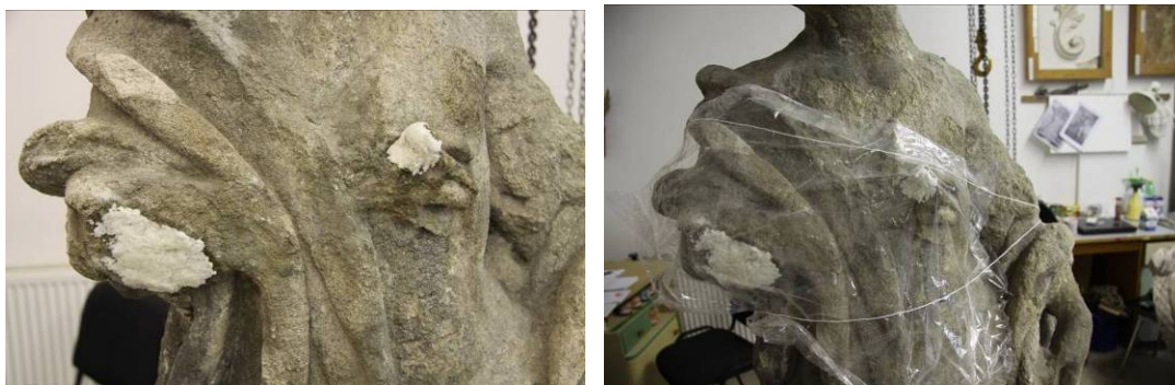
Obr. 15, Obr. 16 Zkouška snímání starých vysprávek
