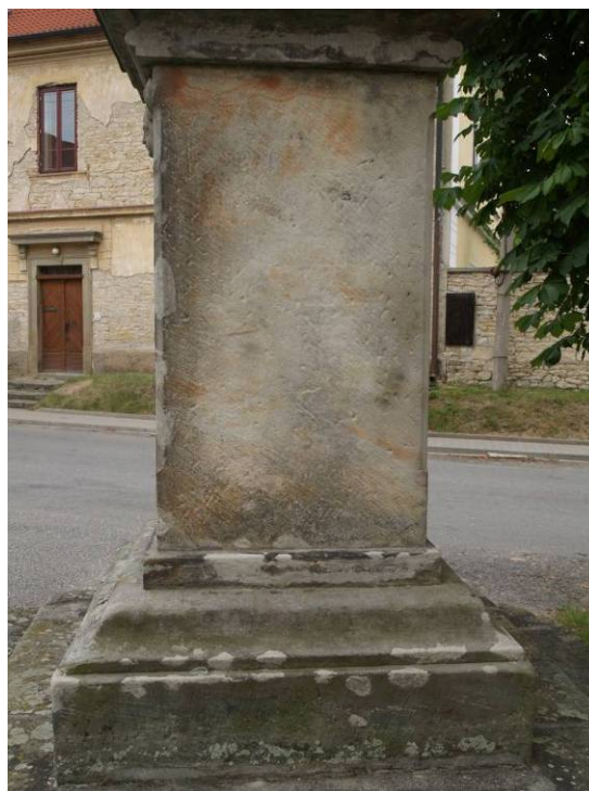
Obr. 99 Zadní strana soklu (světlé tmely na hranách)
