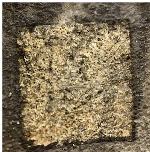
Obr. 14 Zkouška čištění pískováním
