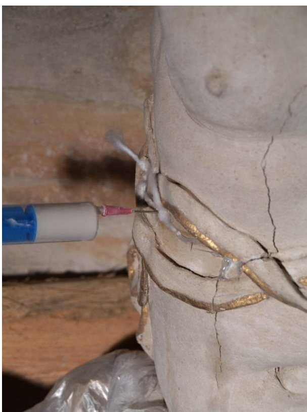
Obr. 69 Průběh prací injektáž prasklin
