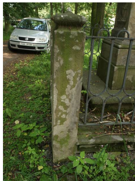
Obr. 96, Obr. 97 Kontrast tmelu a kamene s biologickým povlakem
