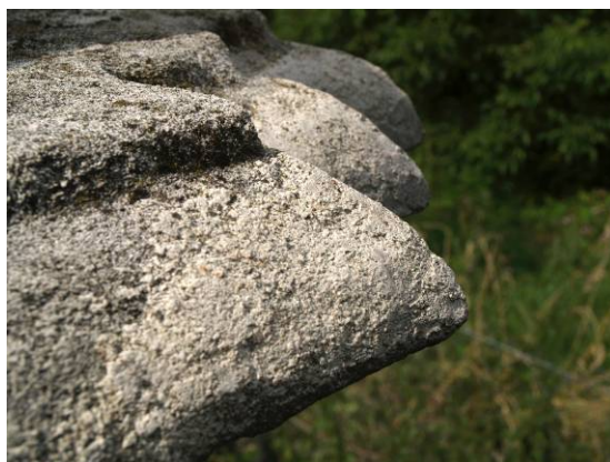
Obr. 122 Tmely na rohách hlavice soklu
