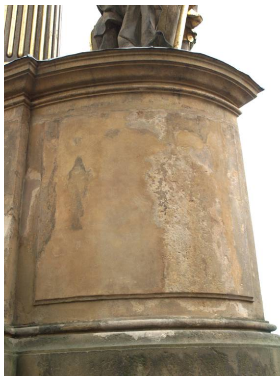
Obr. 107 Dobře probarvený tmel zadní strana podstavce
