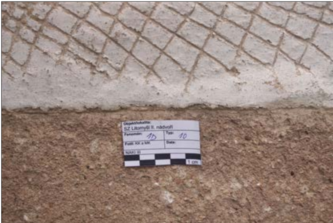
Intonaco (vrstva do které bylo ryto) 1D. Vrstva intonaka, byla nanášena ve vodorovných páslech - pontati (1D/10).
