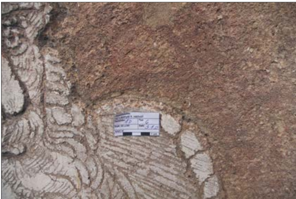
Intonaco (vrstva do které bylo ryto) 1D. Obsahuje lokálně náhodné příměsi (1D/6 – cihlu).
