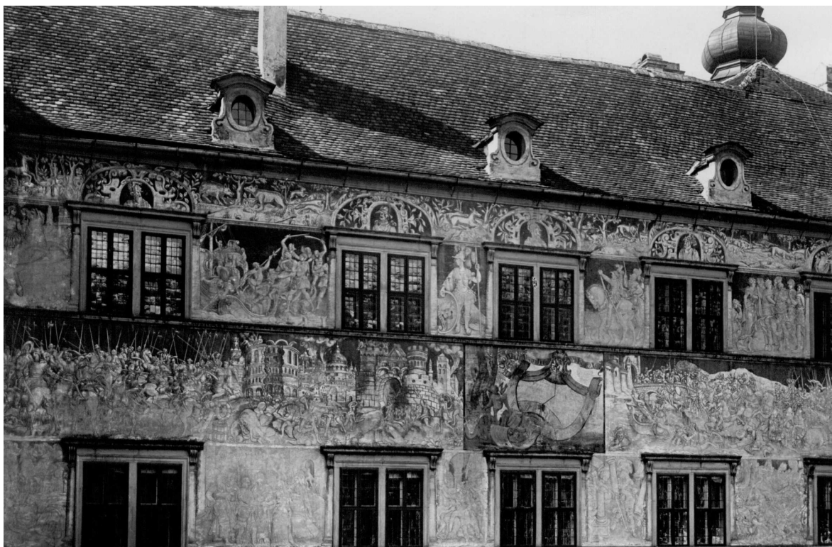
Obr. 8 Litomyšl, zámek, 1. nádvoří. Sgrafita severní stěny, asi 1910 (s.d. na kartě), NPÚ GŘ, sbírka fotografické dokumentace, F004178
