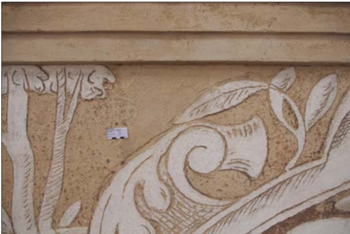
Raně barokní sgrafita - oprava po požáru 1635 (2B/1). Na povrchu odrytých ploch jsou fragmenty nesoudržné okrové jemnozrnné vrstvičky. Na povrchu okrové vrstvičky dále fragmenty černočervené vrstvy (odstraněné druhotné zásahy). Uprostřed pod římsou oprava 1984 - 1987 - Zoubek, Boštík, Palcr, Podhrázský (2B/2). Omítka světle šedé barevnosti, zaretušovaná okrovou barvou.
