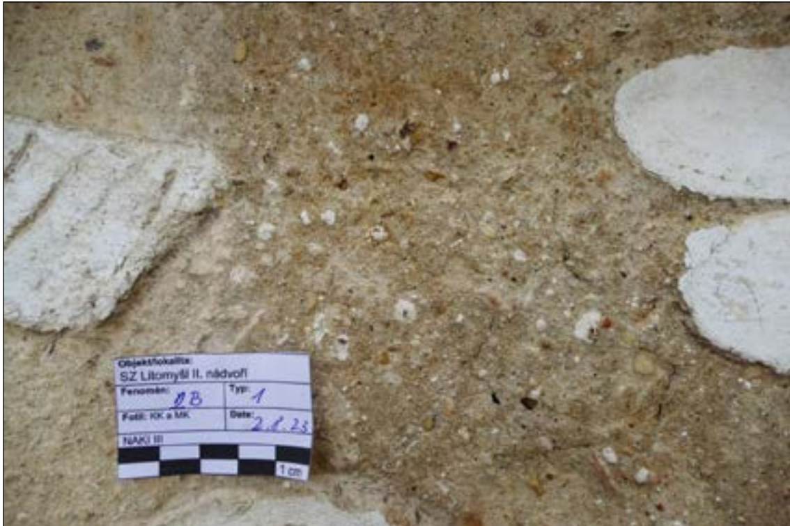
Raně barokní sgrafita - oprava po požáru 1635 (2B/1) Omítka je světle okrové barevnosti a je poměrně hrubozrnná. Obsahuje hodně karbo-nátových částic. V plnivu jsou patrné kousky pískovce.
