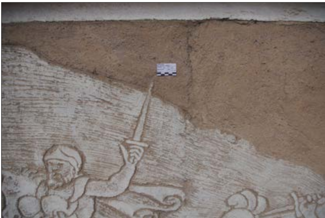
Intonaco (vrstva do které bylo ryto) 1D. Svislé dělicí linie denních dělů byly zaznamenané v pouze na rozsáhlých výjevech 2. sgrafitového pásu (C1a – bitva s Turky a Obléhání města a C1b – Bitva u Milvij-ského mostu). Tato napojení omítek jsou poměrně razantní, velmi dobře viditelné, není patrná snaha je napojení „zamaskovat“.
