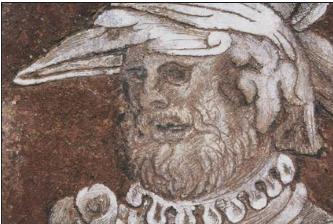
Sonda 2 - sonda provedená na původní povrch renesanční omítky. Výjev A3. Velmi dobře dochovaná renesanční omítka včetně původních povrchových vápenných vrstev.
