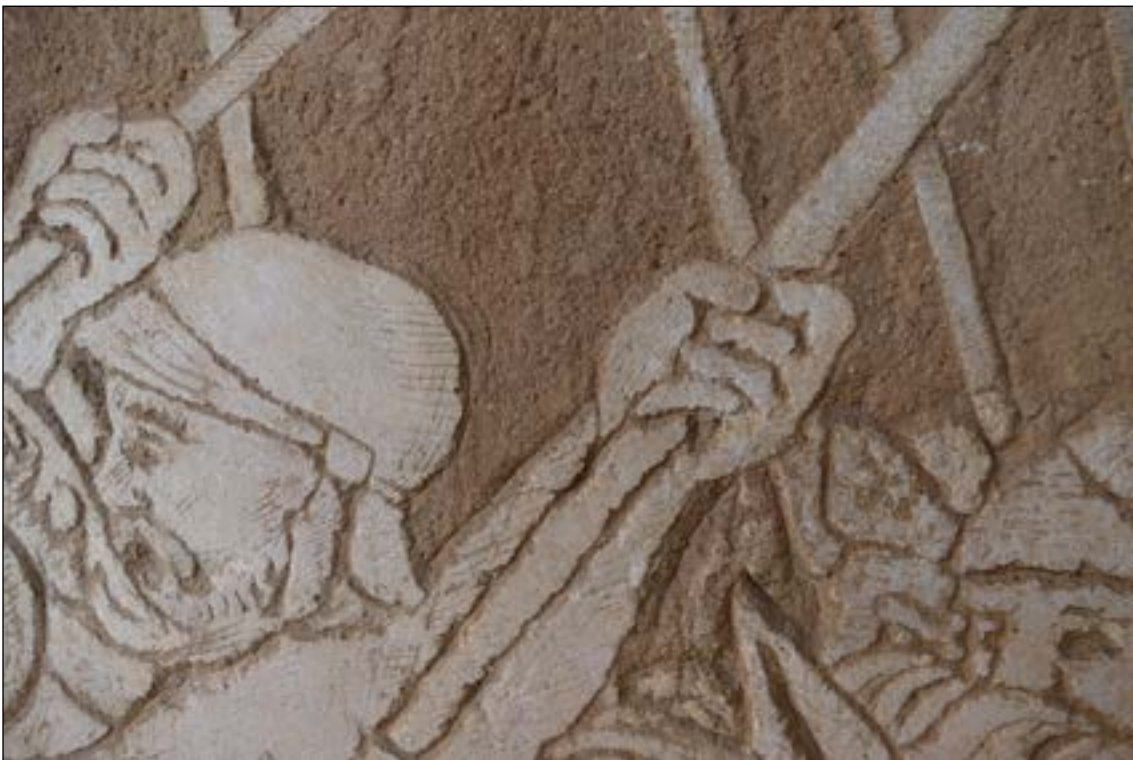
Zkouška čištění párou s pomocí jemných kartáčků a houbiček na přeškráblé ploše renesanční omítky. Pomocí páry lze důsledněji revidovat druhotné zásahy (zejména přeškráblá pozadí).
