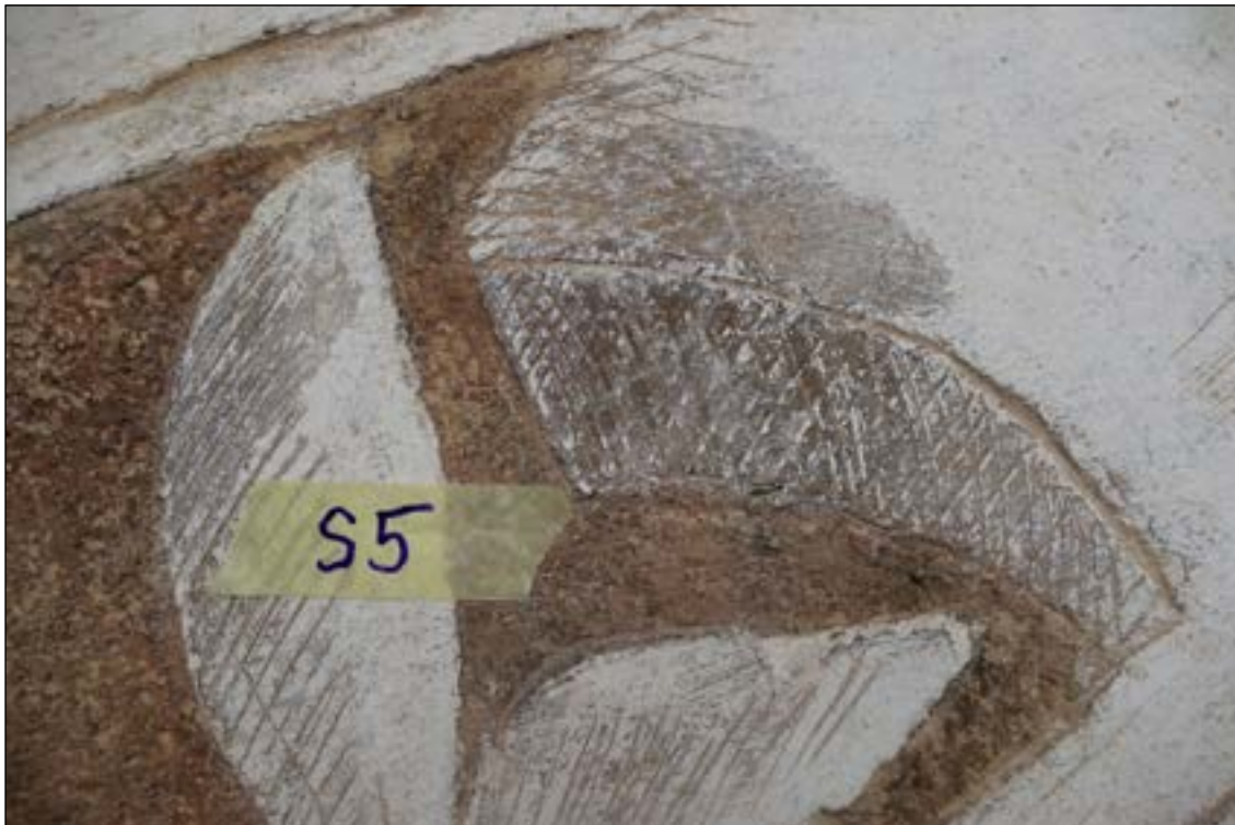
Sonda 5 - sonda na původní povrch renesanční omítky s dochovaným původním bíancem. Výjevy A4 a A5.
