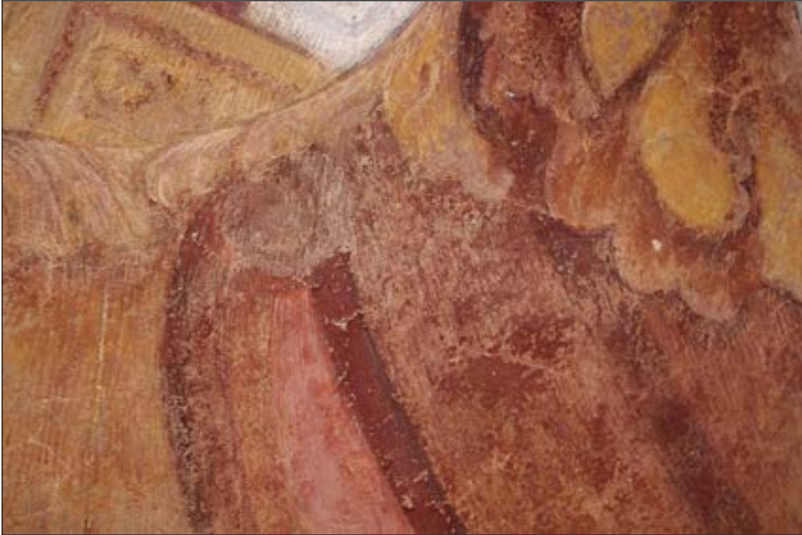
Detail druhotné vysprávky a degradace barevné vrstvy (zvedání šupinek).
