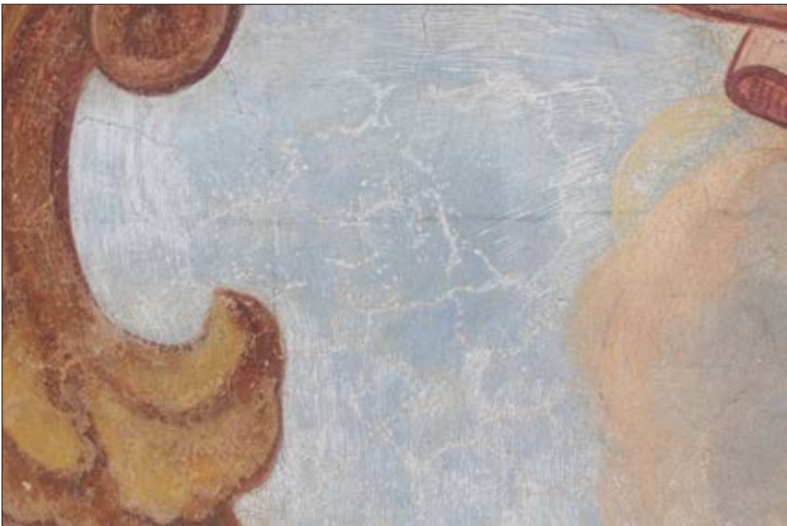
Primární trhliny se rýsují na celé ploše hodin i na partiích nejlépe zachovaných, pod průběžnou římsou. U druhotných retuší došlo ke změně barevnosti.
