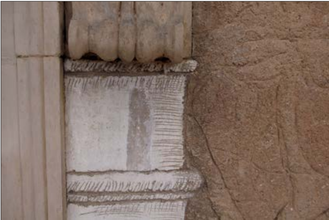
Sonda 9 - sonda na původní povrch renesanční omítky. Výjev B3.
