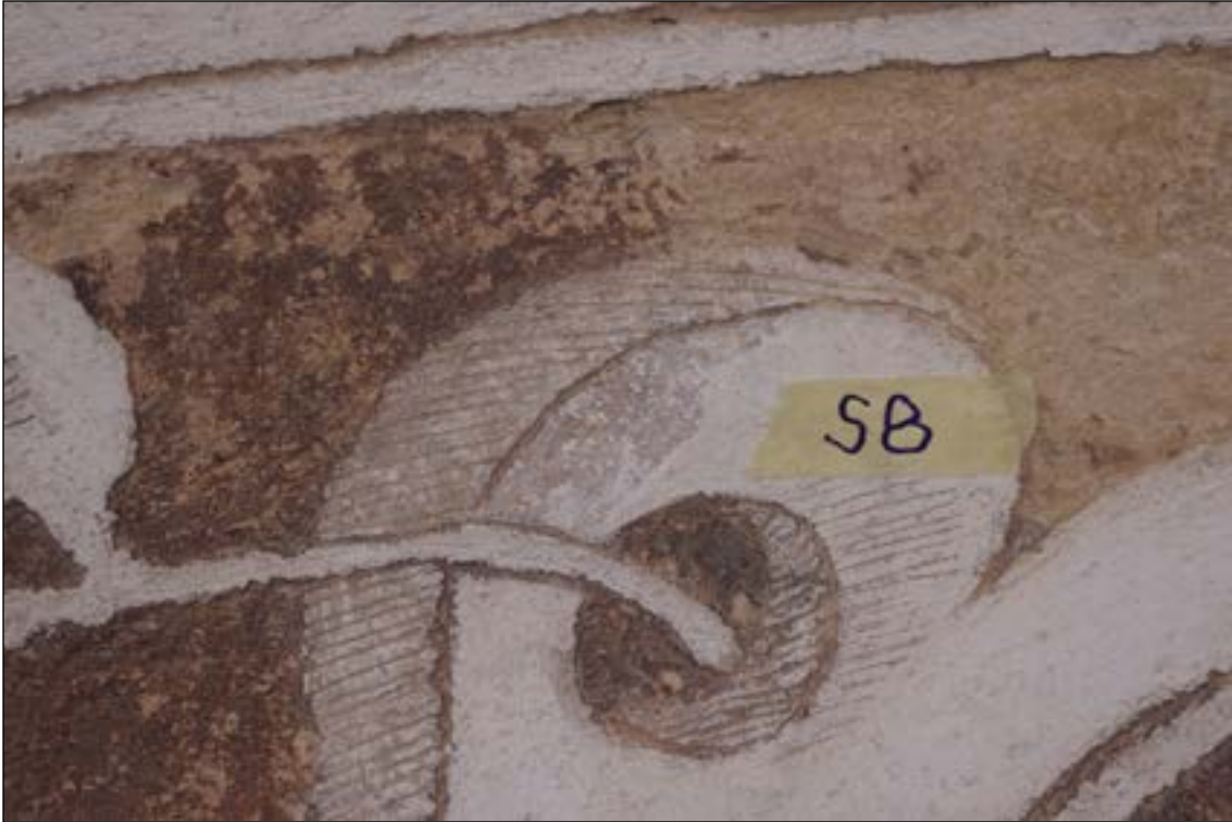
Sonda 8 - sonda na původní povrch renesanční omítky. Výjev A5.
