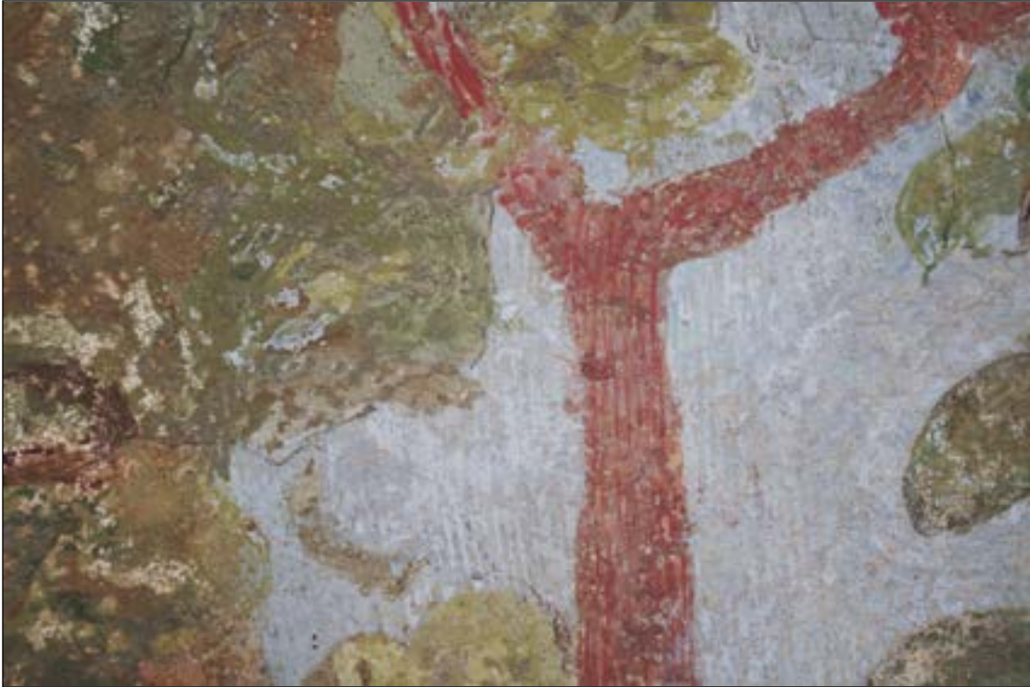
Detail rozsahu degradace barevné vrstvy a rozsahu provedené čárkové retuše na vegetaci slunečních hodin.
