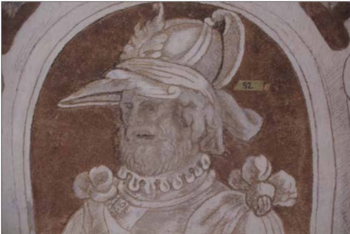
Sonda 2 - sonda provedená na původní povrch renesanční omítky. Výjev A3. Velmi dobře dochovaná renesanční omítka včetně původních povrchových vápenných vrstev.
