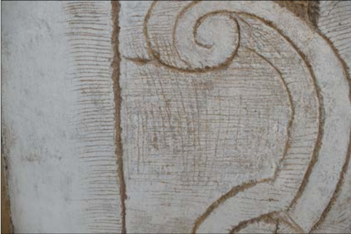
Bílý nátěr (bianco) - oprava 1984–1987 - Zoubek, Boštík, Palcr, Podhrázský (2C/1). Druhorné prorytí.
