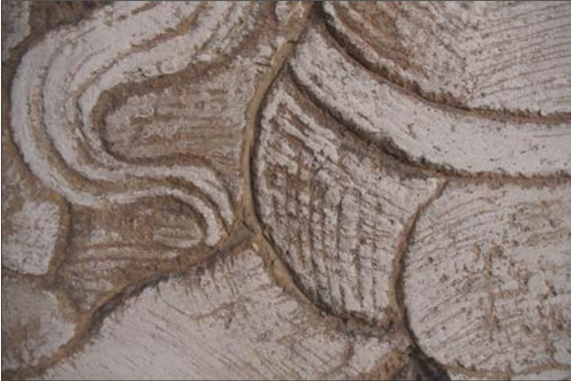
Historické opravy 19. a 20. století - před zásahem v 80. letech - drobné tvrdé tmely na horních partiích rytých linií (2B/5).
