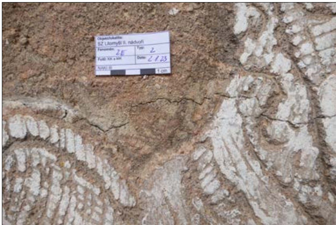
Poškození – defekty (2E). Dalším poškozením jsou statické a vlasové trhliny (2E/2).
