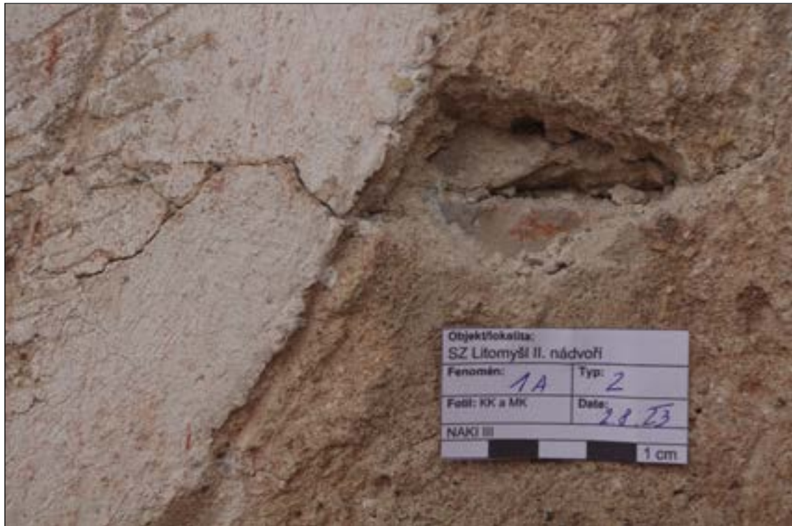
Zdivo 1A. Ve drobných otevřených defektech na fasádě bylo patrné cihlové zdivo (1A/2). Není vyloučeno však ani zdivo smíšené, pouze nebylo prokázáno.
