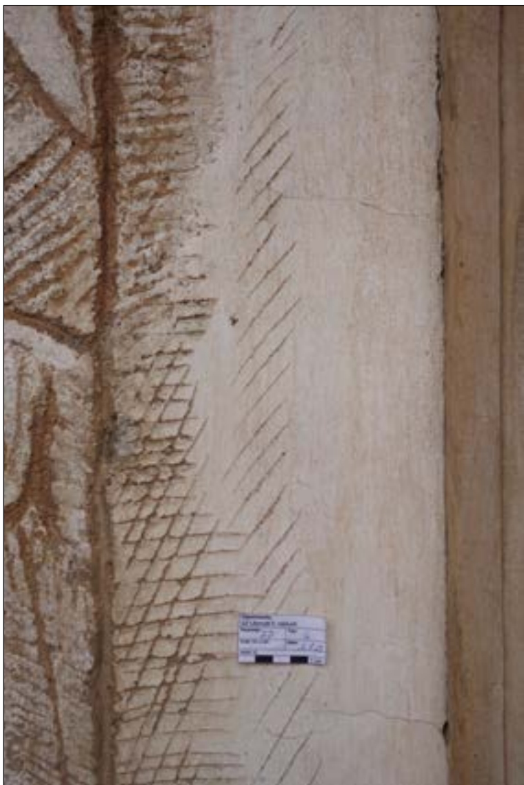
Barevné vrstvy – změny barevnosti (2D). Zatekliny (2D/6) jsou dobře viditelné díky tomu, že strhávají okrovou barevnou vrstvu retuší
