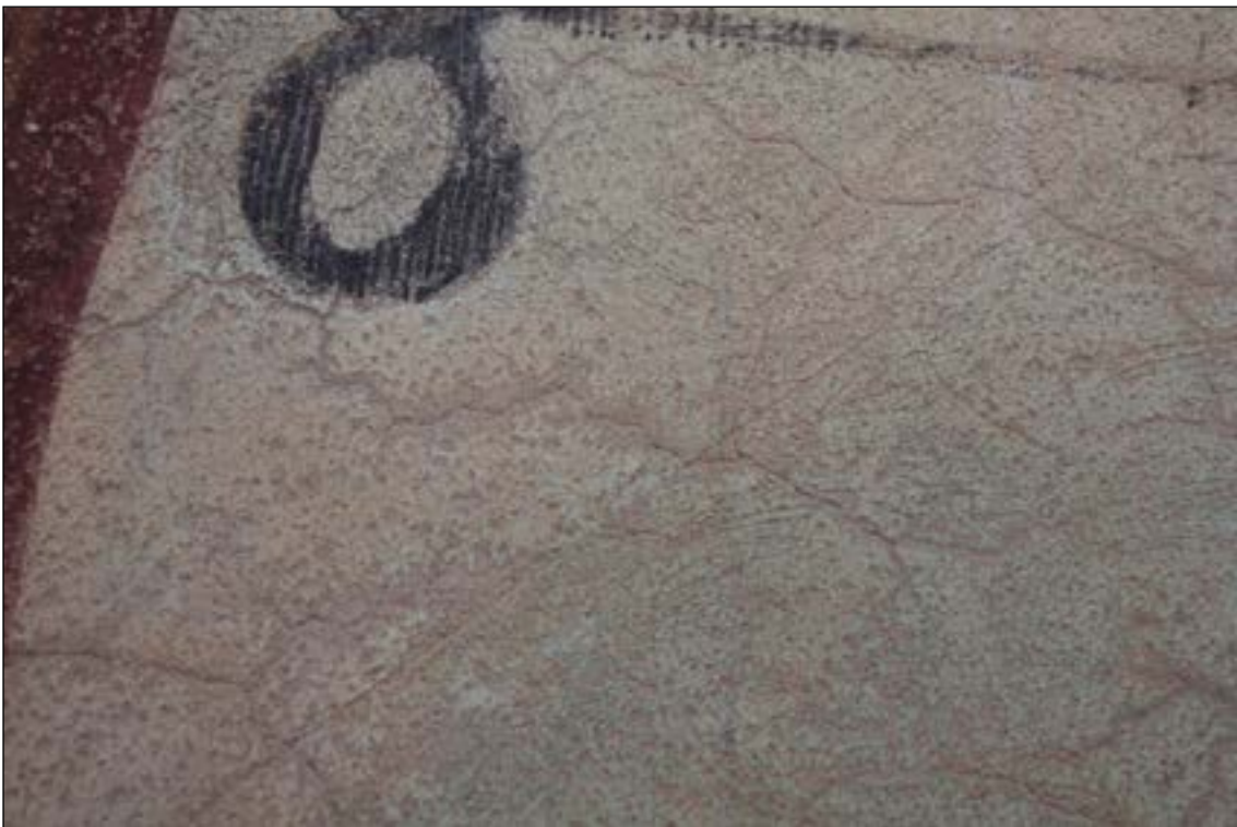
Detail degradace původního povrchu slunečních hodin a vtačené linky rozkresby.
