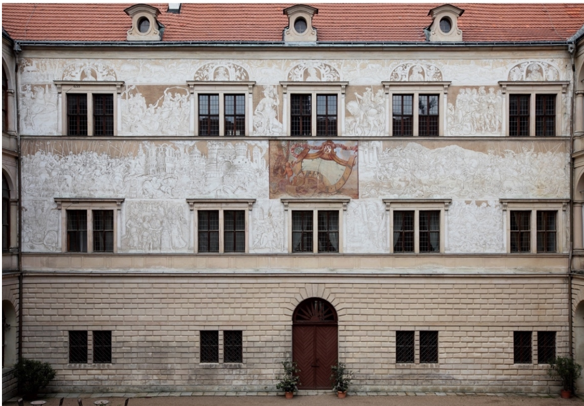
Obr. 1 Celková fotografie části fasády se sgrafitovou výzdobou a malovanými slunečními hodinami.
