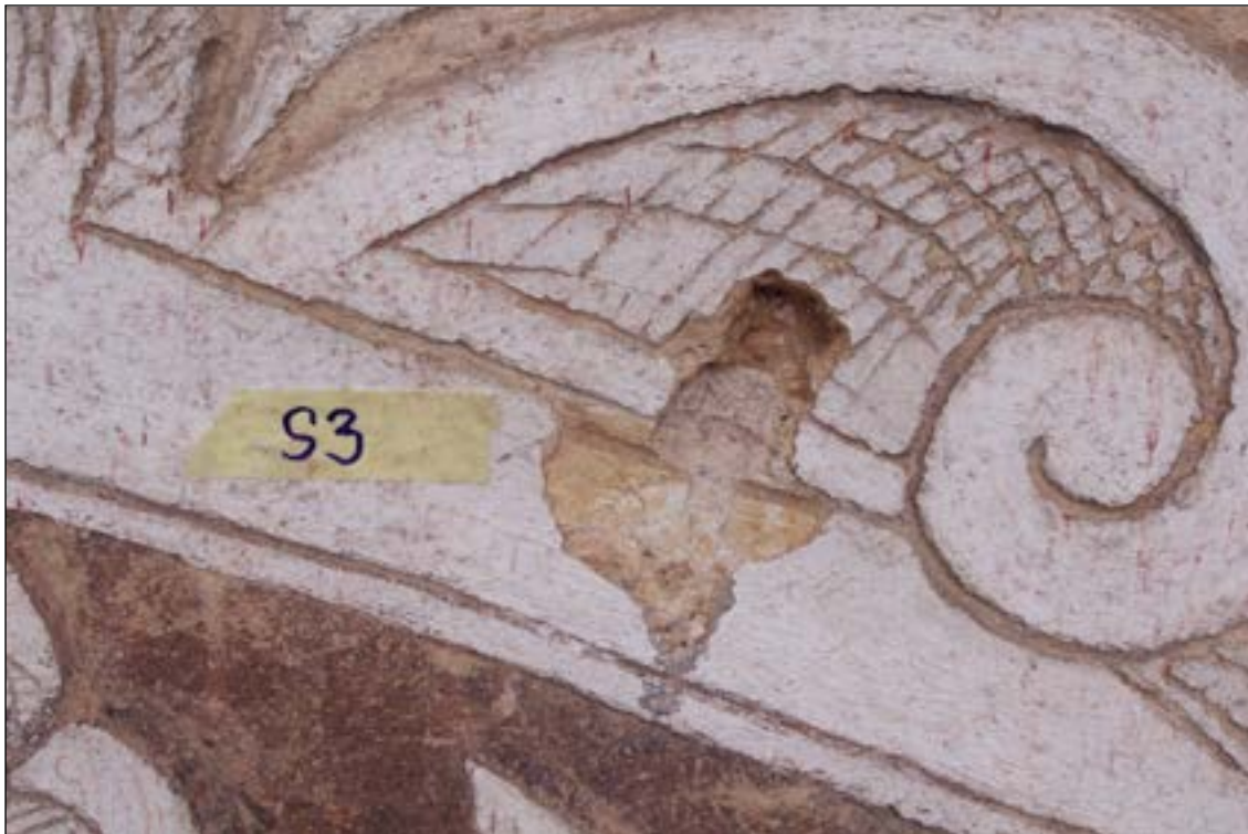
Sonda 3 - sonda provedená na hranici omítek dvou etap - spodní renesanční omítka a horní omítka provedená po stržení lunetové římsy po požáru roku 1635. Lovecký výjev A1b. Renesanční omítka dochovaná v nejautentičtější podobě, zakrytá velmi záhy po provedení (50 let po vzniku sgrafit).
