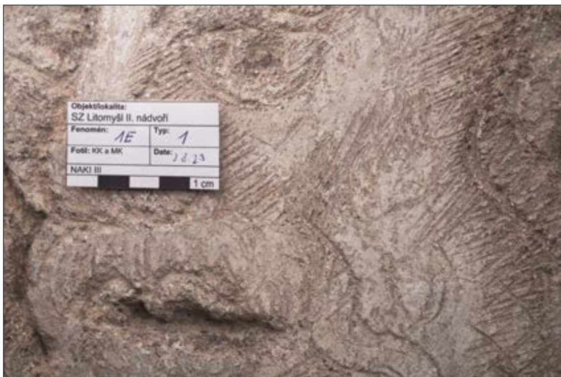
Bílý nátěr 1E. Na intonacu byl nanesen vápenný nátěr (1E), který nebyl nijak upraven (jsou na něm patrné stopy po štětci). Patrně byly provedeny minimálně dvě vrstvy nátěru (viz laboratorní analýzy). Zdá se pravděpodobné, že byly provedeny světelné akcenty na místa nejvyššího světla.
