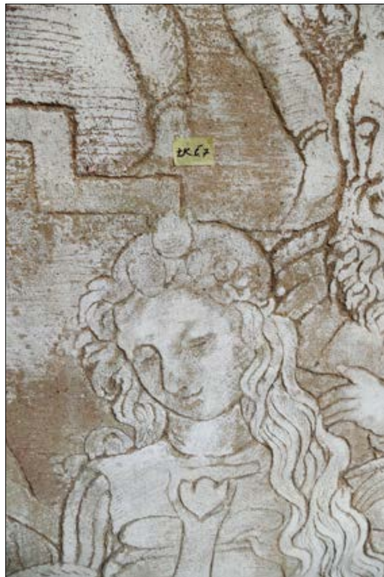
Detail ČV7 po očištění vodou a revizi nesoudržných krakelů vápenného nátěru z 80. let..
