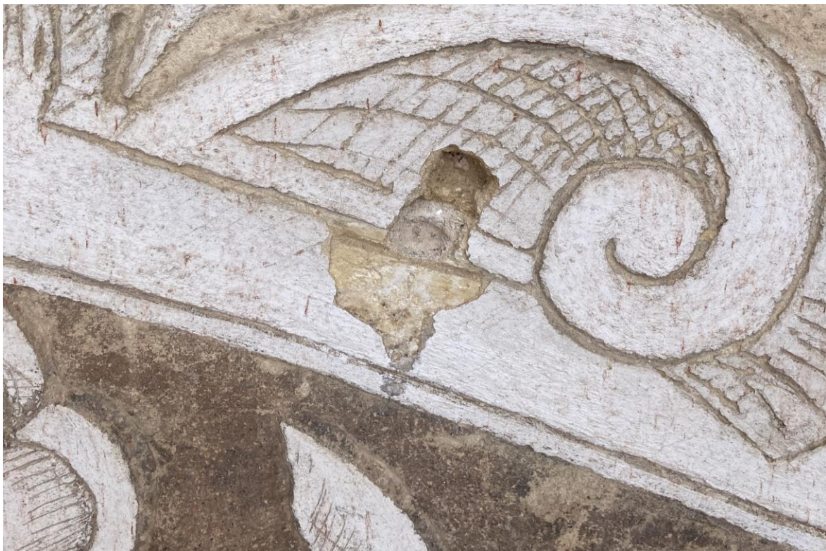
Obr. 114 Místo odběru vzorku 11301 (2N/1) až 11305 (2N/5), detail.
