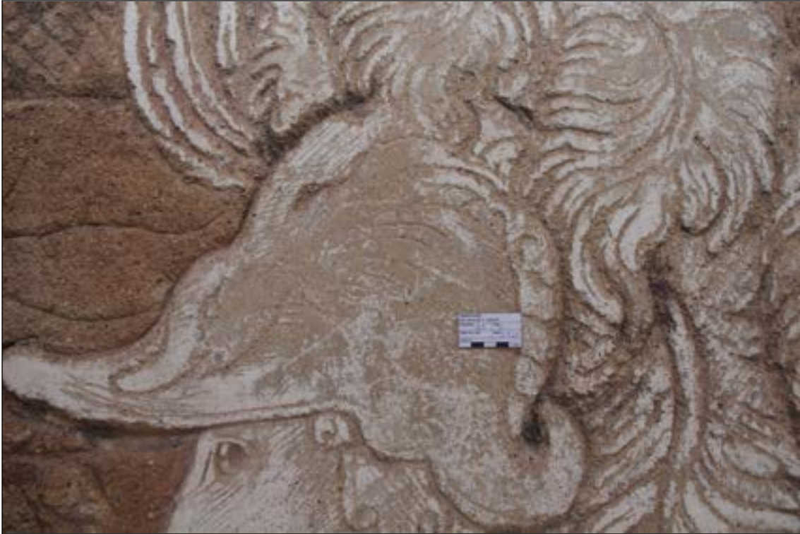
Bílý nátěr (bianco) - oprava 1984–1987 - Zoubek a spol. Na některých místech již nátěr chybí (2C/2).
