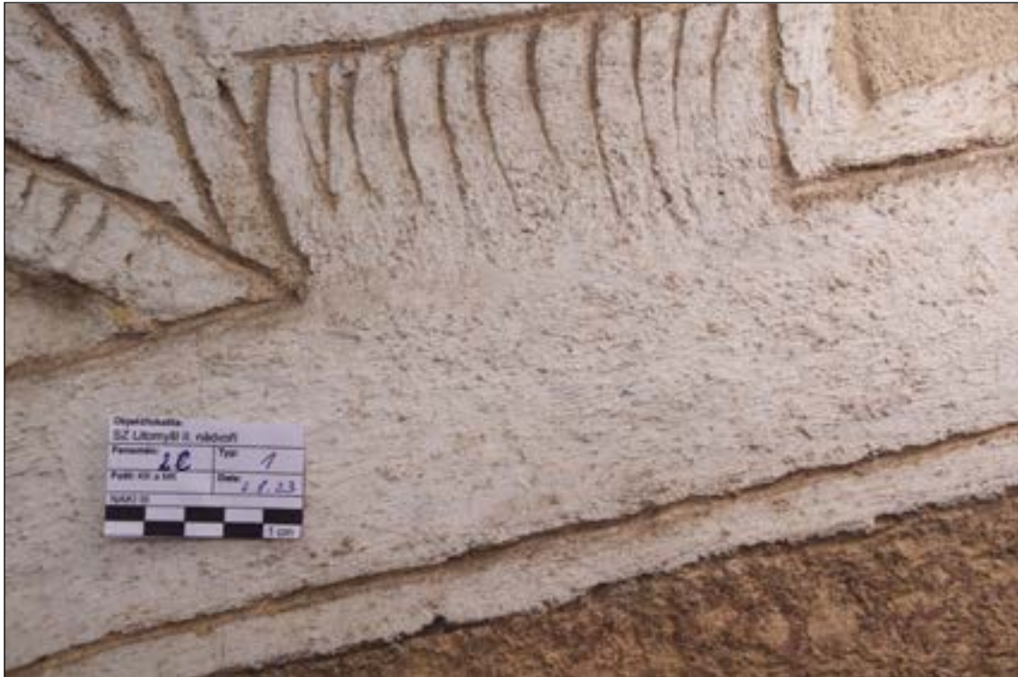
Bílý nátěr (bianco) - oprava 1984–1987 - Zoubek, Boštík, Palcr, Podhrázský (2C/1). Dle ústního sdělení účastníka restaurátorských prací Ak. soch. Arnolda Bartůňka byla receptura vápenného nátěru následující: 10 litrů vápenné kaše a 1 litr lněné fermeže a kelímek vápencové drti. V bočním nasvícení jsou dobře zřetelné tahy štětcem a drobná zrna plniva.
