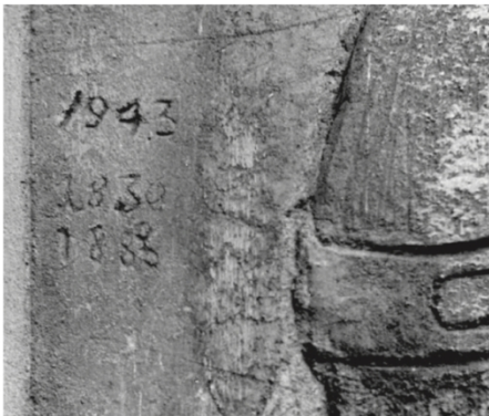
Obr. 5. Foto z restaurátorské dokumentace BOŠTÍK-PALCR-PODHRÁZSKÝ-ZOUBEK 1985, snímek č.6.
