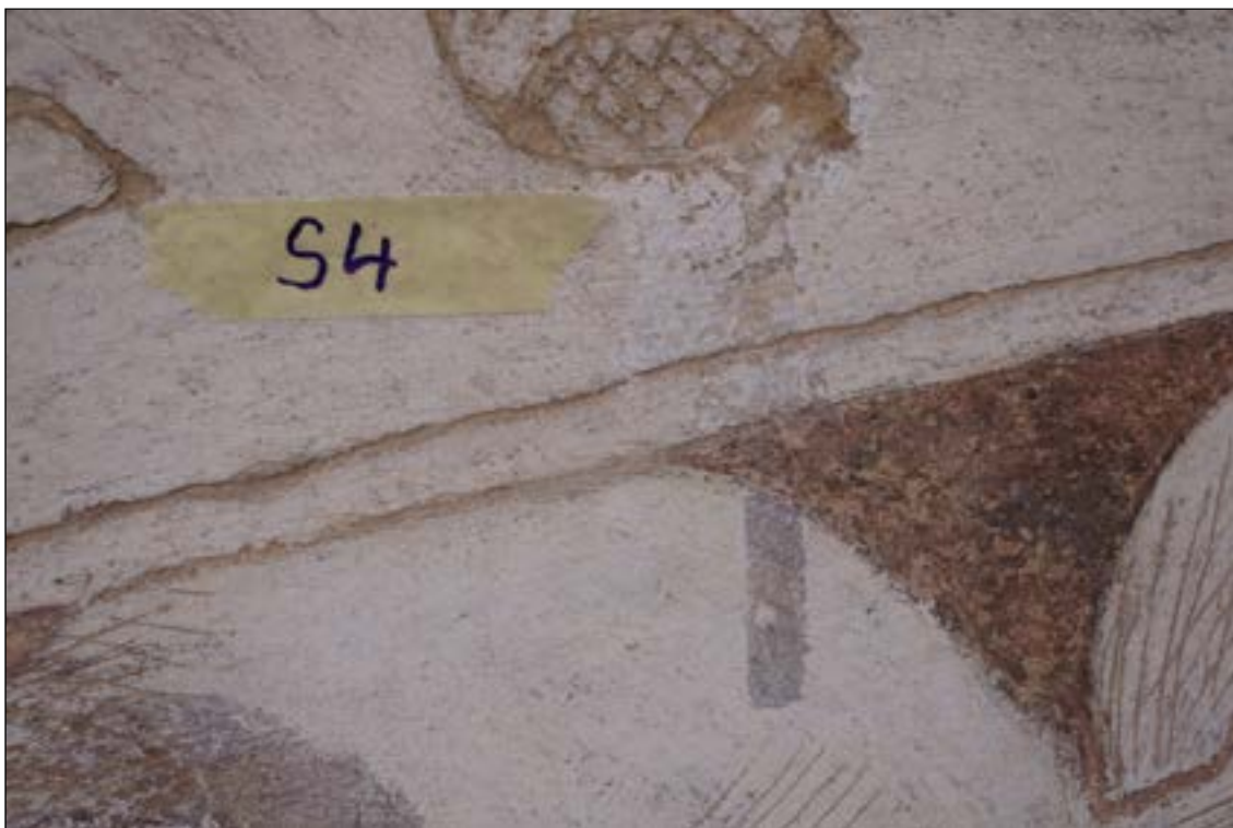
Sonda 4 - sonda na rozhraní omítek. Lovecký výjev A1c.
