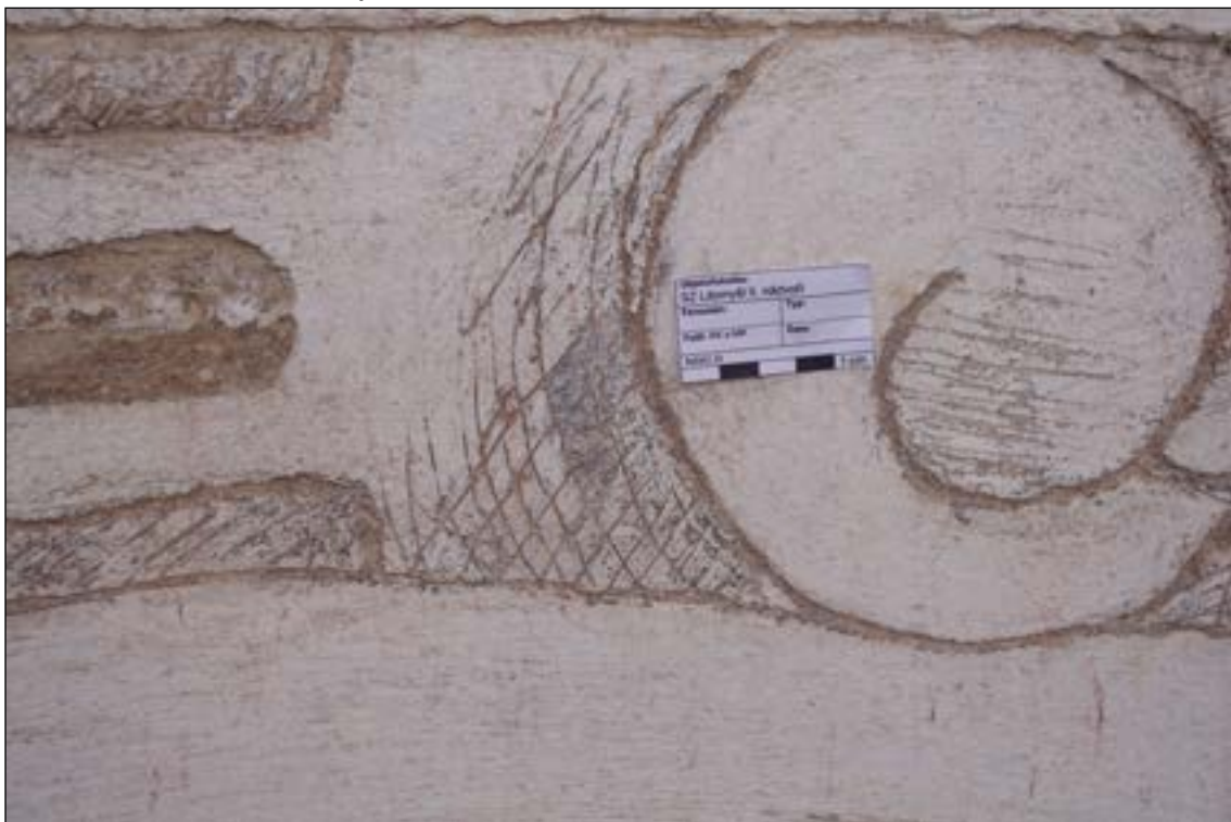
Bílý nátěr (bianco) - oprava 1984–1987 - Zoubek, Boštík, Palcr, Podhrázský (2C/1). V místech, kde byl povrch jen jemně degradován, byla nátěr proveden plošněji a byla snaha obnovit původní šrafování ve stejném místě, kde bylo viditelné před nanesením nátěru. Je však viditelné, že vzhledem k hutnosti nátěru se místa s původním stínováním ztratila a ne-bylo možné ho obnovit stejně.
