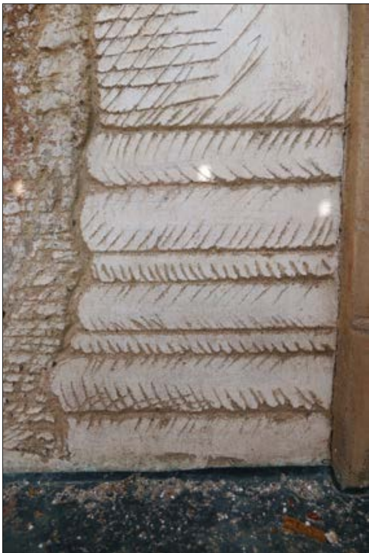
Místo zkoušky čištění párou na rekonstrukci z 80. let před jejím provedením.
