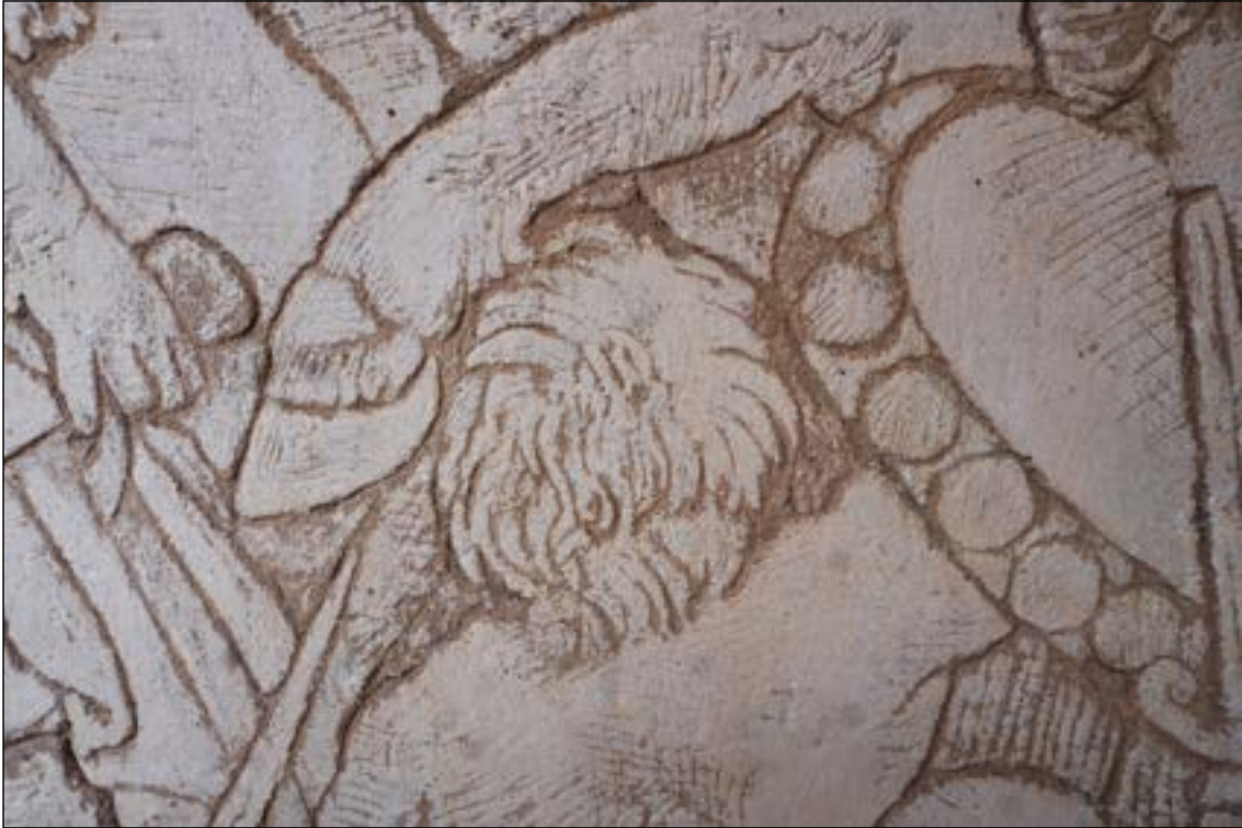
Místo zkoušky ČV6 před čištěním vodou.
