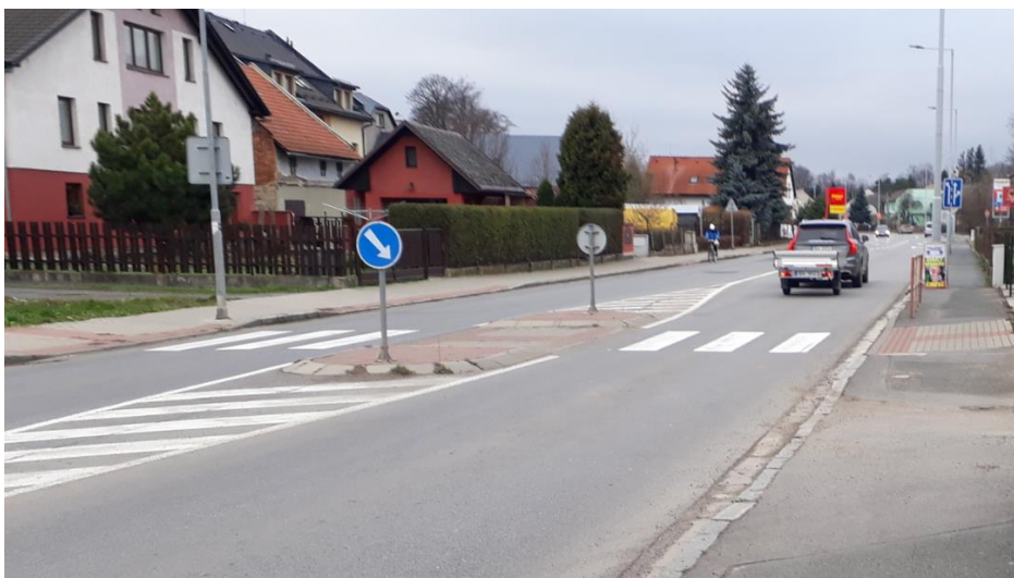
Obrázek 29 – Pěchod č. 2 východně od obchodních domů
