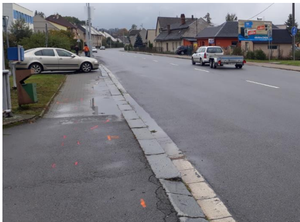
Obrázek 62 – Porucha č. 7 – Plošná deformace chodníků
