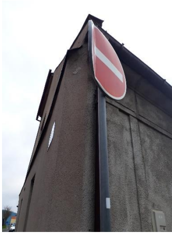
Obrázek 63 – Porucha č. 8 – Deformované SDZ
