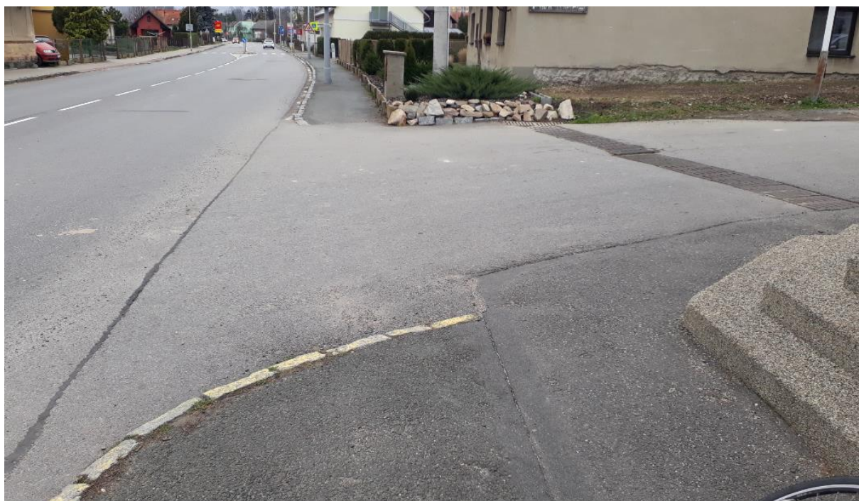
Obrázek 25 – Hegerova ulice – Účelová komunikace na východním konci města
