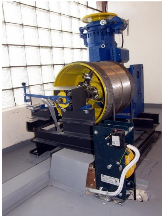
Obr. 1.2 – Bubnový výtah (MSV výtahy a.s., 2021)
