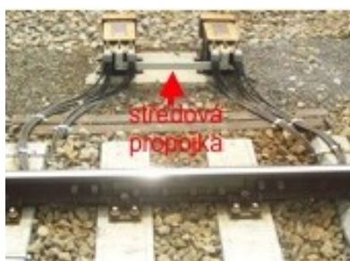
Obrázek 5 - Použití dvoupáskových KO s použitím stykového transformátoru [1]
