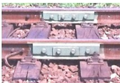
Obrázek 3 - Ukázka izolovaného styku [1]
