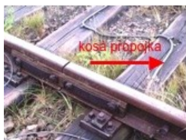
Obrázek 4 - Použití jednopáskových KO pomocí kosé spojky [1]
