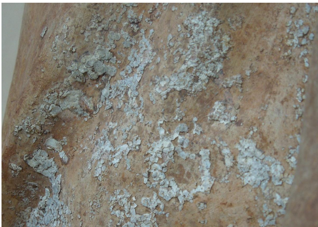
Obrázek 44 – stejné partie po zajištění fragmentů barevnosti zažehlením a konsolidací
