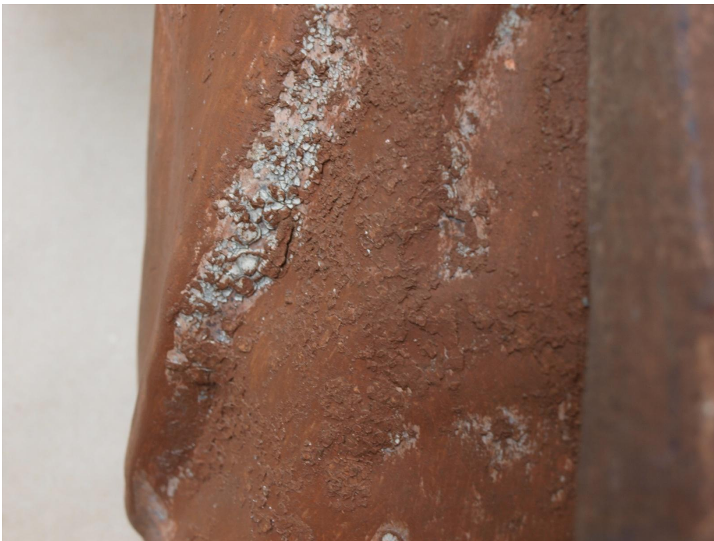
Obrázek 34 – detail fragmentů starších (původních) povrchových úprav a posledního červenohnědého nátěru
