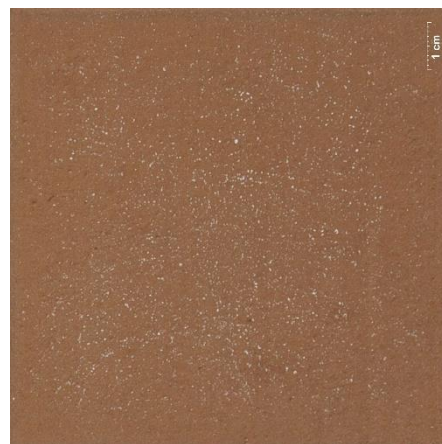
Pole D3 po zpevnění
