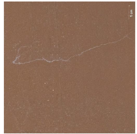
Pole D4 po zpevnění
