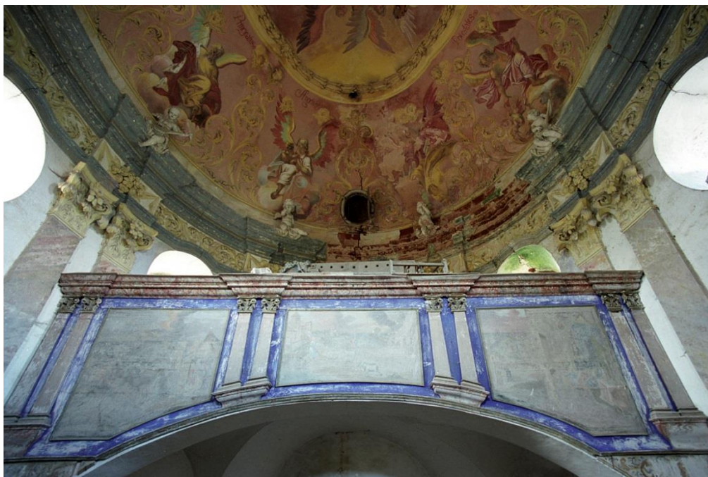
Obr. 26: Pohled na západní část kaple sv. Isidora v Křenově a kruchtu, kde vy minulosti docházelo k masivnímu zatékání dešťové vody a ztrátě barevné vrstvy a omítek. Autor: J. Švadlenka, 2003
