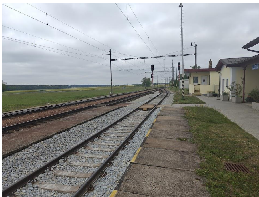
Obrázek č. 4 - ŽST Doňov Zdroj: Fotoarchiv autora práce
