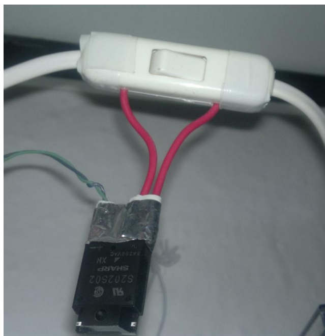
Obrázek 19 - Vypínač pochůzkového osvětlení pokoje s SSR (zdroj: vlastní)
