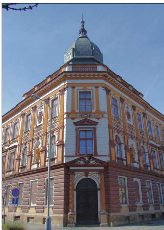
Obr. 8 - Pohled na nároží budovy bývalé státní průmyslové školy, dnes Fakulty chemicko-technologické na náměstí Legií v Pardubicích.
