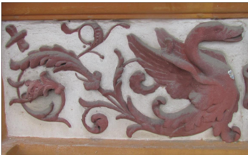
Obr. 64 - Vrstvy nátěrů zcela zaslepují plasticitu a jemné detaily reliéfu, navíc působí „plochým dojmem“ jako malba.
