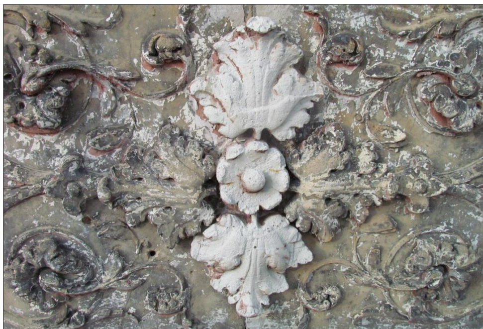
Obr. 65 - Sekundární doplnění reliéfu z románského cementu odlitky částí ze sádry.
