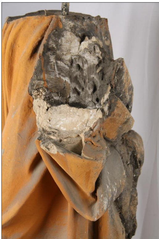
Obr. 33 - Vztyčná plocha pro levou paži plastiky, stav před restaurováním.
