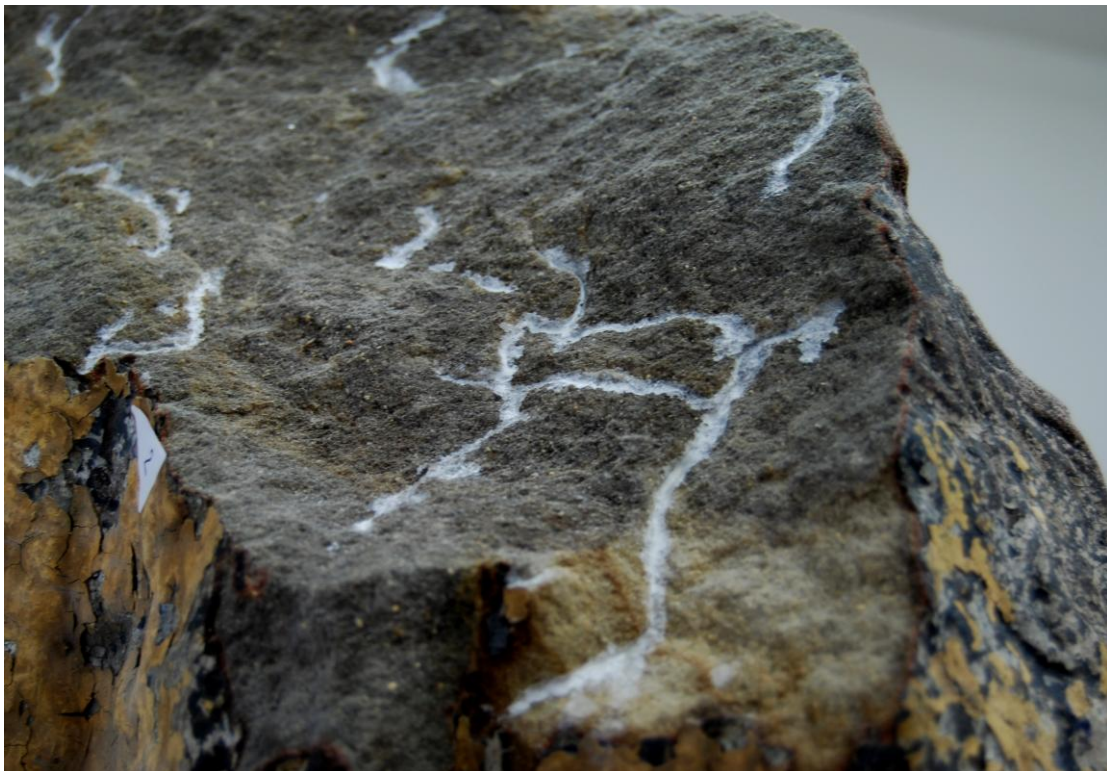
Obr. 15 a 16- Injektáž a zpevňování lomových ploch s trhlinami pomocí organokřemičitanu Remmers KSE 100, 300 a 500 E. Injektáž-KSE 500 E+ Füllstoff A+B (2:3).
