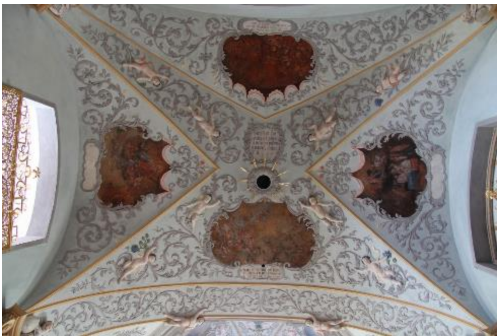
Obrázek 130- celkový pohled do klenby západní části presbyteria. Stav po restaurování v roce 2013. Zdroj: BARTŮŇKOVÁ, Lucie, VOJTĚCHOVSKÝ, Jan. Restaurátorský průzkum a dokumentace: Restaurování nástěnných maleb v kupoli presbytáře, Restaurátorská dokumentace, Litomyšl 2013
