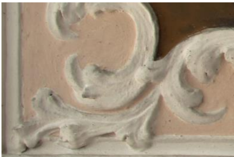
Obrázek 201 – Detail štukového pole pod výjevem Klanění pastýřů. Stav před odkrytím druhotných nátěrů.
