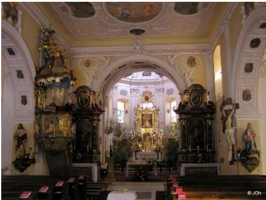
Obrázek 126 – celkový pohled z hlavní lodi směrem k prostoru presbyteria. Po levé a pravé straně jsou patrné části vítězných oblouků bočních kaplí, které korespondují s vítězným obloukem kněžiště.
