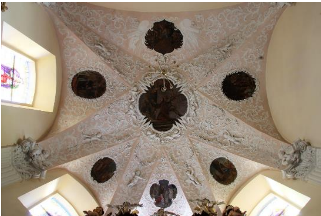
Obrázek 134 – celkový pohled do klenby prostoru kaple sv. Václava. Stav před restaurováním. Základní rozvržení prostoru stropu je shodné s kaplí sv. Josefa (obrázek dole). Charakter štukové výzdoby je bohatší, pod výjevy navíc chybí zrcadla s nápisy.
