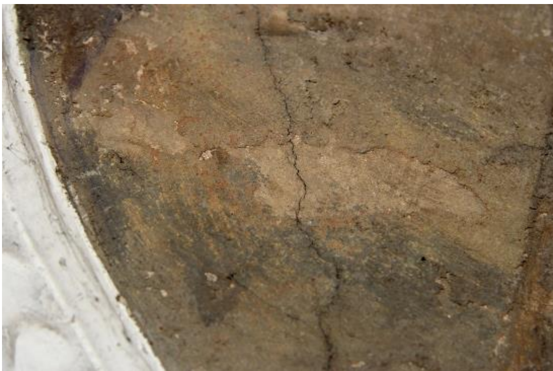
Obrázek 161 – Dokumentace poškození, dolní levá část pozadí výjevu Sv. Josefa a mladý Ježíš nesoucí Arma Christi. Detail mikroprasklin, které se vyskytovaly zejména ve spodních částech obou výjevů v klenbě kaple. Na této fotografii je také dobře vidět rozhraní mezi přemalbou a originální barevnou vrstvou.
