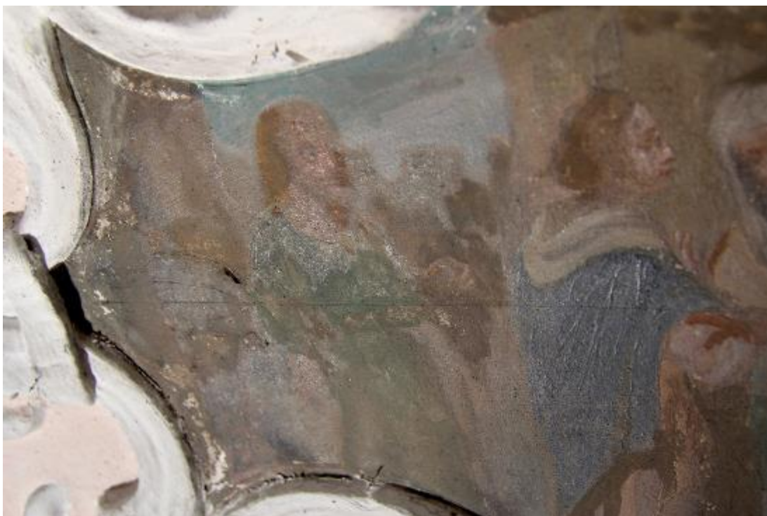
Obrázek 164 – Dokumentace poškození, detail levé poloviny výjevu Navštívení Panny Marie. Tato fotografie v bočním nasvícení odhaluje charakter původní malby, která vzhledem ke své technice provedení (olejomalba) odráží světlo pomocí lesků a je nanášena v silnější vrstvě, která se v tomto světle jeví plasticky. Také je dobře patrná rytá kresba, kterou si štukatěři rozvrhovali plánované umístění štukových částí rámu malovaného zrcadla, které nakonec nebylo v tomto případě realizováno.
