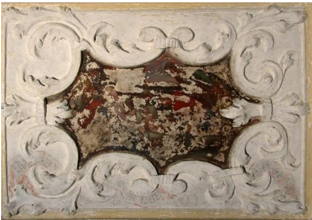
Obrázek 174 - Dokumentace průběhu restaurování. Klanění pastýřů. Celkový pohled. Stav po očištění a sejmutí přemaleb.
