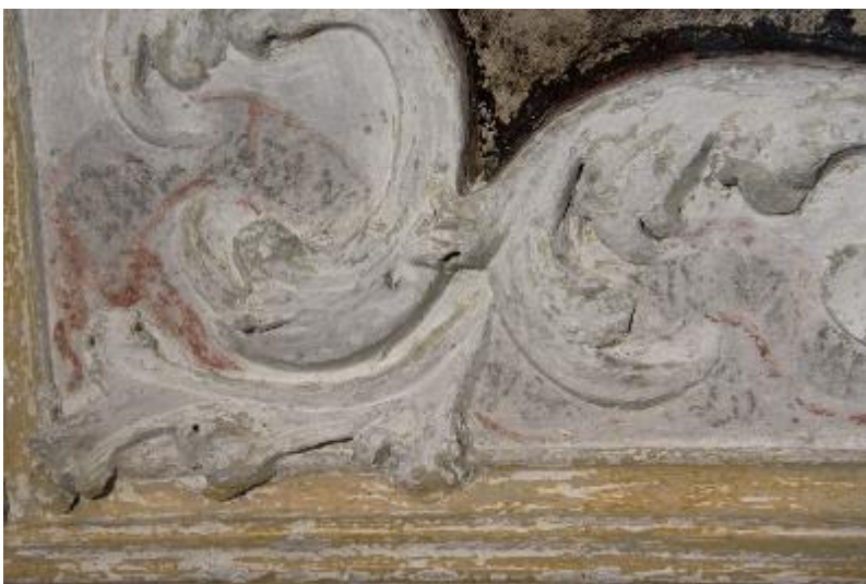
Obrázek 202 - Detail štukového pole pod výjevem Klanění pastýřů. Stav po odkrytí druhotných nátěrů.
