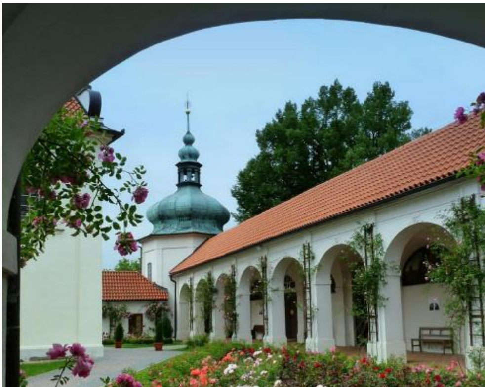
Obrázek 133 – pohled směrem od severního vchodu do areálu na ambitovou chodbu s lunetovými nástěnnými obrazy.
