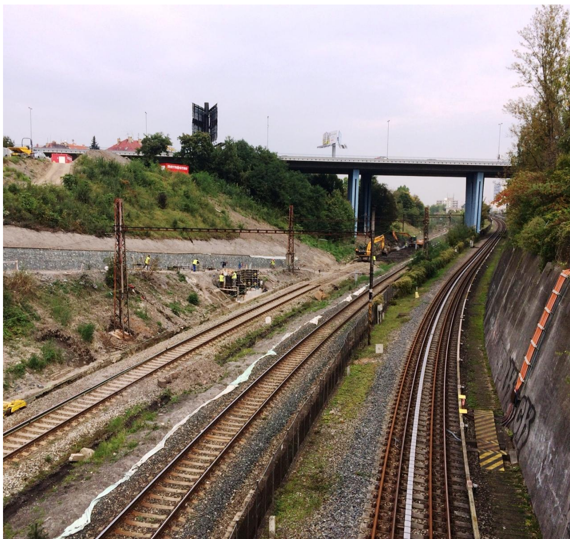
Obrázek 4: Výstavba železniční zastávky Praha-Kačerov v září 2014
