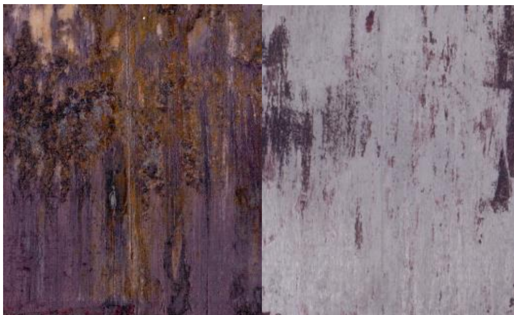
Obrázek 32: Nátěr Košenily po zrychlené korozní cyklické zkoušce
