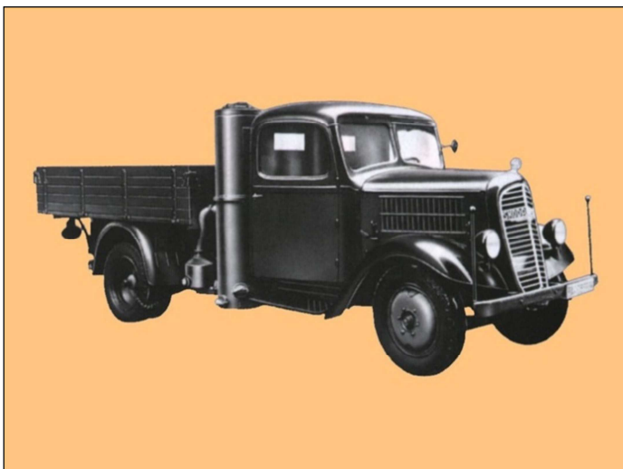
Obr. č. 4.6 Nákladní automobil vybavený kotlem na dřevoplyn (výrobce Dokogen, dnešní Atmos)
