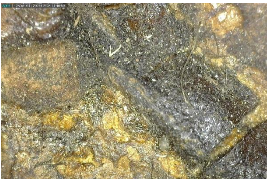
Obr. 48: Stav před restaurováním, detail poškození, USB mikroskop
