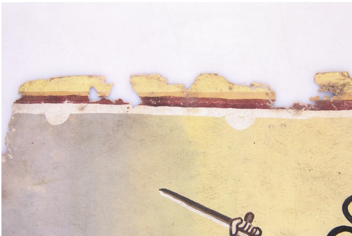
Obr. 87 – Stav před restaurováním, detail, VIS, lícová strana
