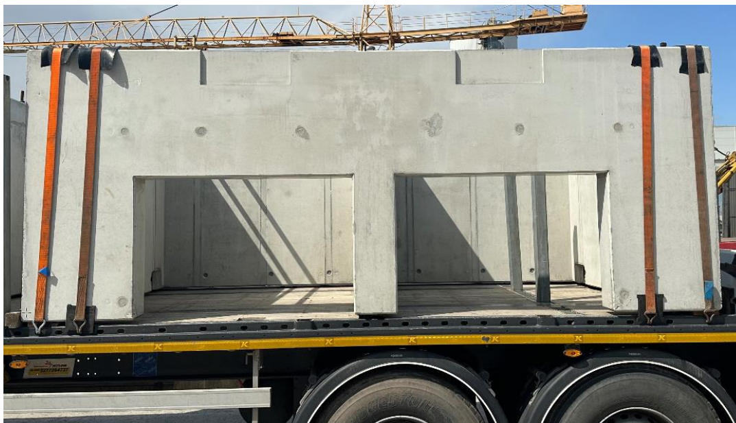
Obrázek č. 31 Správné uložení výtahové stěny B
