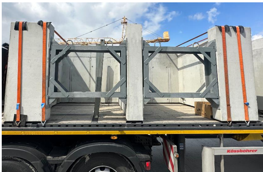
Obrázek č. 30 Správně upevněná výtahová stěna A Zdroj (autor)
