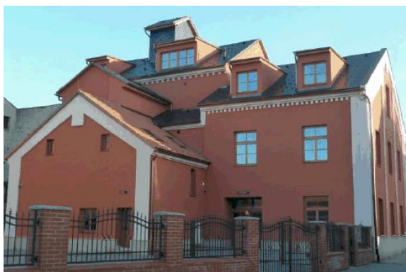
Obrázek 19: Areál po revitalizaci na multifunkční podnikatelskou nemovitost
