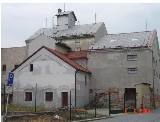
Obrázek 18: Areál bývalé sýpky pivovaru Moravská Třebová před revitalizací
