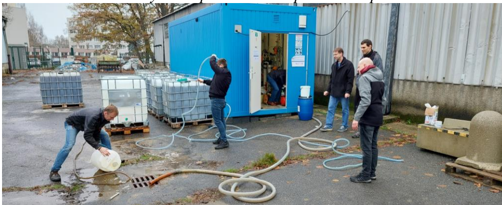
b) Příprava k čerpání OV WWW3 z Glanzstoff Bohemia s.r.o. z IBC kontejnerů
