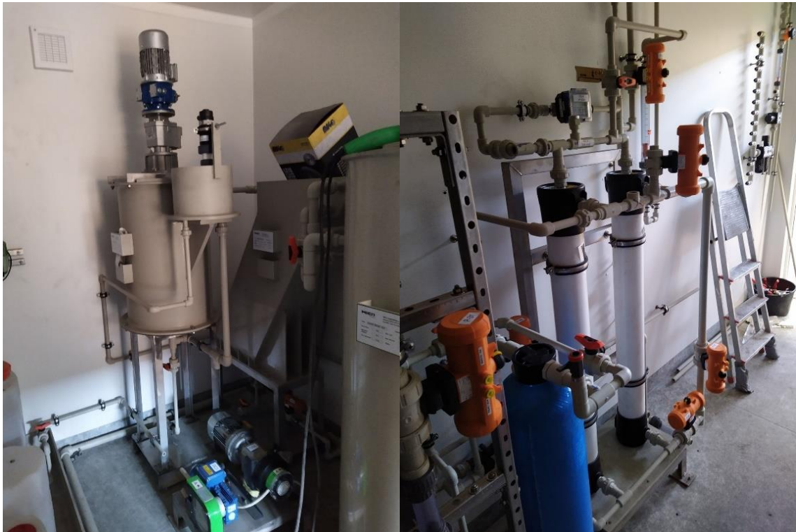
a) Montáž čířícího modulu
