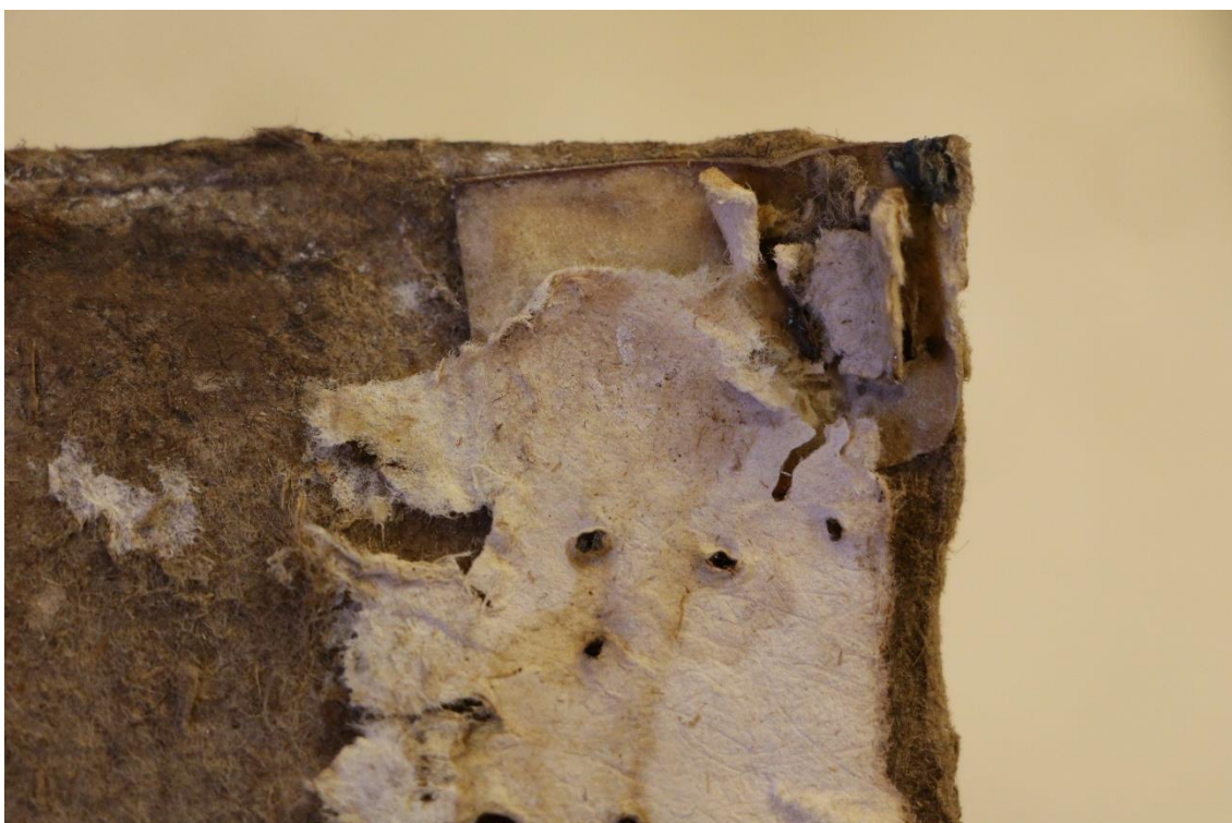
Obr. 63 Odtržený konec nosiče kapitálku na přidešti
