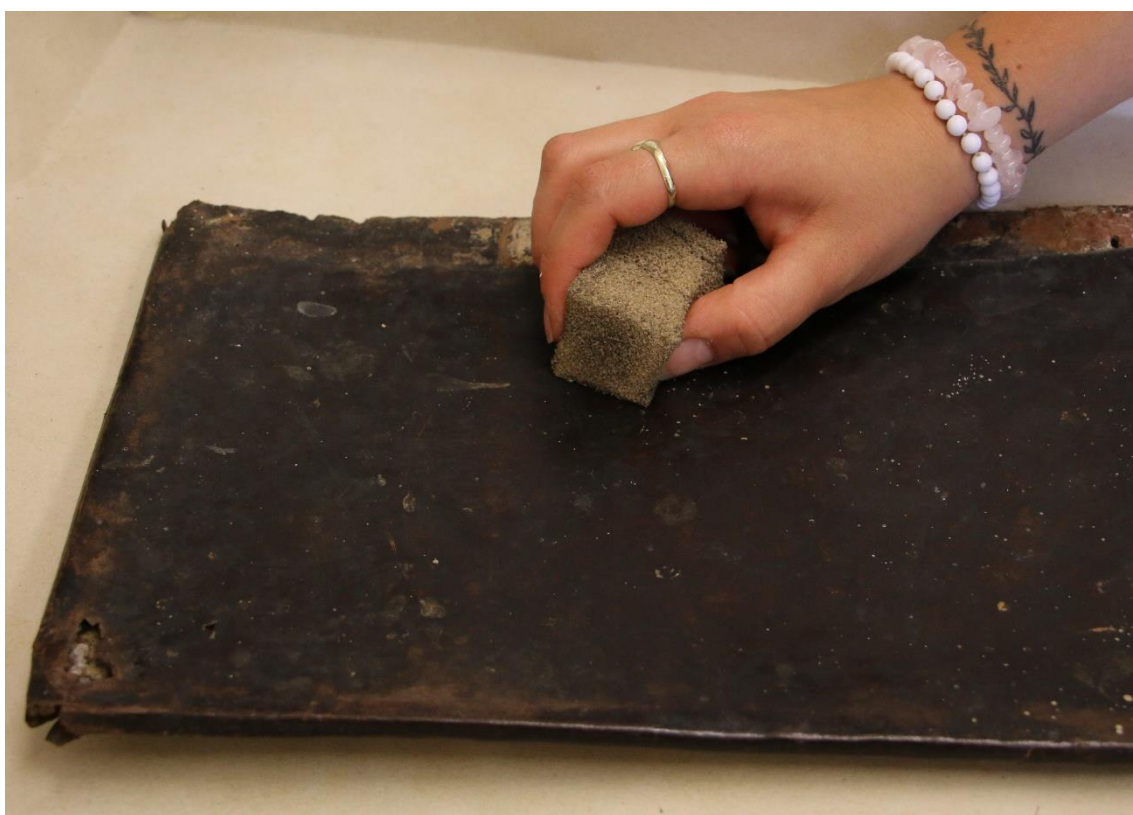
Obr. 91 Mechanické čištění pokryvu
