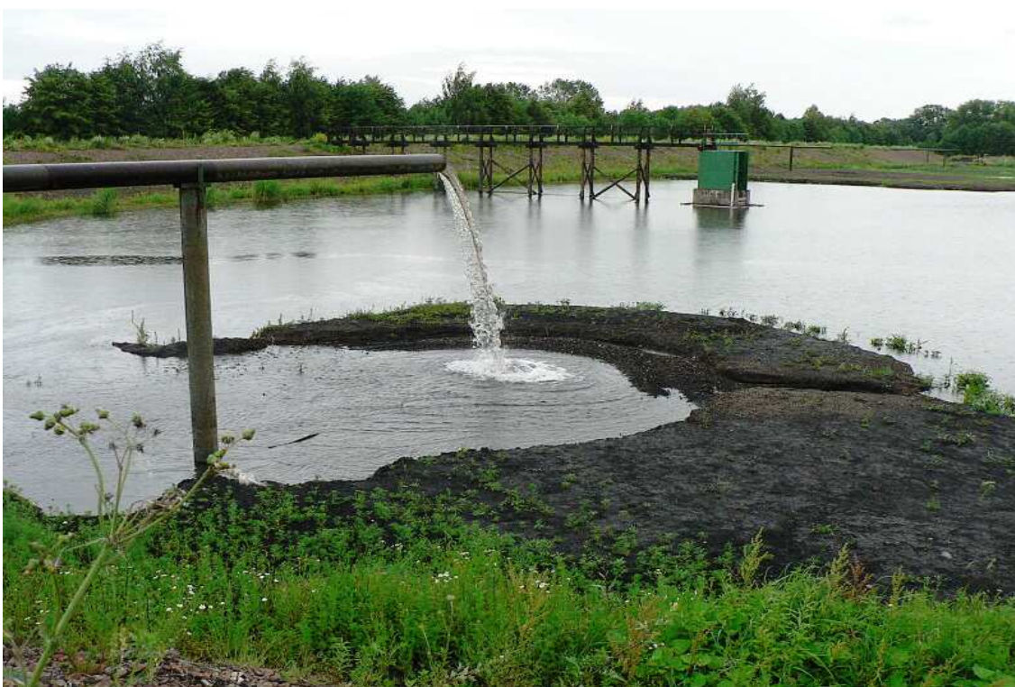
Příloha č.2: Odkaliště IV/2 – pohled na východní část hráze s přelivnou věží P1 a provozovaným výtokem hydrosměsí
