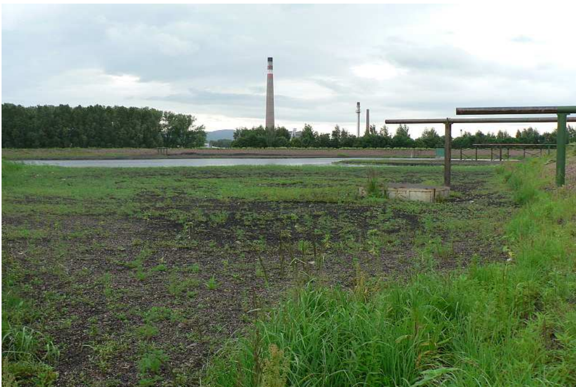
Příloha č.4: Odkaliště IV/2 – pohled na západní část odkaliště ( v pozadí je teplárna )
