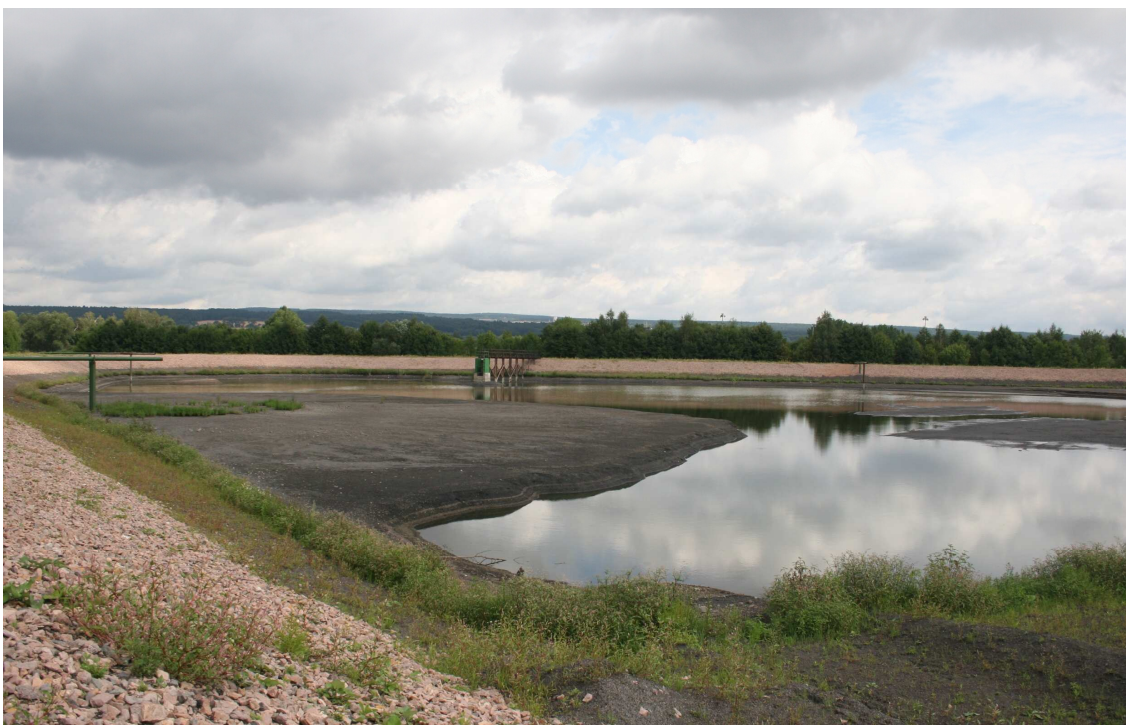
Příloha č.1: Odkaliště IV/2 – pohled na severní část hráze
