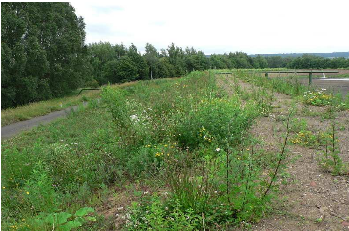
Příloha č.3: Odkaliště IV/2 – pohled na jednotlivé stupně západní části hráze odkaliště
