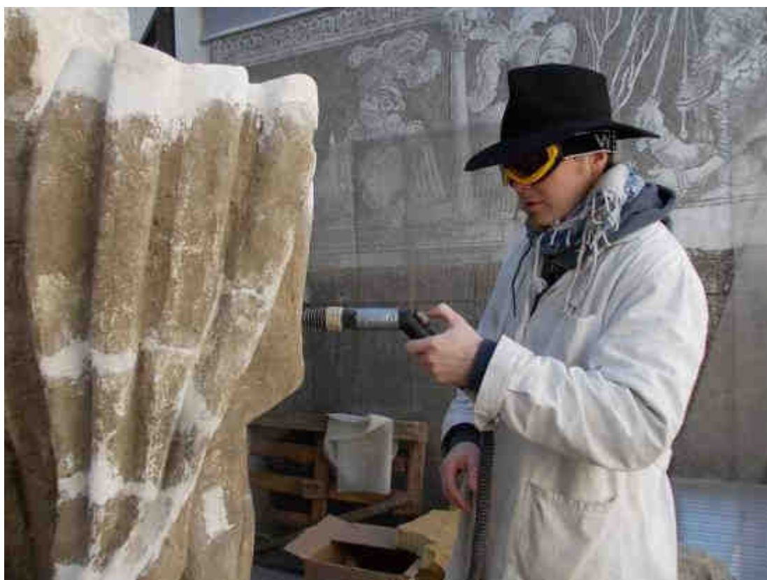
35. Restaurátor při čištění regulovatelnou vodní parou
