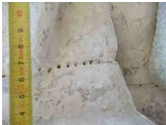
54. Postupné odvrátání chybného spoje tamtéž
