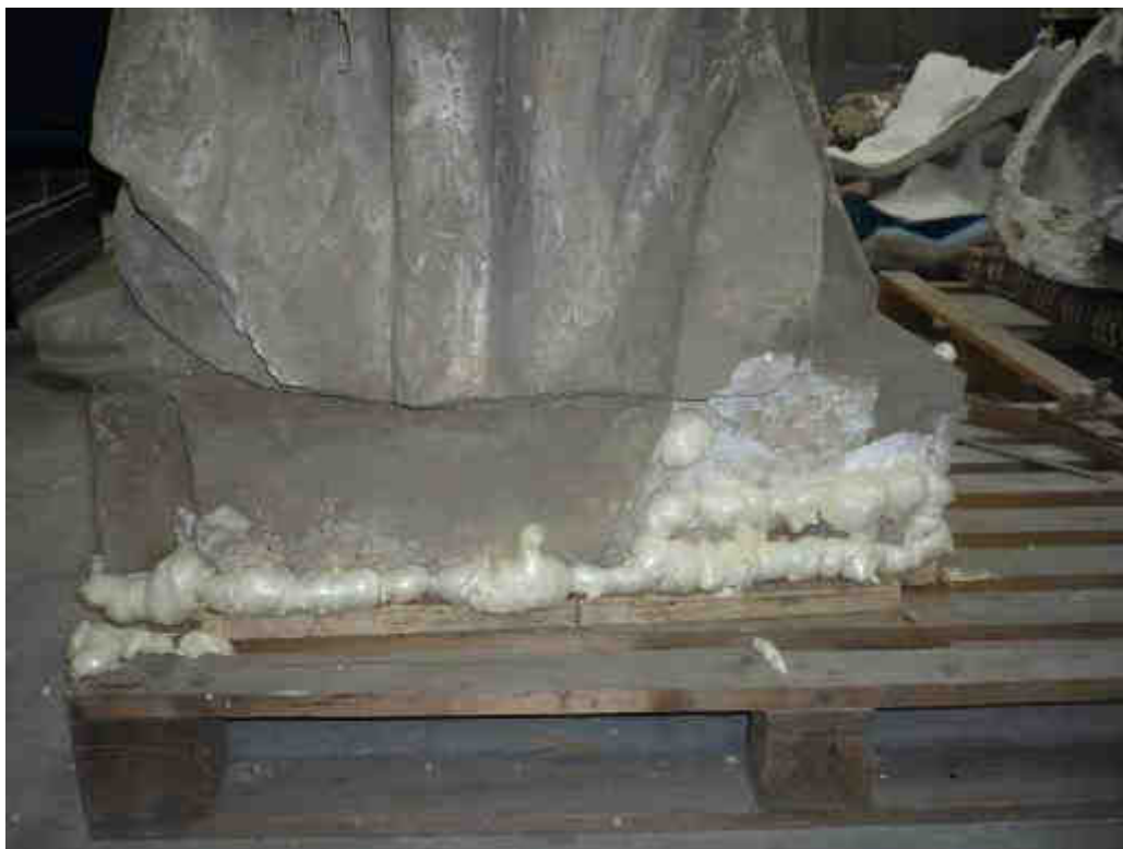
14. Expanze PU po zpevnění, přichycení plintu Sv. Mikuláše k podstavné desce
