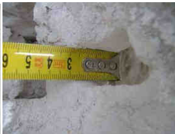
21. Síla odlitku ve vyvrtném otvoru tamtéž
