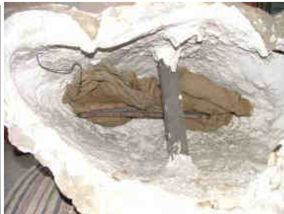
25. Zvedací mechanismus po osazení s výstelkou
