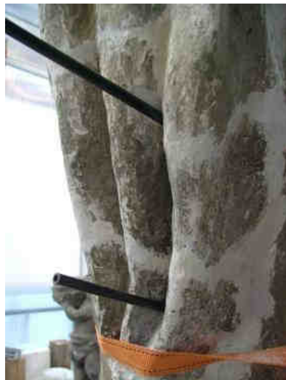
19. Zpevnění této partie armaturou
