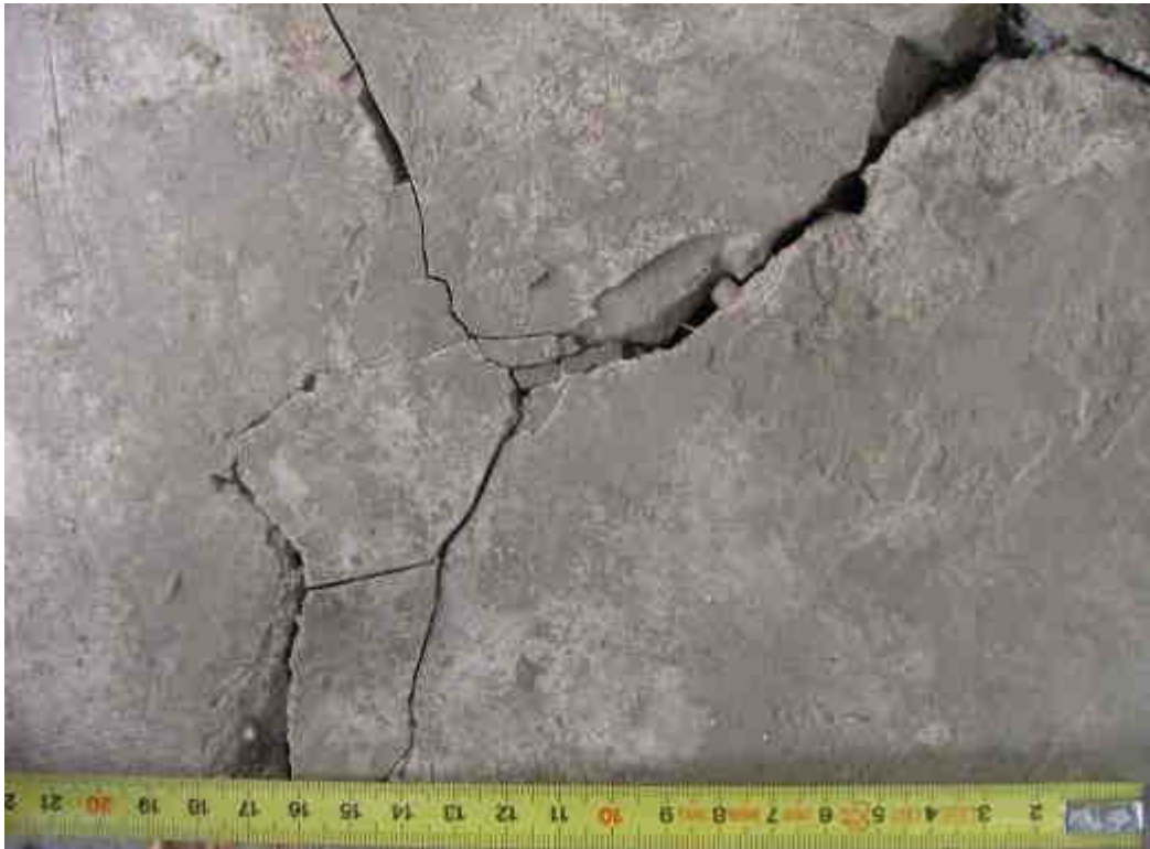
8. Dolní díl trupu Sv. Mikuláše, detail plintu – stav před restaurováním
