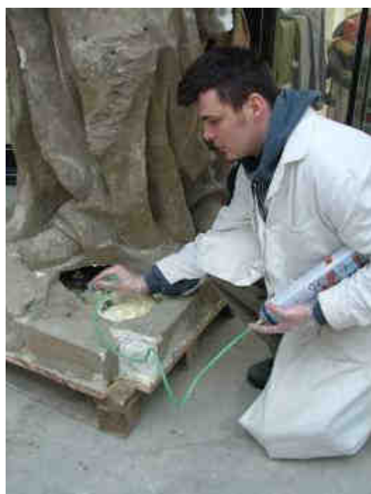
12. Zpevnění plintu Sv. Mikuláše polyuretanem 13. Expanze PU pěny
