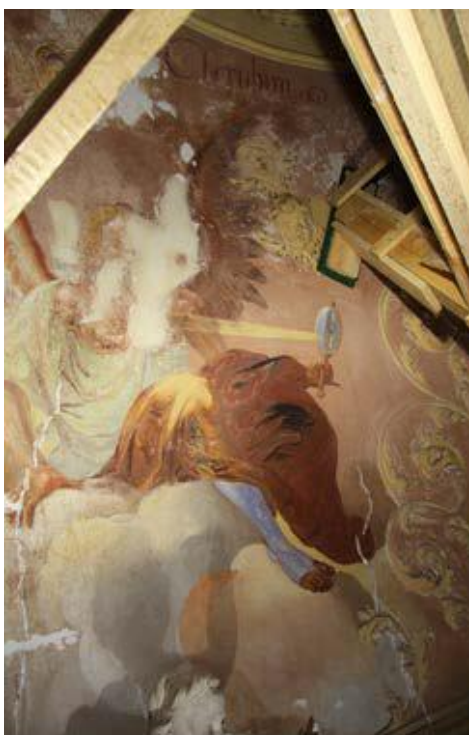
Obr. 125 Defekt v levé dolní části výjevu Cherubim, vzorek O2 (7341).
