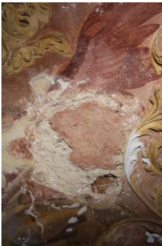
Obr. 160 Místo odběru vzorku 7575 (O3). Současný stav po odstranění tmelu z roku 2004, který překrýval druhotný tmel i okraje původní barevné vrstvy.
