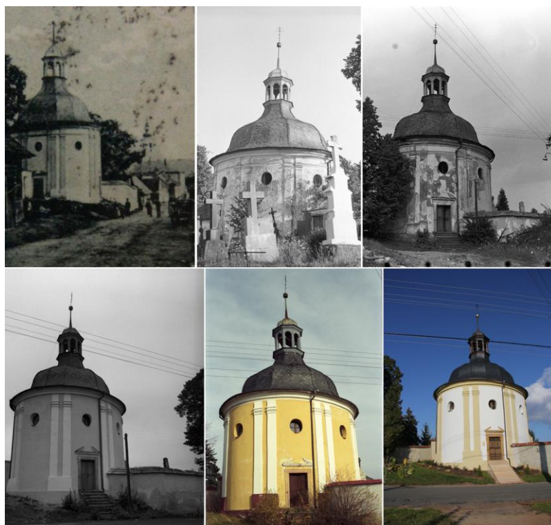
Obr. 34: Proměny vnějšího pláště kaple od počátku dvacátého století po současnost. Horní řada zleva: počátek 20. století (pohlednice), 50. nebo 60. léta (foto z archivu NPÚ, autorka Plecháčková), rok 1964 (foto z archivu NPÚ, autor Sacher); spodní řada zleva: rok 1973 (foto z archivu NPÚ autor Černík), rok 1996 (foto z archivu NPÚ, autorka Neumeisterová), rok 2014.
