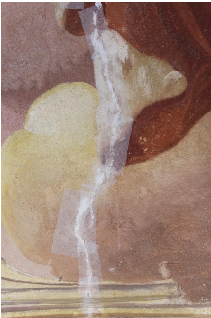
Obr. 71: Největší trhlina v malbě anděla. Zajištění uvolněného intonaca přepley z japonského papíru pojené Tylosou MH 300 .
