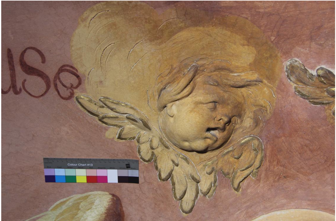
Obr. 84: Štuková okřídlená hlavička andílka, blíže k andělskému kůru Angeli. Stav po restaurování.
