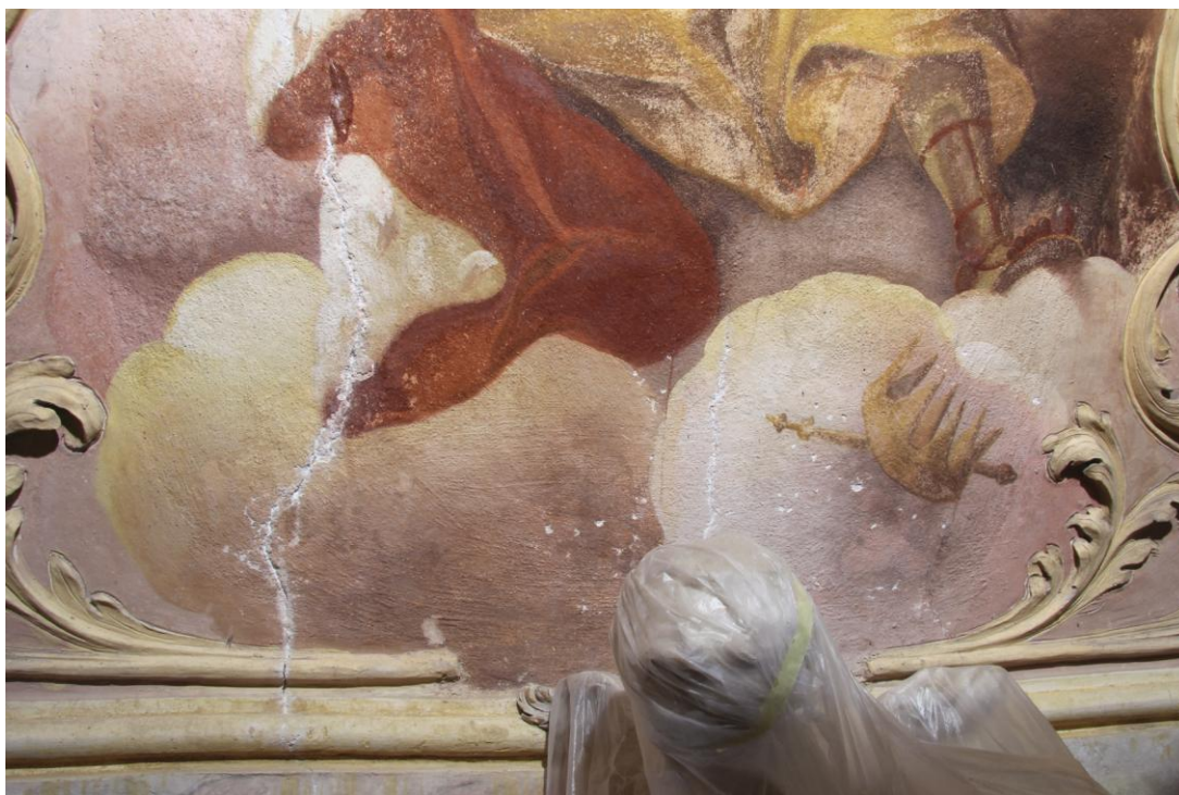
Obr. 73: Andělský kůr Principatus - spodní část vymezeného úseku. Stav po zpevnění a očištění.
