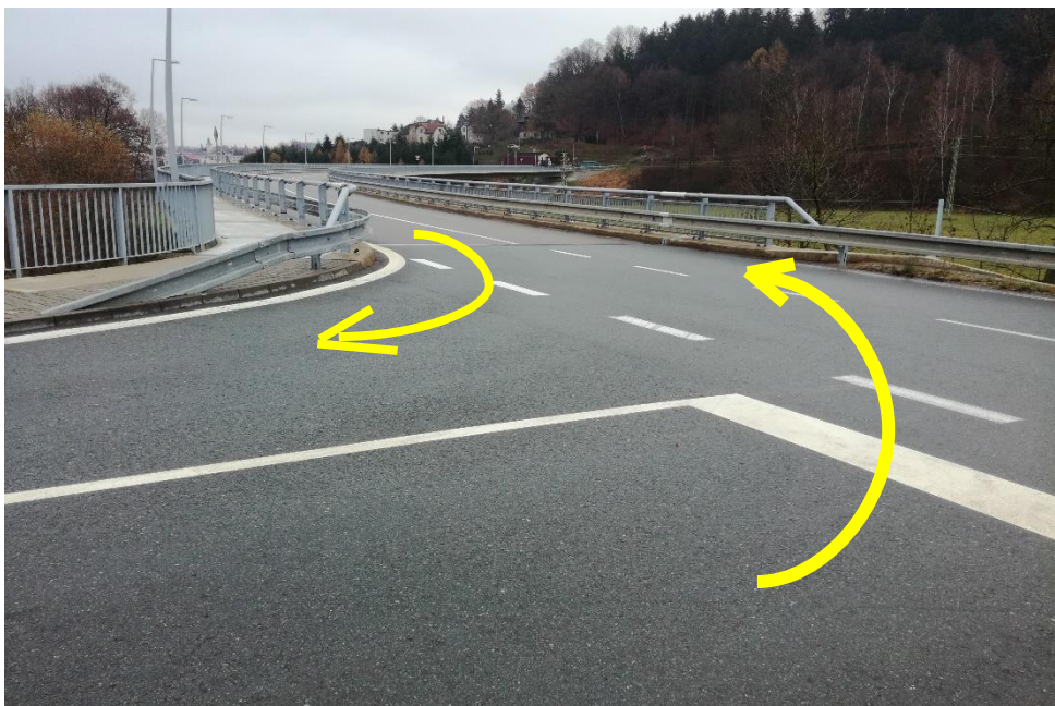
Obr. 48 Malý prostor na křížení komunikace s ulicí Sokolská Zdroj: foto a úprava autorem
