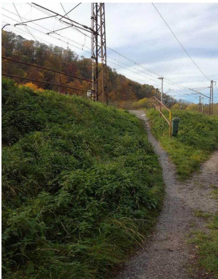
Obr. 43 Přístupová cesta na nástupiště Brandýs nad Orlicí
