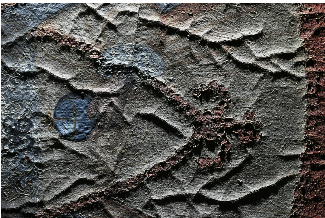
Obr. 20 Stav před restaurováním, razantní boční nasvícení, líc, detail krakeláže
