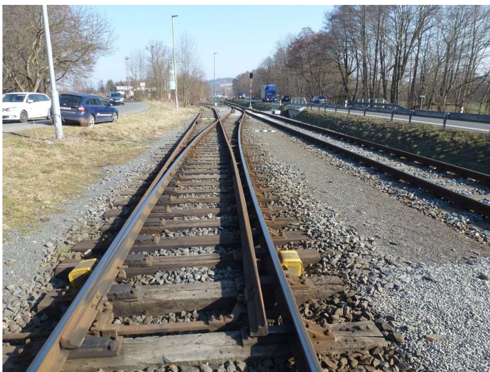
Obrázek 12 - Výhybna Střítež nad Bečvou - výhybka č. 2
