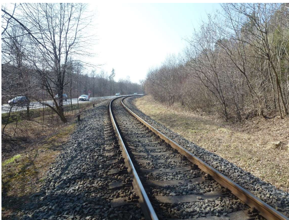
Obrázek 6 – Směrový oblouk č. 17 o poloměru 234 m
