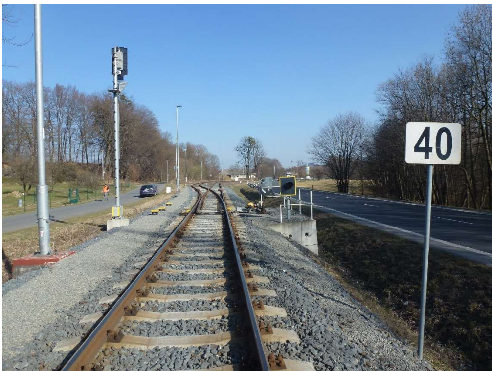
Obrázek 11 - Výhybna Střítež nad Bečvou - výhybka č. 3
