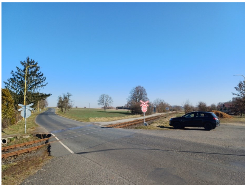
Obrázek 29 Železniční přejezd na začátku obce směrem od Krabčic (autor, 2025)
