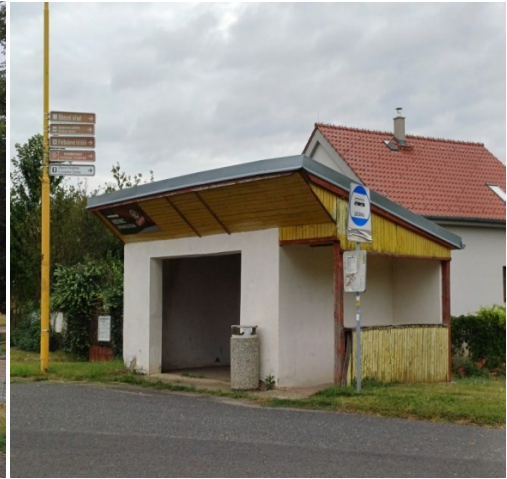
Obrázek 26 Autobusová zastávka na začátku obce od Krabčic 2 (autor, 2025)
